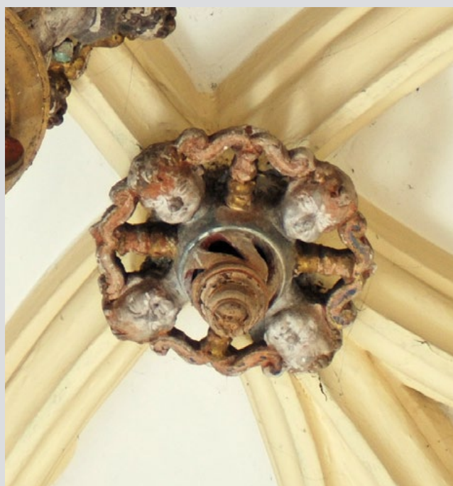
Palencia. Convento de San Francisco. Capilla de San Ildefonso Bóveda
