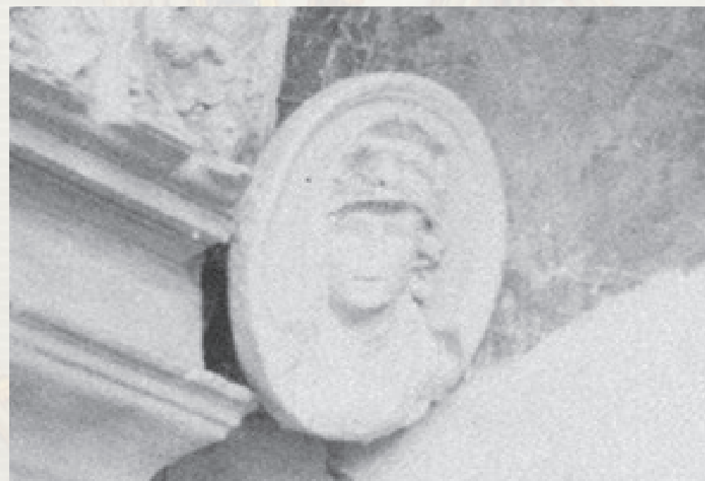
Detalle del medallón reubicado en la bóveda del sotocoro de Santa María la Antigua
