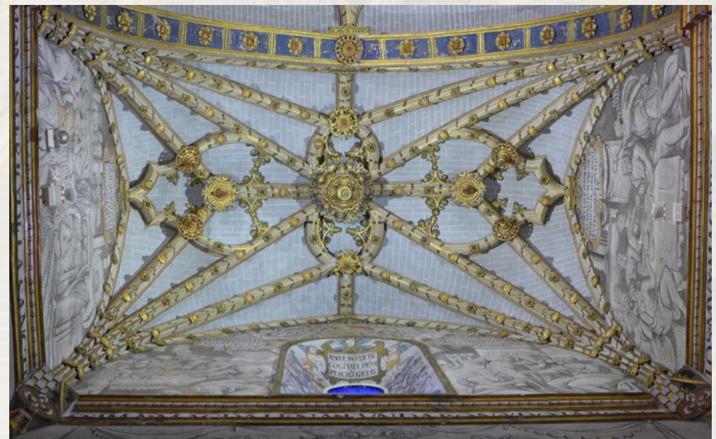
Bóveda del crucero norte
