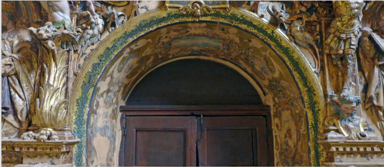
Acceso a la capilla de los Benavente y dos de los arcosolios
