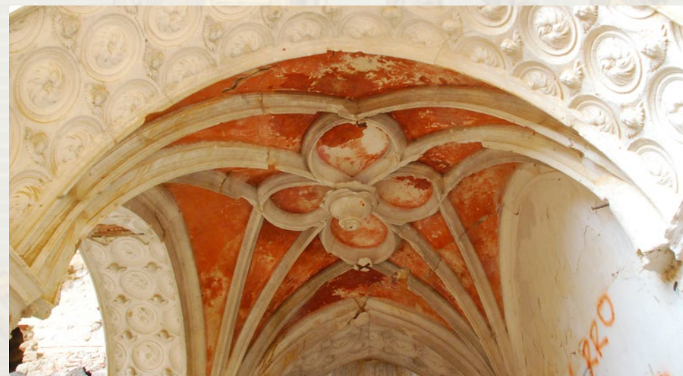
Bóveda del primer tramo
