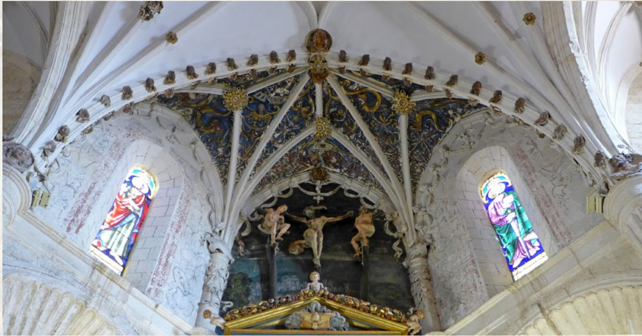
Bóveda de la capilla mayor y ornatos del testero
