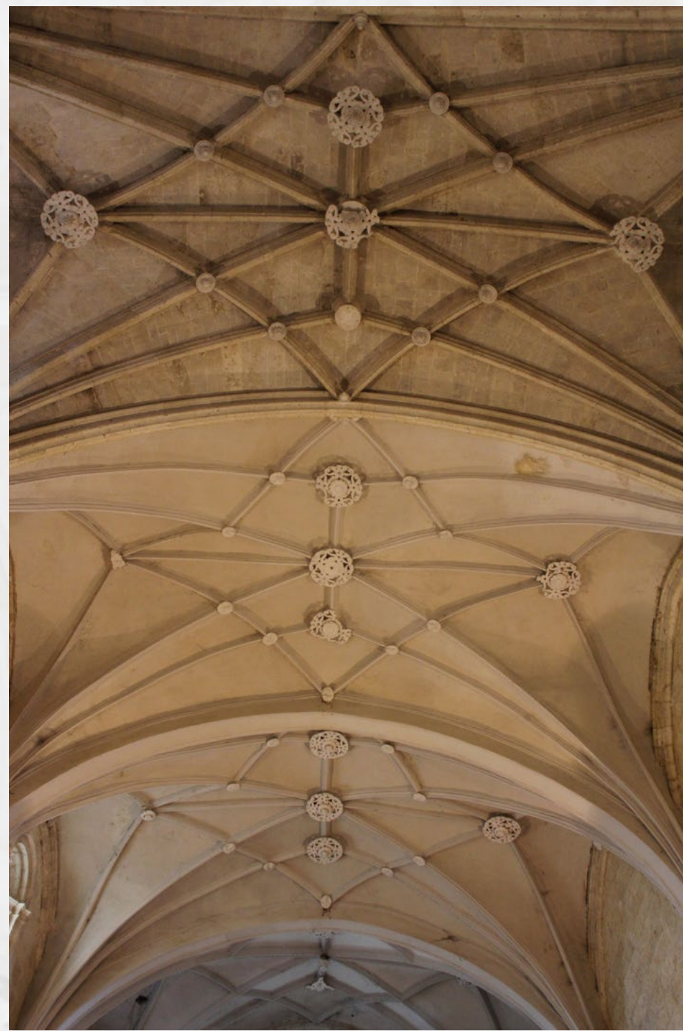
Bóvedas de crucería de Villanueva de San Mancio. A la izquierda se muestran las cubiertas de la capilla mayor y del primer tramo de la nave, realizadas con cantería. Esta última (derecha) impone el tipo formal que se repite en las tres restantes de la nave, en este caso de ladrillo
