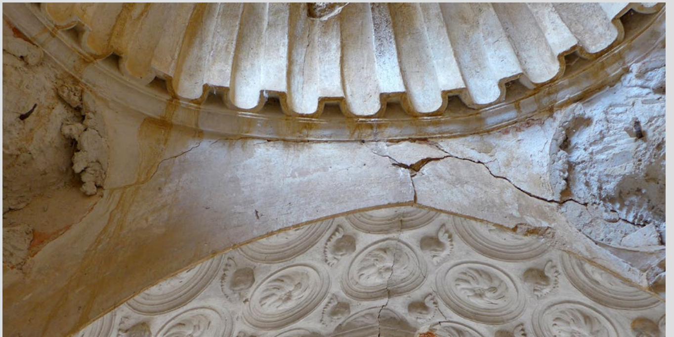
Quintanilla del Monte. Iglesia de Nuestra Señora de la Asunción Zona baptisterial. Anclaje metálico de medallones desaparecidos
