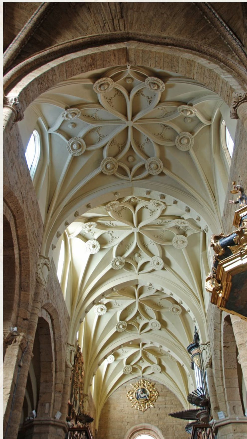
Bóvedas de la nave central (desde la cabecera)
