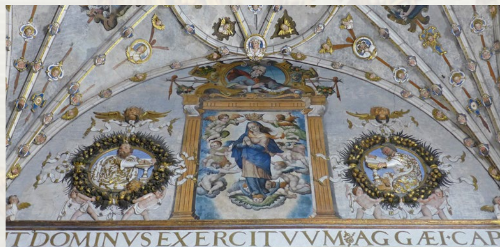
Detalles de la bóveda y muro de la Epístola. Medallones, claves y pinturas
