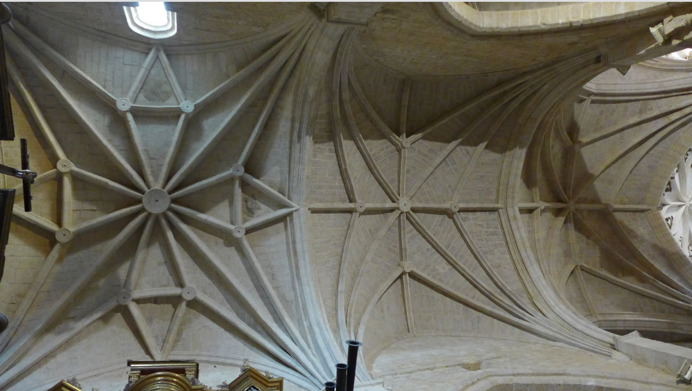
Nave principal (bóvedas preexistentes decoradas por los Corral y hoy repicadas y desprovistas de sus claves y ornatos)
