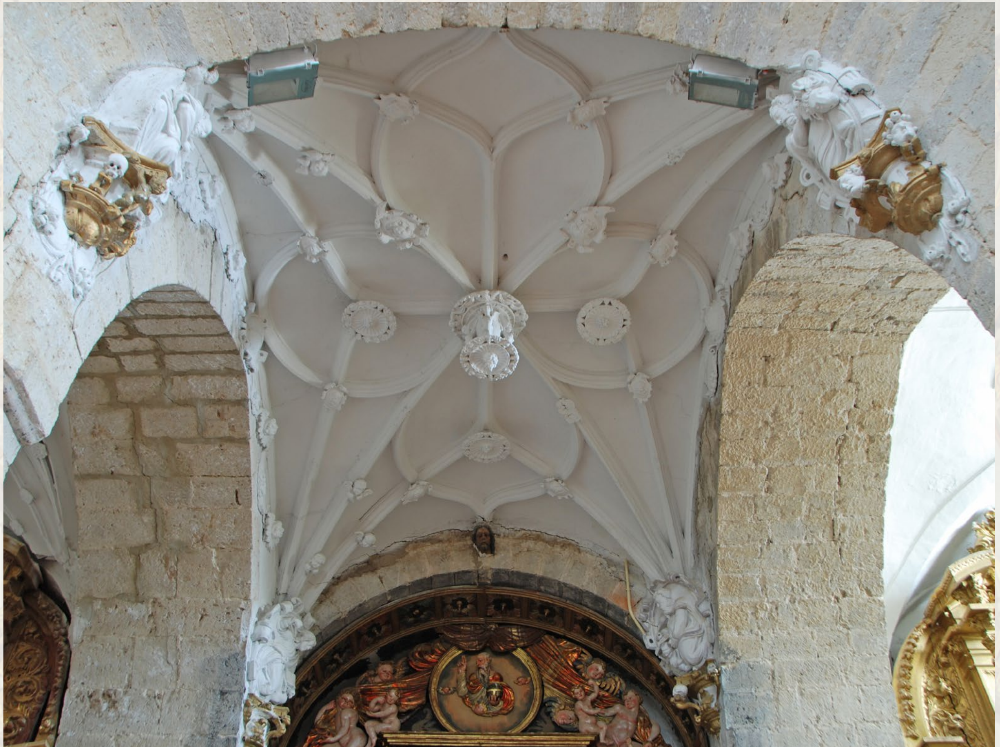
Vista general de la bóveda de la capilla mayor
