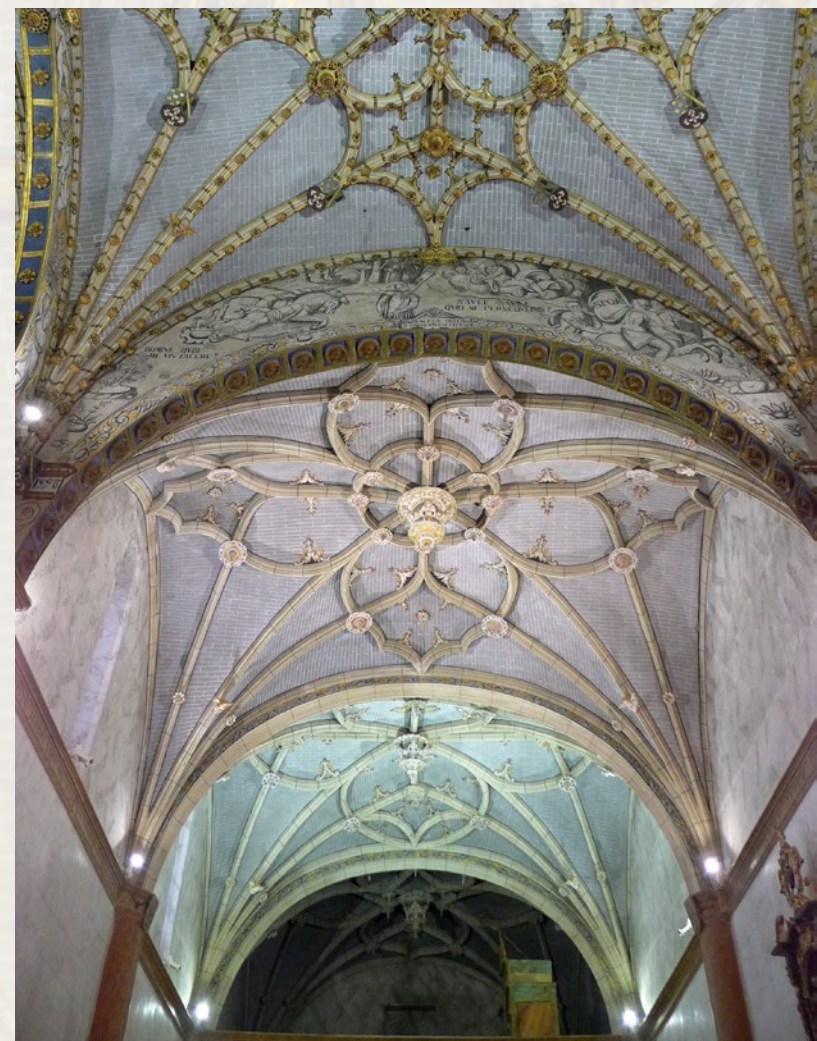
Bóvedas de la nave y del coro (desde la cabecera)
