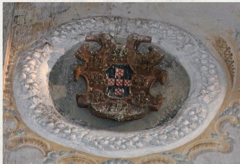
Bóveda del coro bajo
