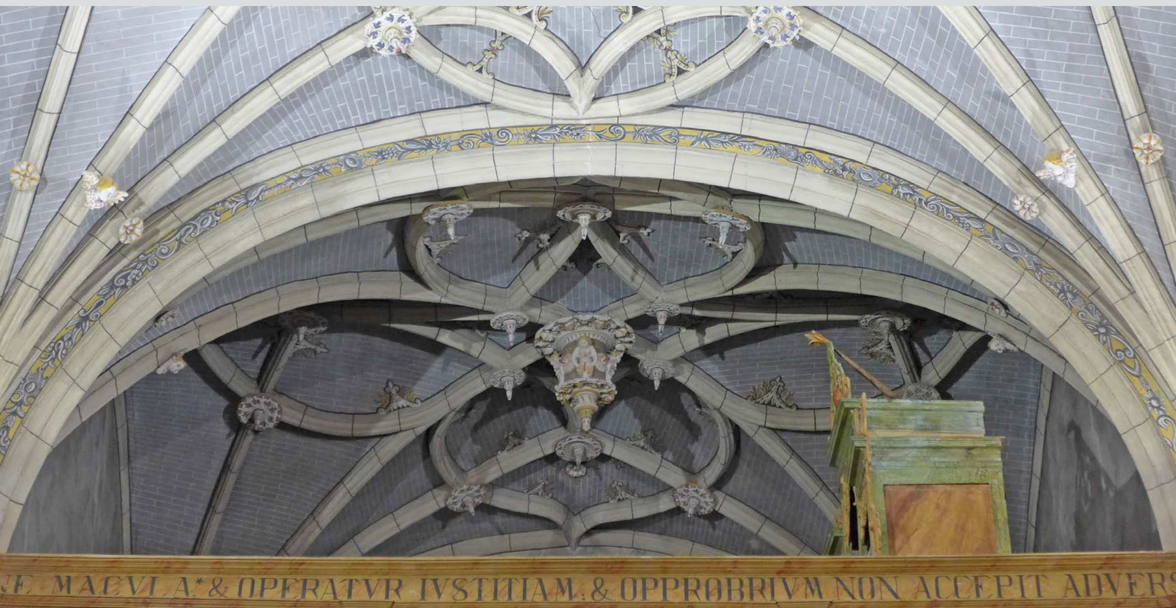
Coro alto (en nuestra opinión no será obra de los Corral, aunque pudo ejecutarse sobre proyecto corraliano)
