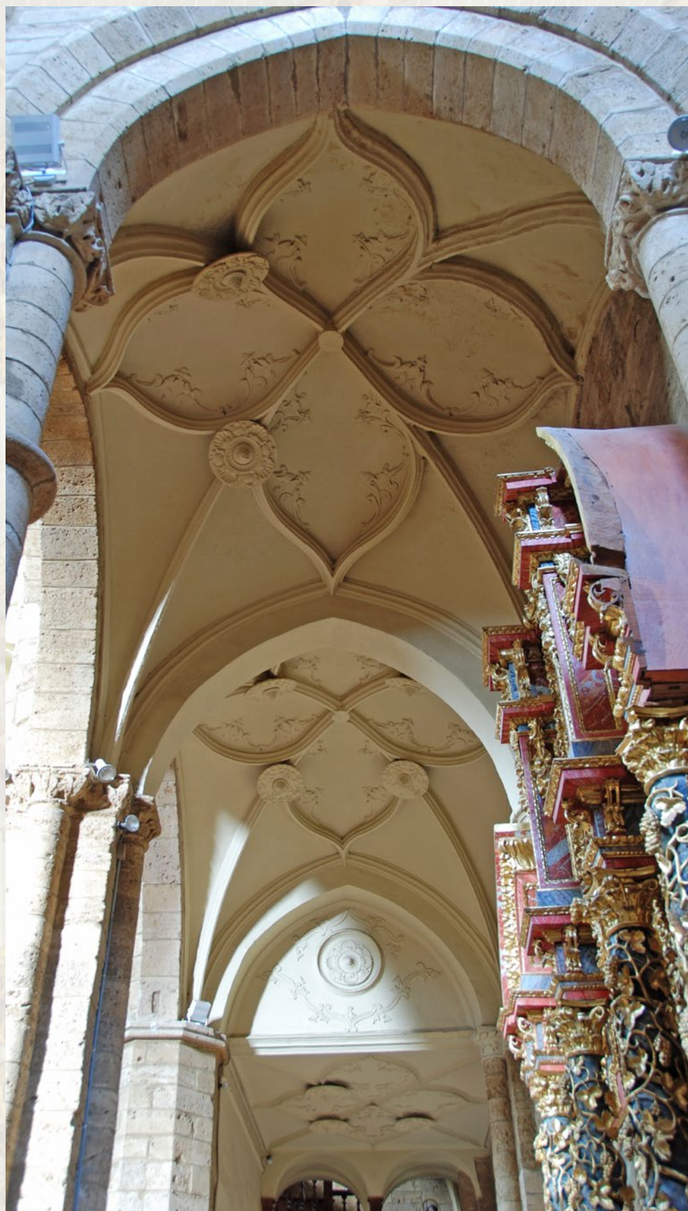
Nave lateral del Evangelio
