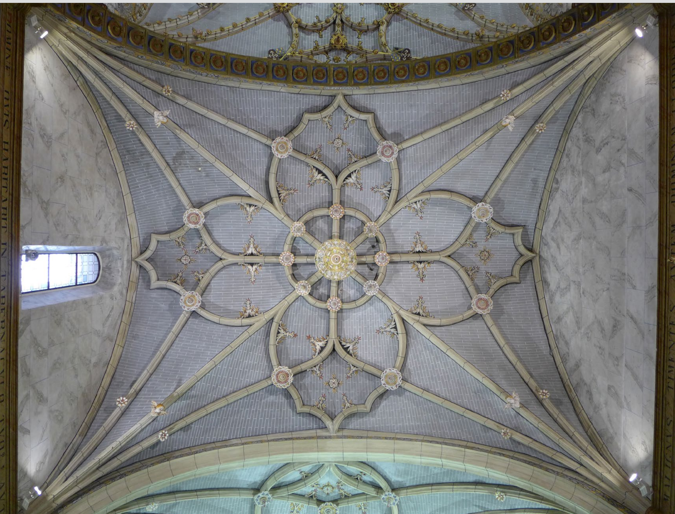
Primer tramo de la nave (en nuestra opinión no será obra de los Corral, aunque pudo ejecutarse sobre proyecto corraliano)
