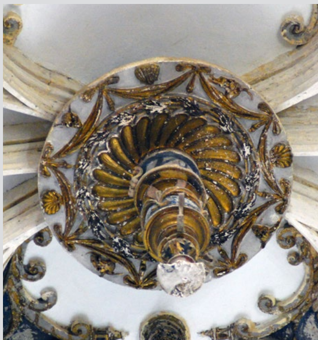
Paredes de Nava. Iglesia de Santa Eulalia Capillas laterales
