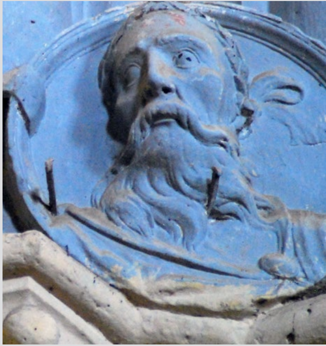
Medina de Rioseco. Iglesia de Santa María de Mediavilla Nave (hacia los pies) Anclajes metálicos de medallones (en la propia figura o en la parte superior del tondo)
