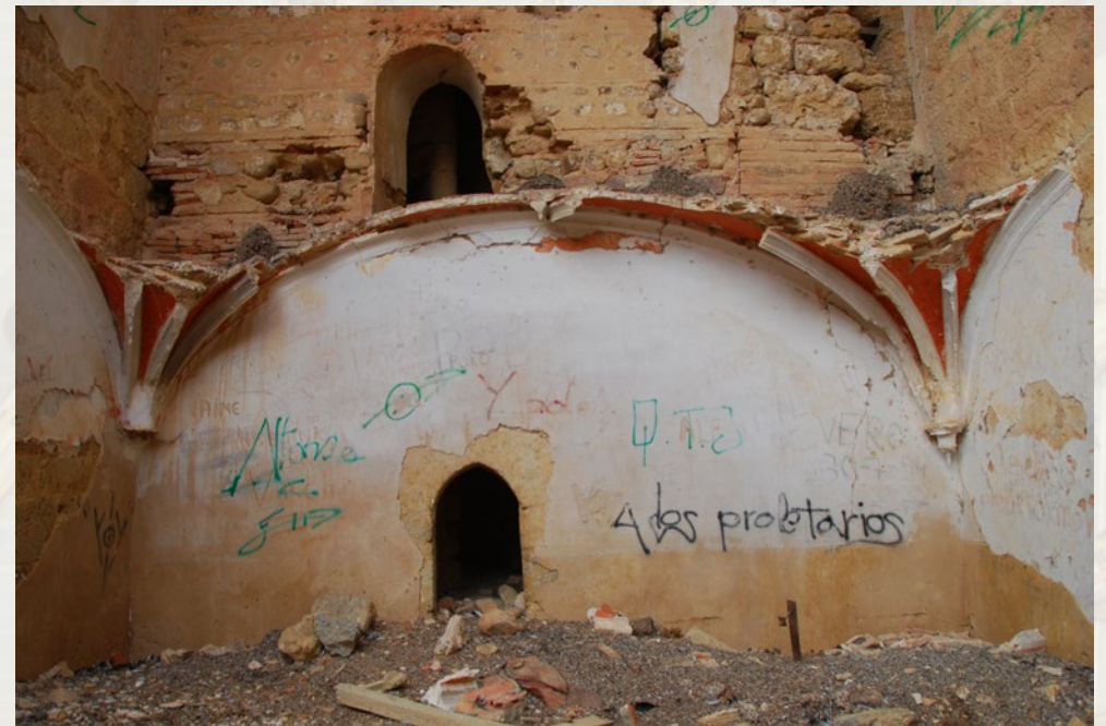
Tramo central del sotocoro y restos de su bóveda
