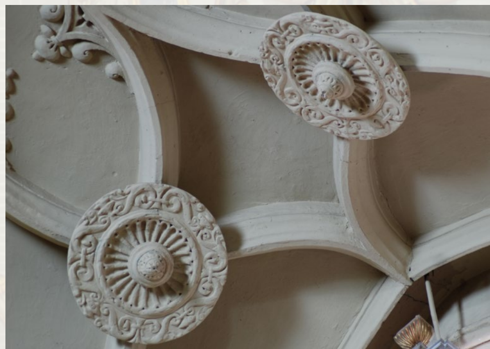
Detalle de las claves y crestería
