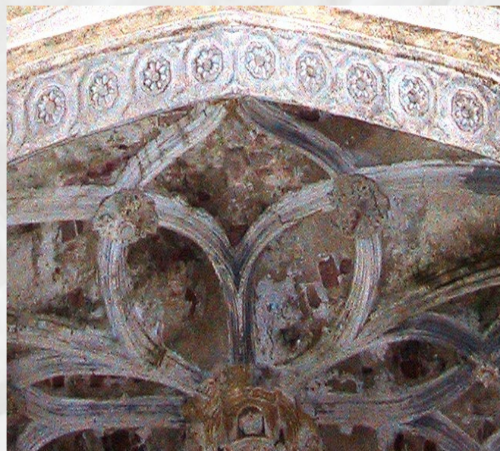
Bóveda correspondiente a la nave lateral del primer tramo del cuerpo de la iglesia de San Pedro de Torrelobatón. La clave se disponía con una microarquitectura pinjante
