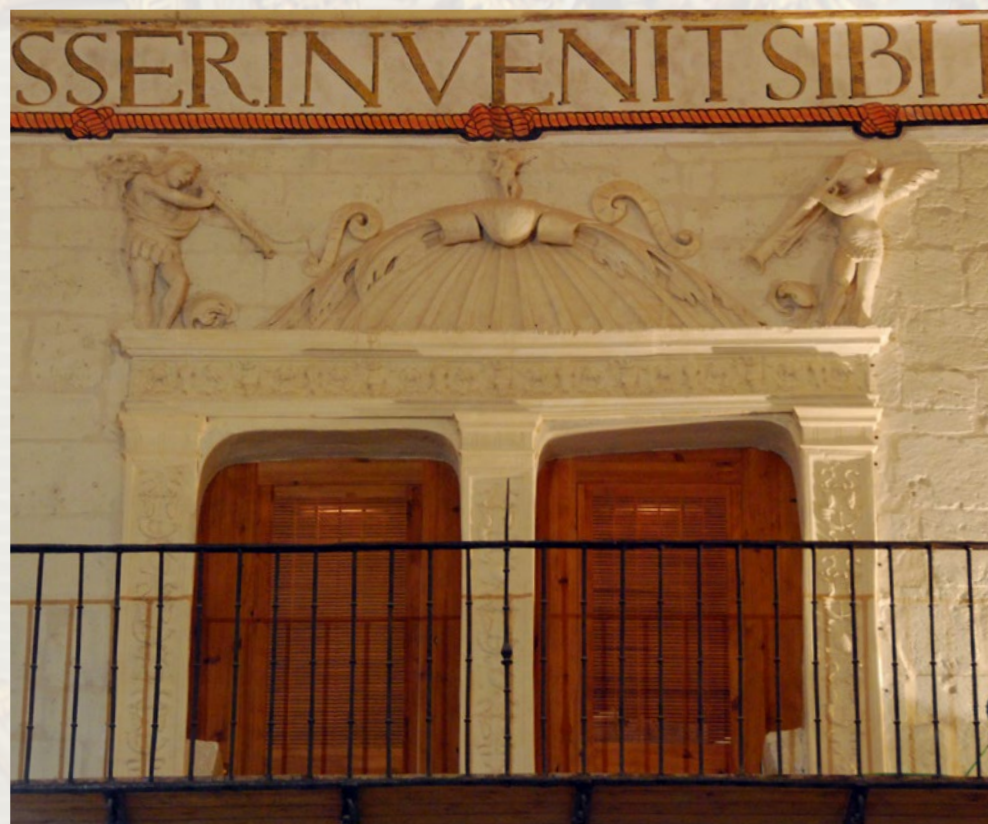
Balcones laterales de la nave
