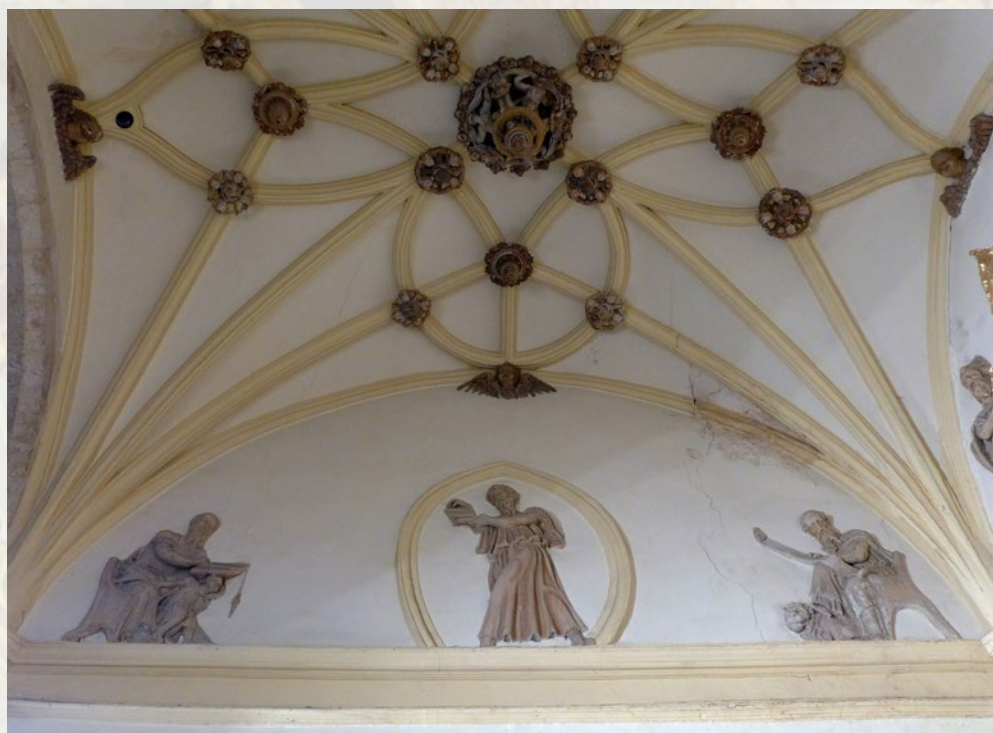
Luneto del muro del Evangelio
