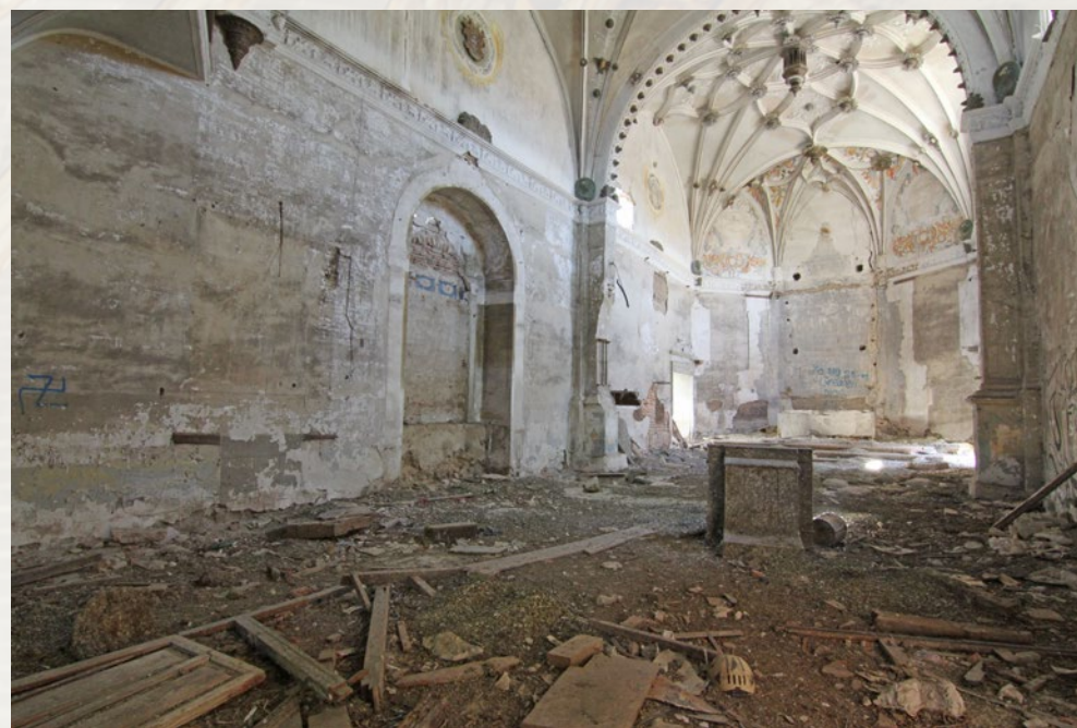
Vista general de la nave desde el coro bajo Fotografías estado actual R. Pérez de Castro
