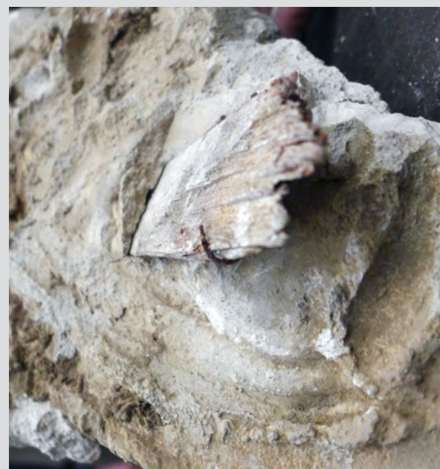
Pieza descolgada y anclaje de madera
