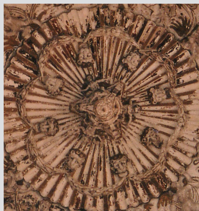
Medina del Campo. Casa Blanca. Bóveda Archivo Fotográfico Museo de las Ferias (M. del Campo)
