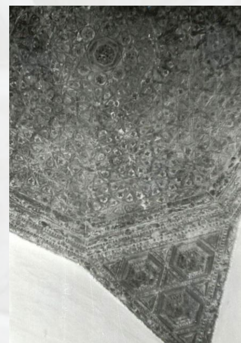
Exterior de la capilla lateral decorada con los yesos de los Corral hacia 1970 (izda). A la dcha., detalle de la armadura de madera que cubría esa capilla y que actualmente se conservadesmontada en la Catedral de Valladolid (drcha.). (fot. Delegación Diocesana de Patrimonio. Arzobispado de Valladolid)
