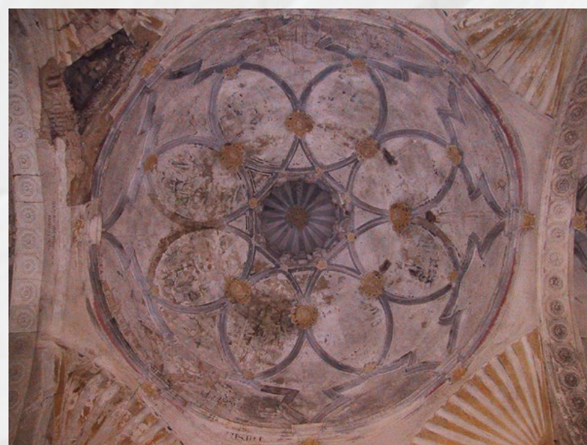
Vista del interior desde la nave central hacia la cabecera en la década de 1990 (arriba). Cúpula desaparecida en el primer tramo de la nave central (fot. Delegación de Patrimonio. Arzobispado de Valladolid).
