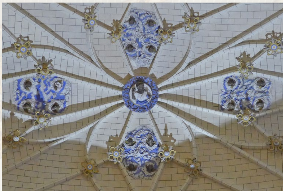
Detalle de la bóveda del primer tramo de la nave
