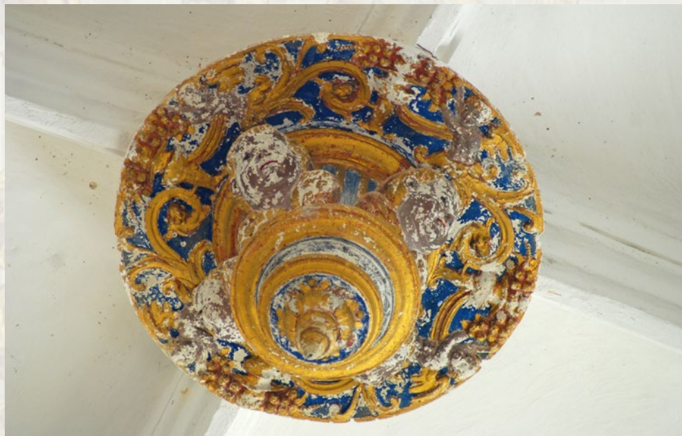
Clave central de la bóveda
