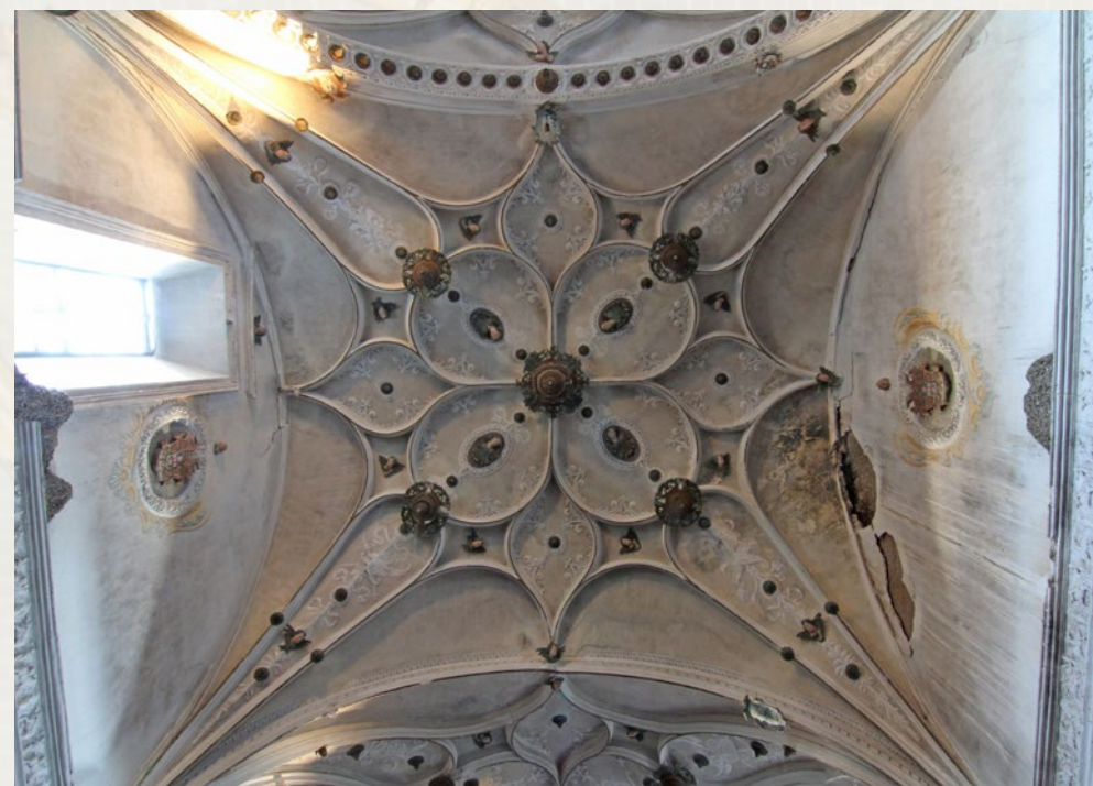
Bóvedas de la nave
