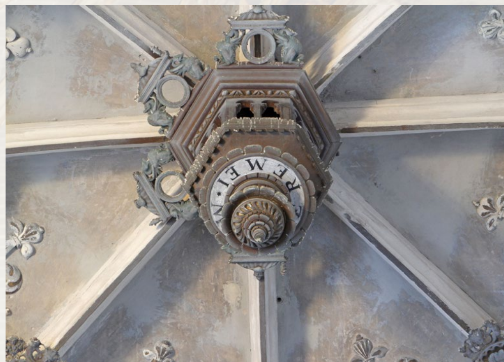
Bóvedas de la nave
