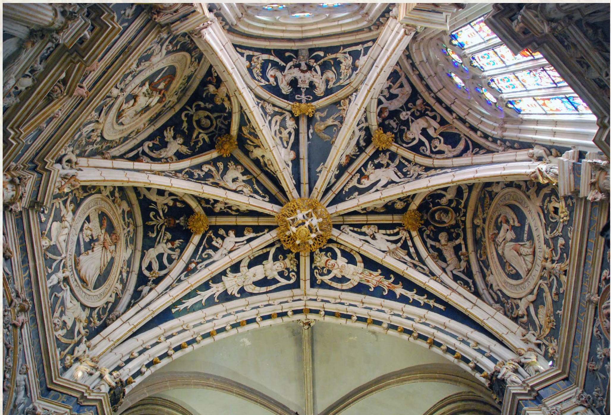
Vista general de la bóveda
