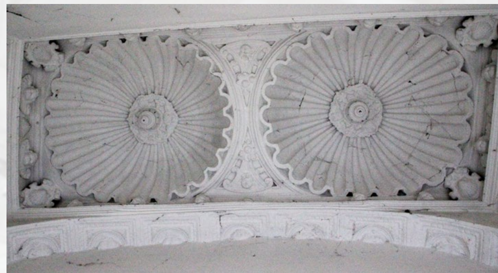
Cubierta de un arcosolio cegado del claustro bajo
