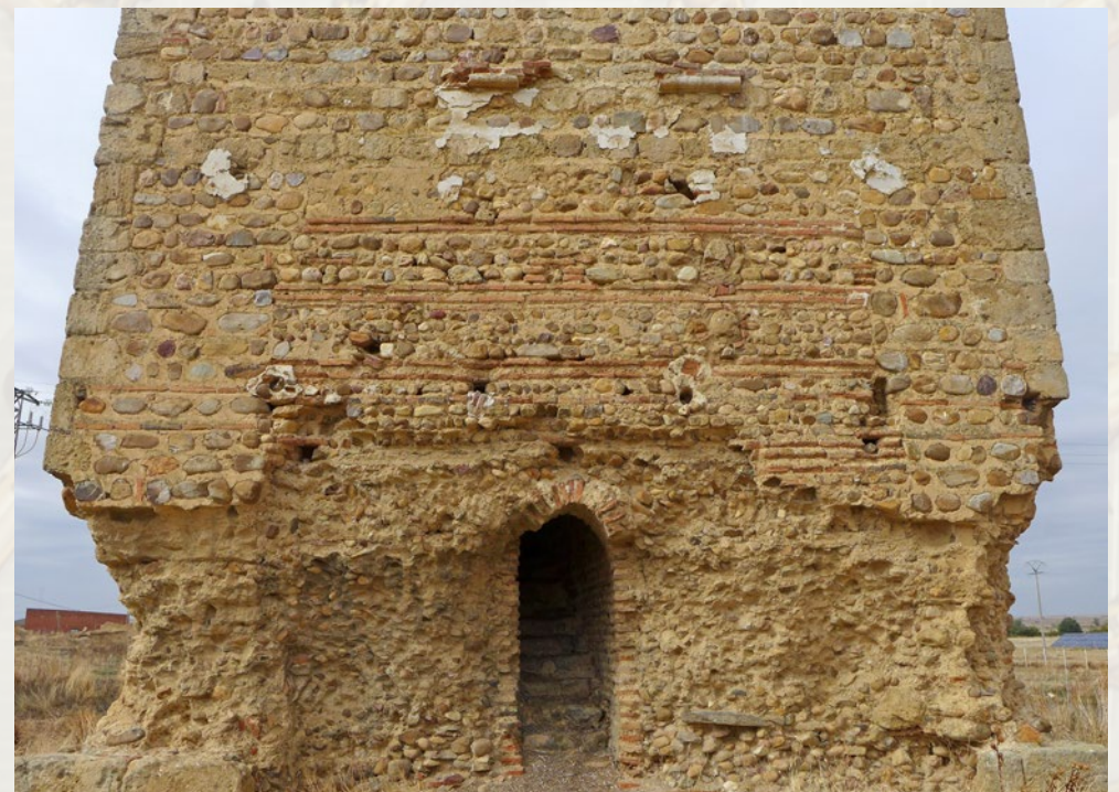
Restos de encalados y de elementos decorativos en la zona de unión de nave y torre
