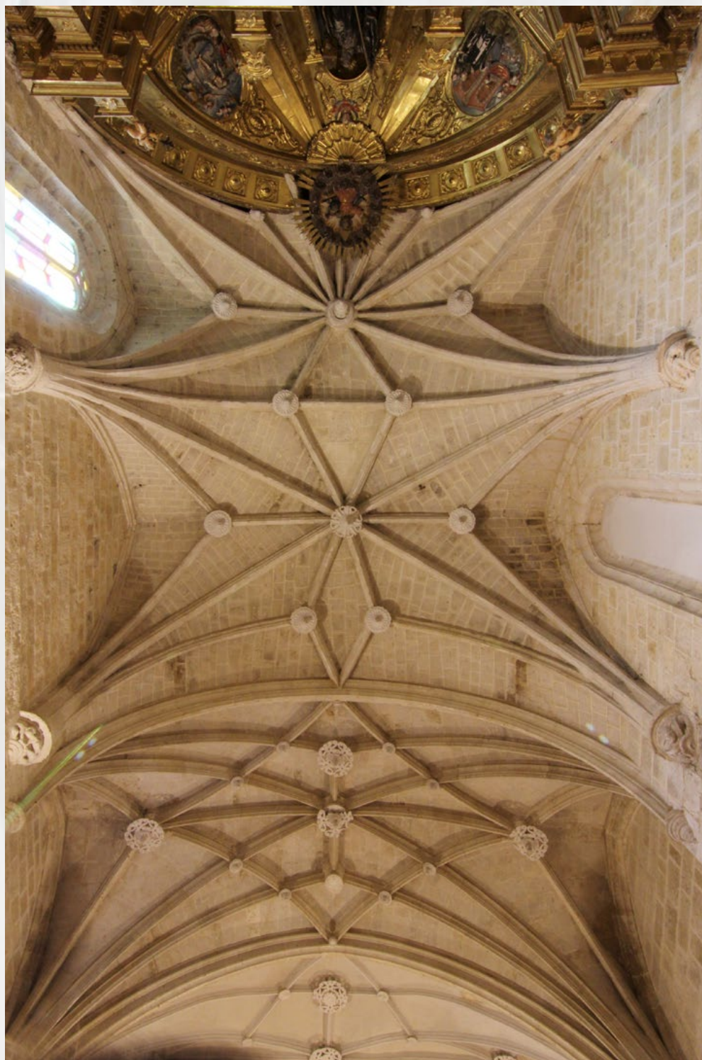
Bóvedas de crucería de Villanueva de San Mancio. A la izquierda se muestran las cubiertas de la capilla mayor y del primer tramo de la nave, realizadas con cantería. Esta última (derecha) impone el tipo formal que se repite en las tres restantes de la nave, en este caso de ladrillo
