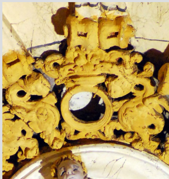
Nave y coro alto. Bichas
