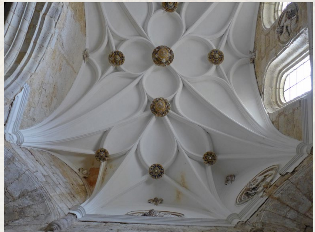
Bóveda vista bajo las trompas del muro oriental
