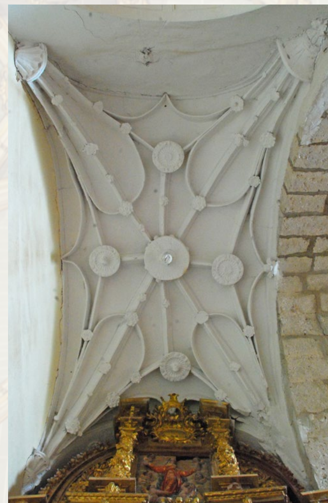
Bóveda de la capilla del Evangelio
