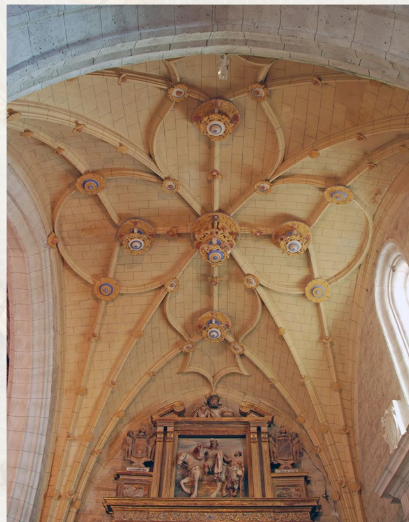
Bóveda de la capilla sur
