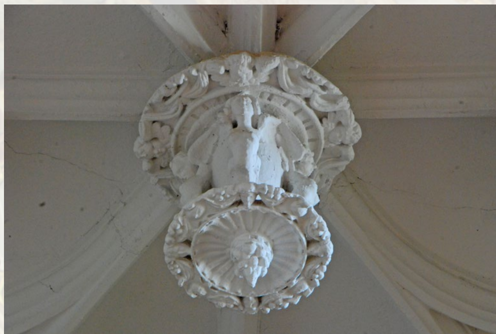
Pinjante central de la capilla mayor
