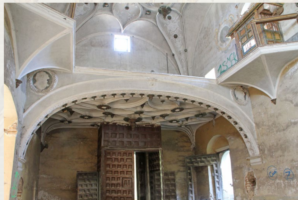
Bóveda del coro bajo
