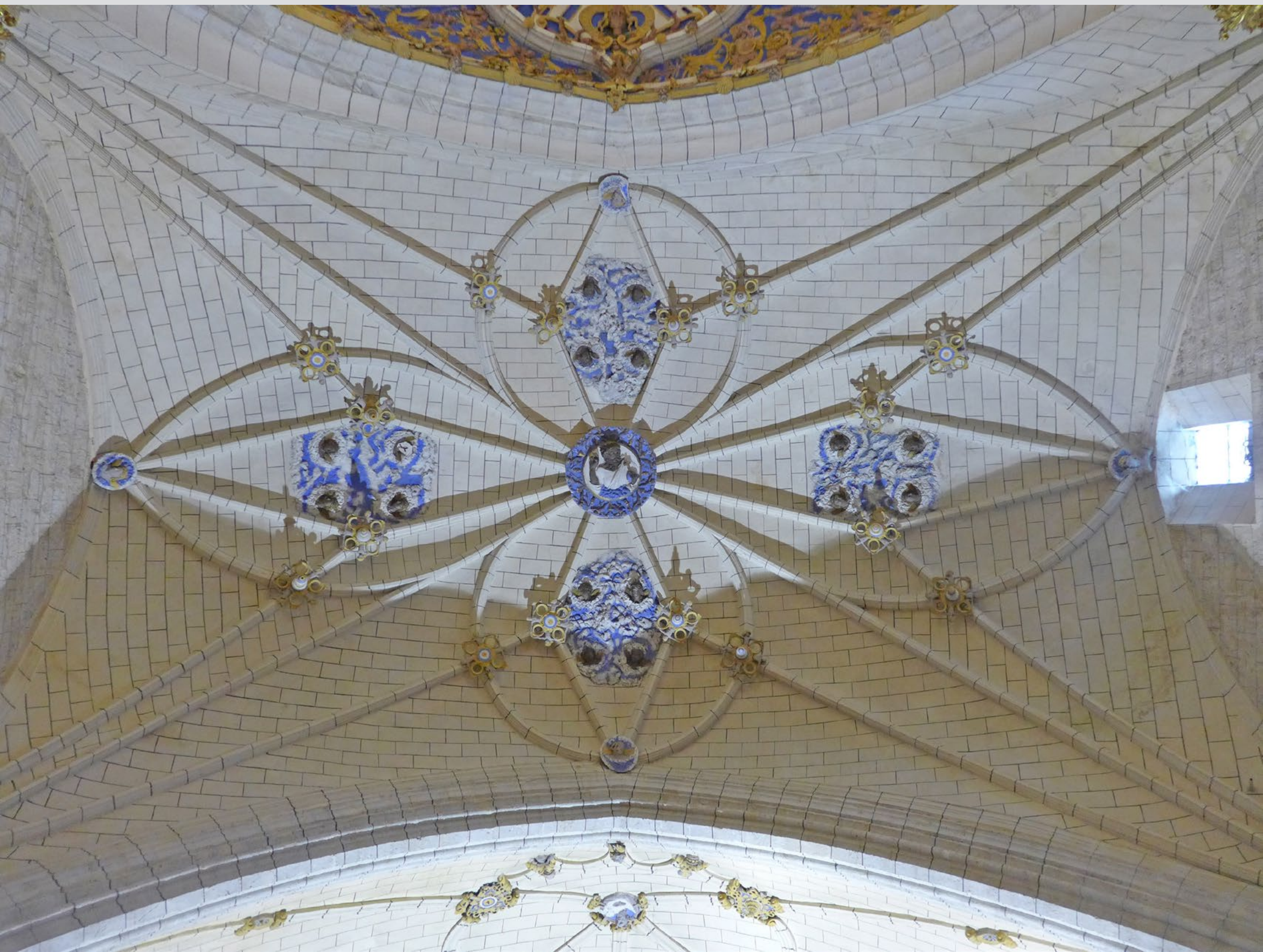
Primer tramo de la nave
