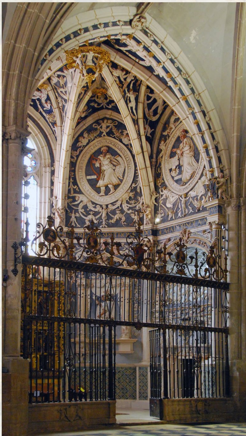
Vista general de la capilla
