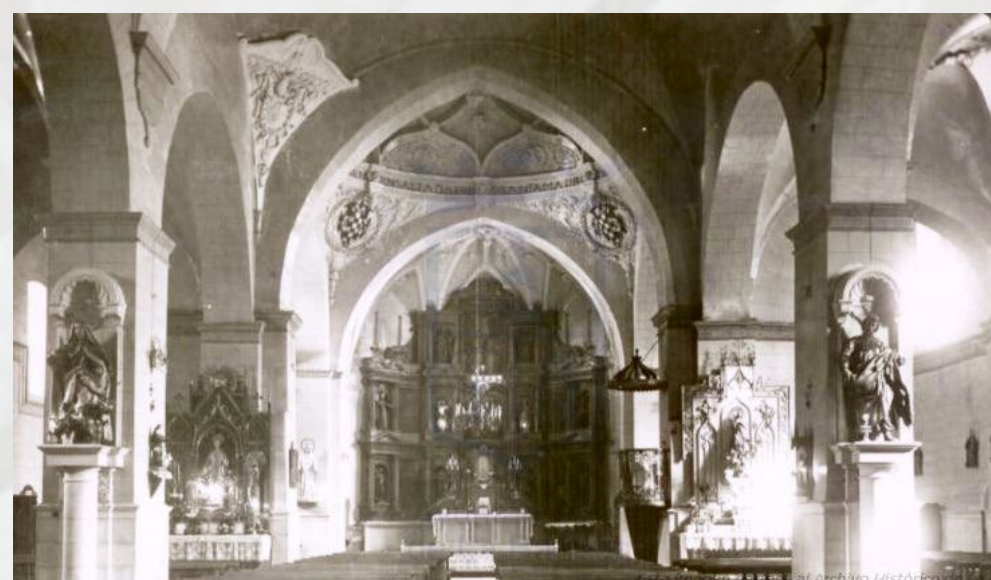
Antigua fotografía del interior de la iglesia parroquial de Santa María (Archivo Municipal de la Bañeza)
