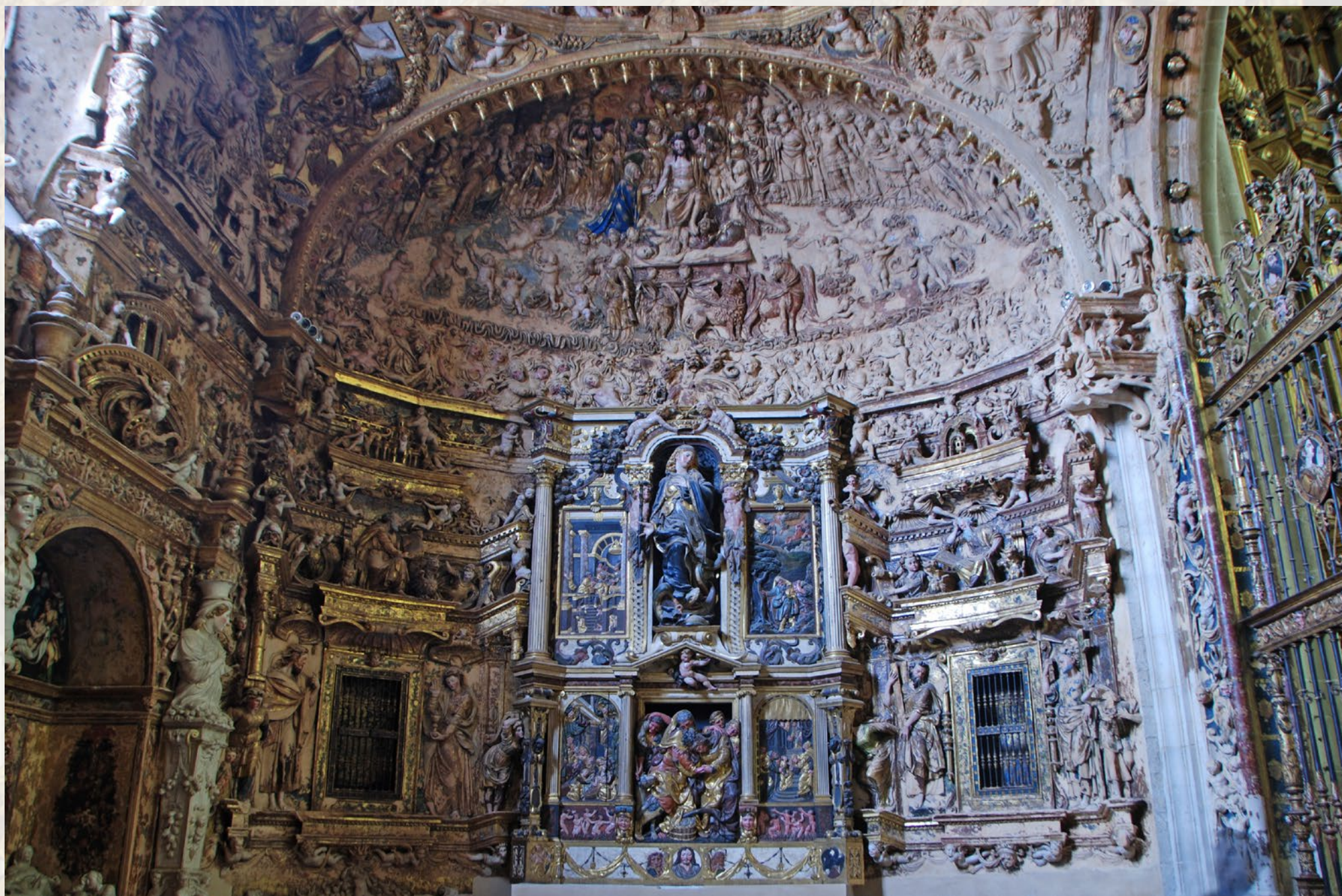
Vista general del paño del ábside
