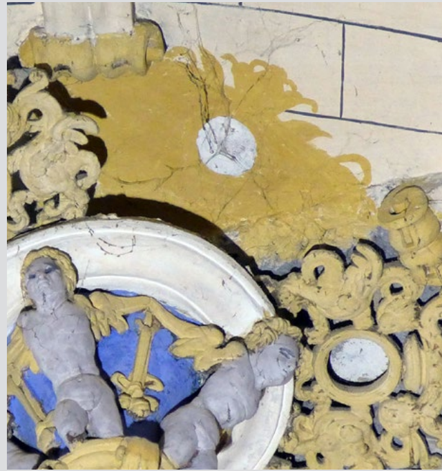
Meneses de Campos. Iglesia de Nuestra Señora de Tovar Anclaje visible por desprendimiento parcial de pinjante y claves en la nave y en la capilla norte
