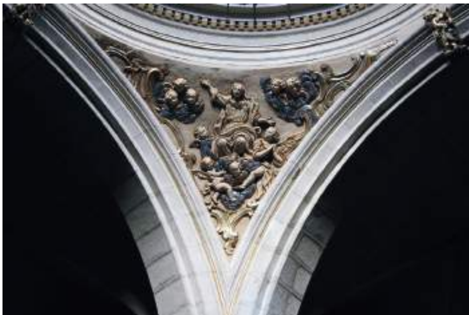
Figura 6. Pechinas de la capilla de la Virgen del Remedio, iglesia de san Juan Bautista de Monóvar. Francisco Mira, hacia 1775-1787. Fotografía del autor.
