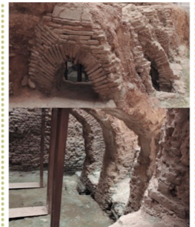
Fig. 7. Vista de la cámara de combustión.
