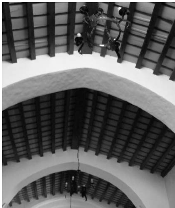
Lám. 11. Estado de conservación inicial del alfarje, cubierto por siete capas de repintes.
