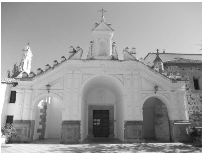
Lám. 1. Ermita de Nuestra Señora de Belén en Cabeza del Buey. Fachada principal del templo.
