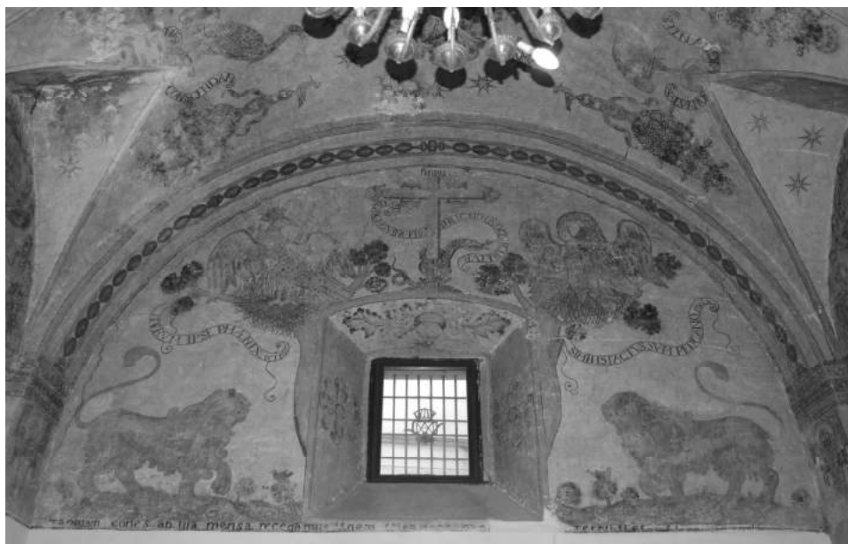
Lám. 3. Muro oeste de la sacristía.
