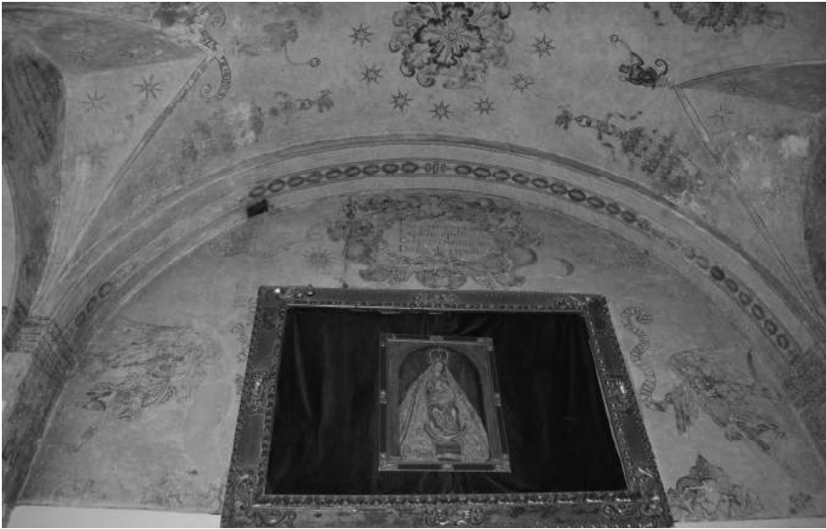
Lám. 1. Muro este de la sacristía.
