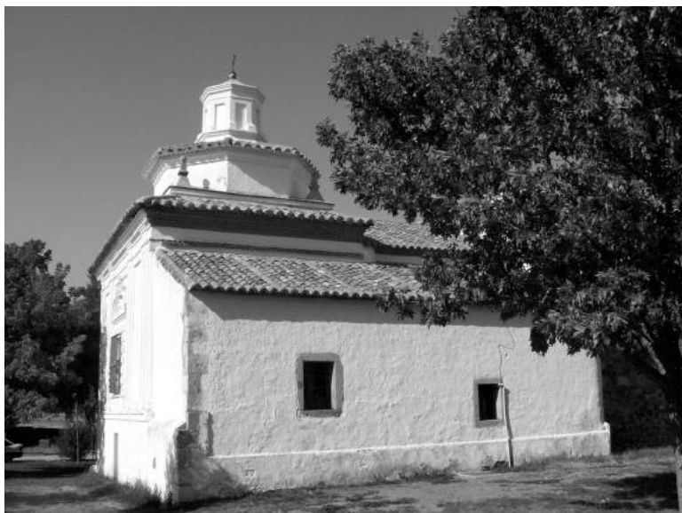
Láms. 3 y 4. Dos vistas del camarín de la ermita.
