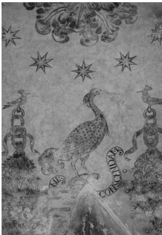
Lám. 9. Detalle de la bóveda. Garza.
