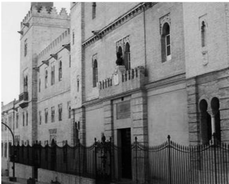
Lám. 3. Estado actual del Castillo-palacio de Hernán Cortés.
