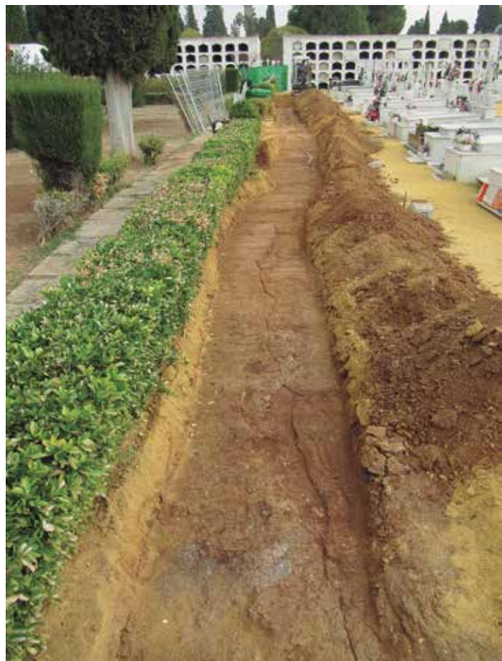
Imágenes del desarrollo de la excavación. Arriba, proceso de excavación manual de la Cuadrícula 3. Abajo, apertura de zanjas con medios mecánicos para delimitar en planta el límite sur de la fosa.
