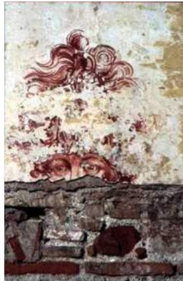
Lám. 11: Casa de C/ Pasillo de Atocha
