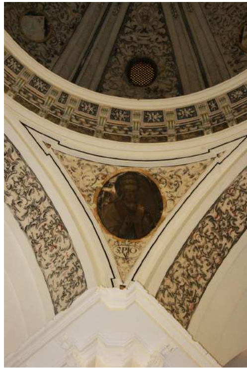
Lám. 38. Pechina. Iglesia del Convento de San Pablo y Santo Domingo. (RSGA).
