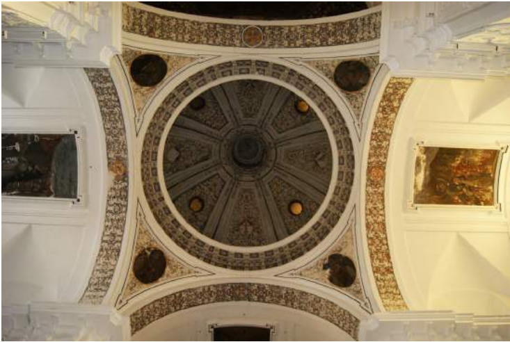
Lám. 37. Cúpula y pechinas. Iglesia del Convento de San Pablo y Santo Domingo. (RSGA).
