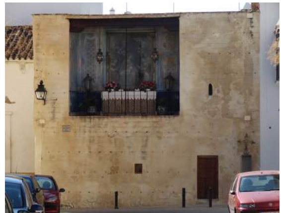
Lám. 52. Capilla de la Virgen de Belén en la Puerta de Estepa tras su restauración. 21 de septiembre de 2013. ICG.
