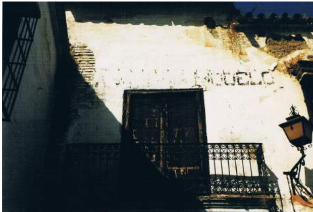
Lám. 27. Casa en Calle Morería. Se aprecian pinturas murales imitando arquitecturas. Desaparecida. AMP.
