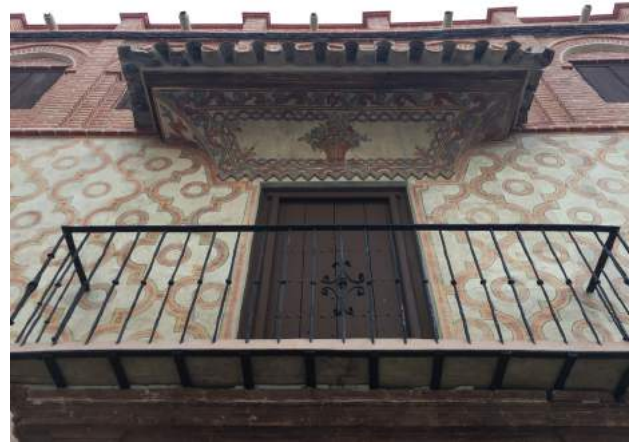
Lám. 16. Detalle del balcón y guardapolvo de la Casa del Gremio de la Lana tras su restauración. Octubre 2016. ICG.
