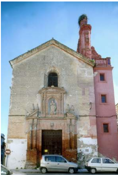
Lám. 17. Exterior de la iglesia de Los Descalzos antes de su restauración. AMP.
