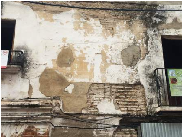
Lám. 8. Casa en calle Merinos nº 25 antes de la intervención.
