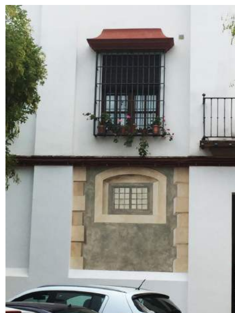
Lám. 24. Detalles de una de las pinturas de imitación a vanos tras la restauración de la fachada de La Cilla. 10 de octubre de 2015. ICG.
