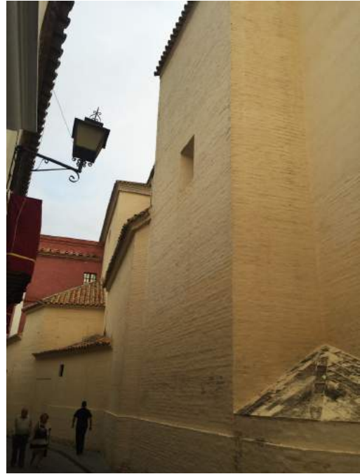
Lám. 8. Estado actual tras la restauración. Se aprecia que los esgrafiados han desaparecido. ICG.
