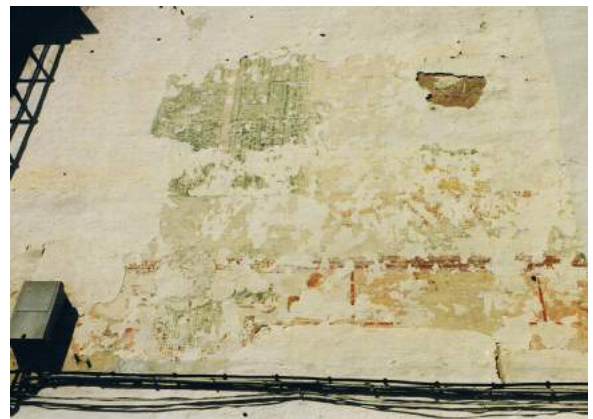
Lám. 28. Casa en Calle Morería. Se aprecian pinturas murales imitando arquitecturas. Desaparecida. AMP.
