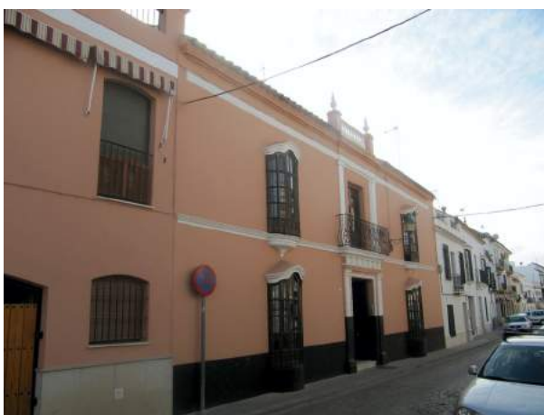
Lám. 28. Mantenimiento y recuperación del color del edificio en calle Mendoza nº 3.
