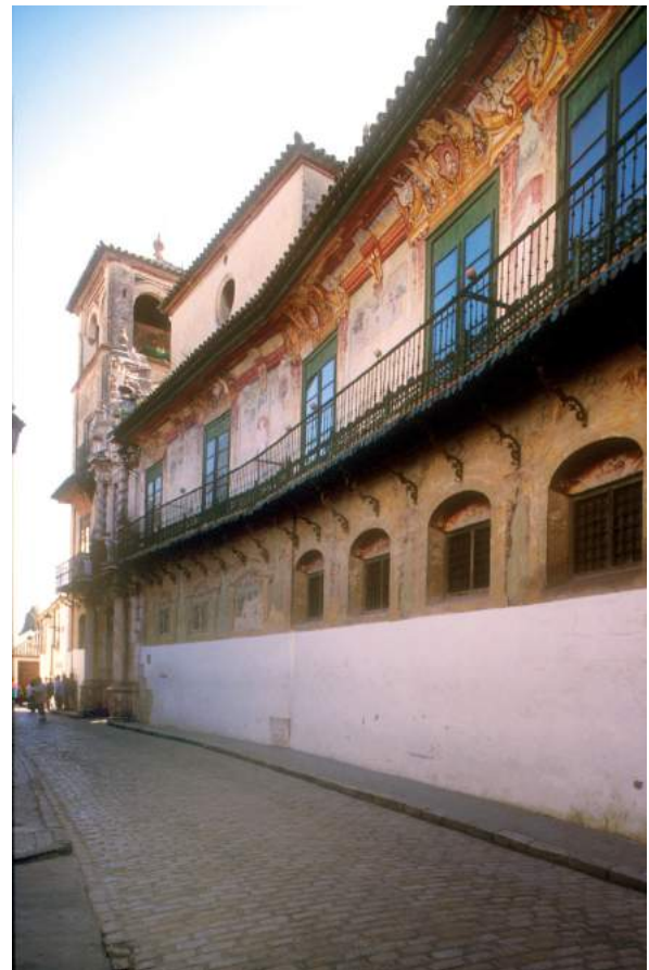
Lám. 34. Vista general de la fachada del Palacio de Peñaflor. AMP.
