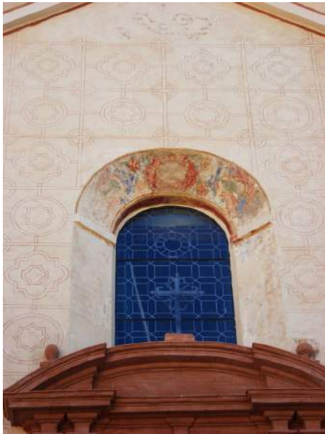
Lám. 19. Detalle de la ventana que remata la portada de la iglesia de Los Descalzos tras su restauración. AMP.
