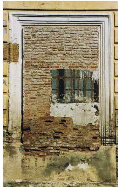
Lám. 20. Trampantojo de una ventana en el Palacio de Valhermoso. Aproximadamente en 2007. AMP
