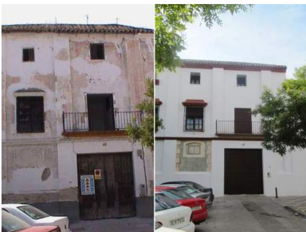
Lám. 22. Antiguo edificio de la Cilla del Cabildo. Restos pictóricos no recuperados.
