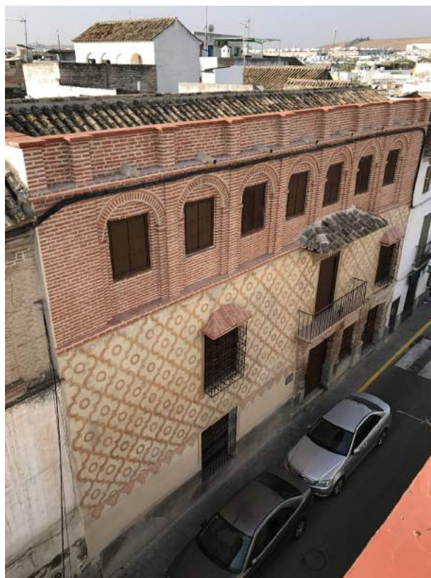
Lám. 27. Intervención en la casa del Gremio de la Lana.
