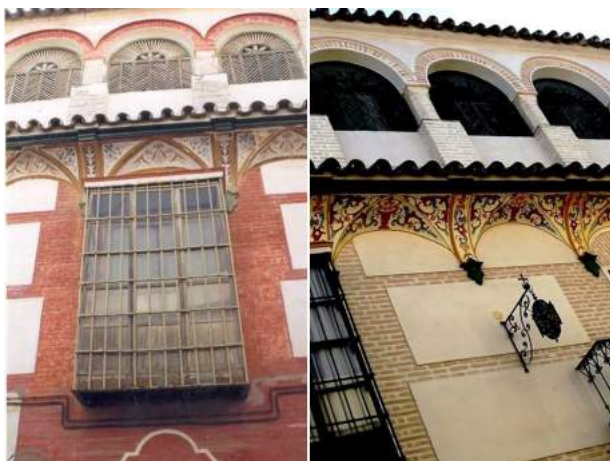
Lám. 24. Casa Palacio en la calle Caballeros nº 42.
