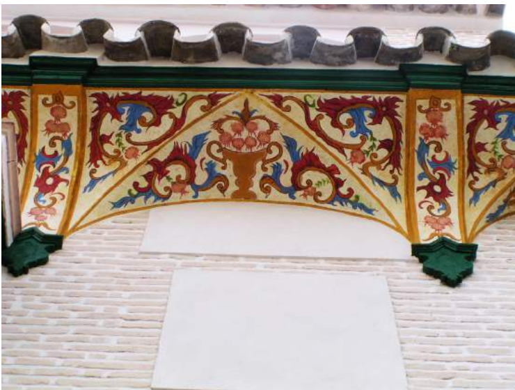
Lám. 47. Detalle del guardapolvo del balcón, tras su intervención. No tiene nada que ver con lo que había. ICG.
