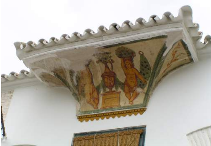
Lám. 49. Guardapolvo del balcón de la casa en calle Mayor nº 60. ICG.
