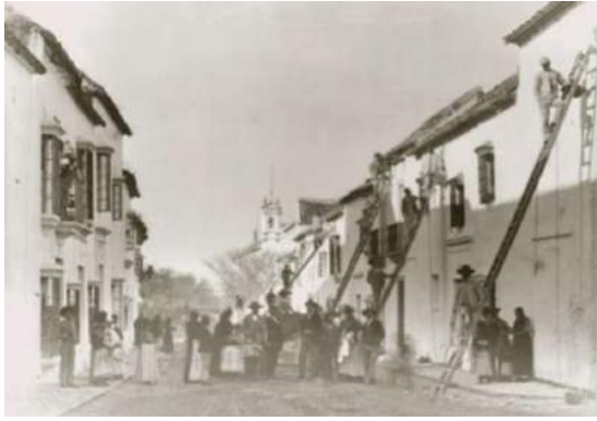
Juan Nepomuceno. 1897. Colocación línea eléctrica c/Mayor.
