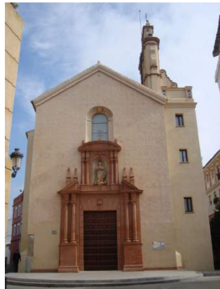
Lám. 18. Exterior de la iglesia de Los Descalzos tras su restauración. 7 de noviembre de 2010. AMP.
