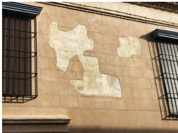
Lám. 9. Casa en calle Merinos nº 25. Integración de los restos de esgrafiados de la fachada.
