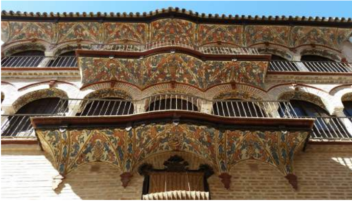
Lám. 43. Estado actual tras su restauración. ICG.
