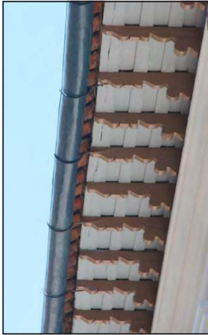
Detalle de la construcción de aleros.
