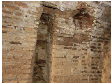
Fig. 19: Ranuras para regulador de altura y regulador de agua
