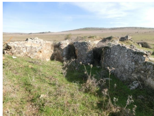
Fig. 28: Vista entrada a los cubos
