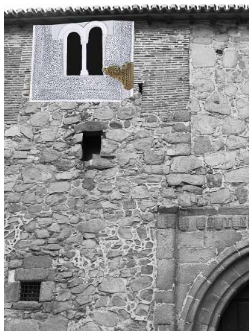
Hipótesis de reconstrucción y de ubicación de la yesería en la parte alta de la fachada oeste del palacio.
