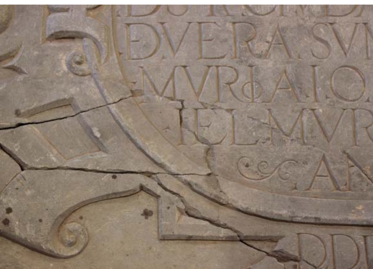
Unión de fragmentos de la lauda de Don Pedro del Peso, unidos mediante adhesión con resina epoxídica.
