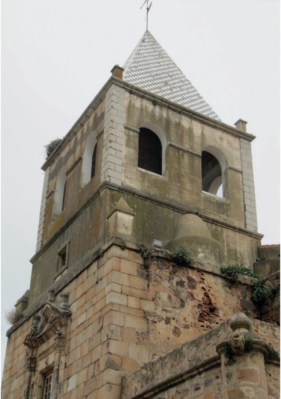
Detalle de la torre
