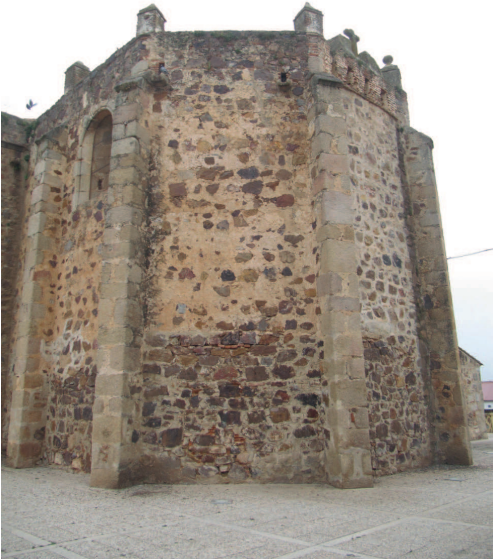
Detalle del Abside
