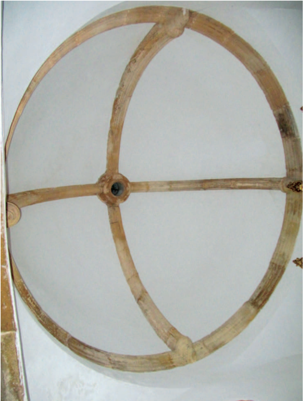
Bóveda, capilla bajo la torre
