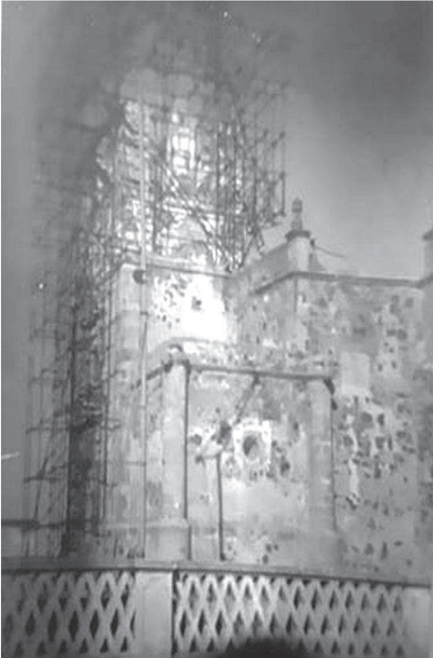
Obras en la torre
