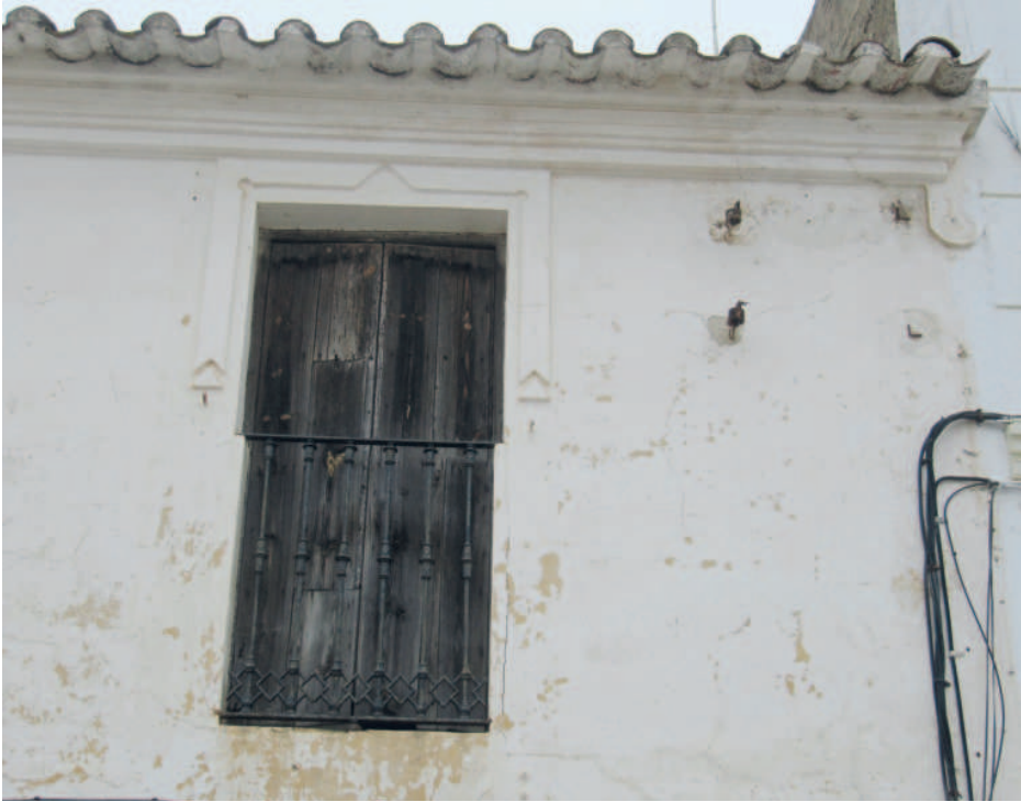
Ventana con recerco decorativo
