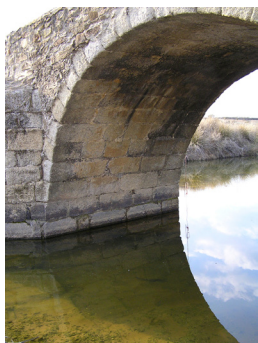
Puente sobre el río Magasca, detalle de una de las bóvedas
