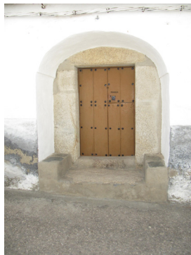
Portalino en calle Trujillo, 14.
