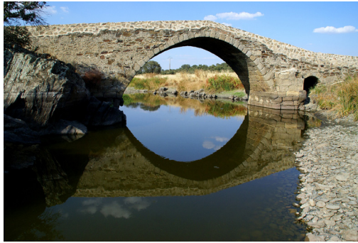
Puente, río Gibranzos (Ctra. Cáceres)
