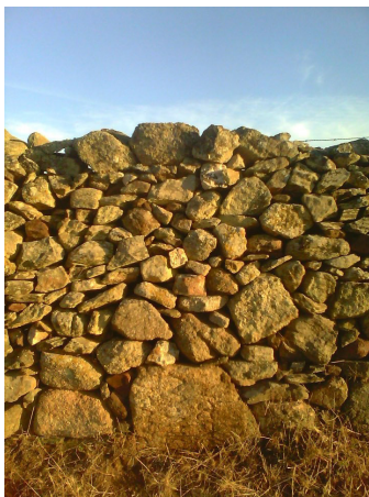
Asentamiento de Revueana, Lapida romana en pared
