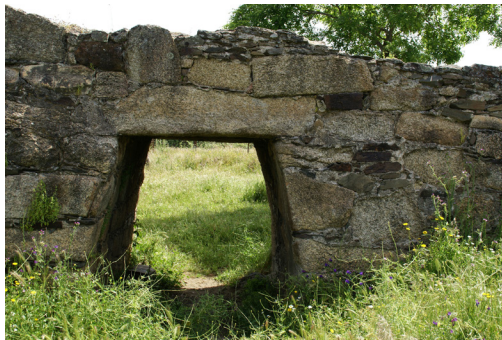
La Puente, detalle del aliviadero.
