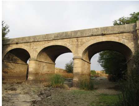
Puente sobre el río Magasca (Ctra. Trujillo a La Cumbre)
