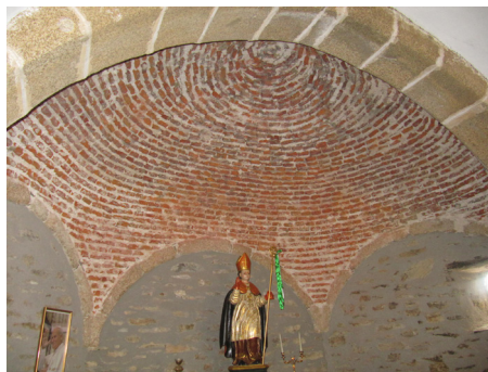
Ábside poligonal cubierto con bóveda de casquete
