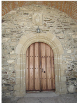
Puerta de la fachada Norte
