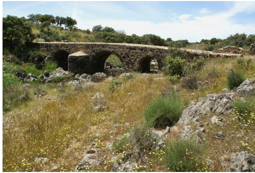
Puente de Maleznas, aguas arriba
