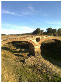
Puente sobre el arroyo Ruanejos
