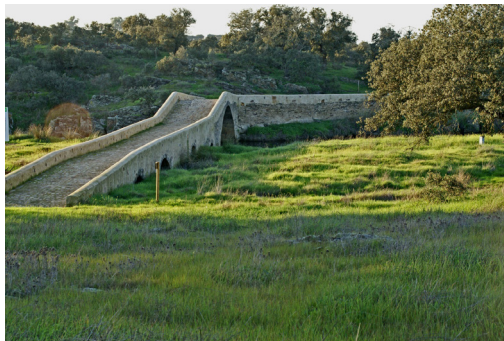
Puente sobre el río Gibranzos, aguas abajo
