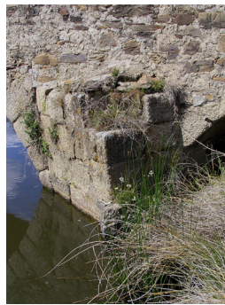
Puente sobre el río Gibranzos, detalle del tajamar
