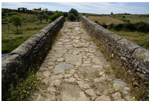
La Puente, calzada
