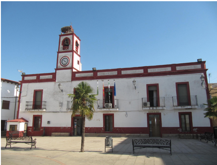
Edificio del Ayuntamiento
