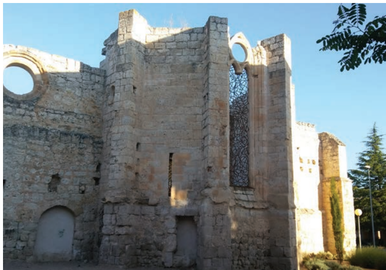
Abside del Convento de San Francisco
