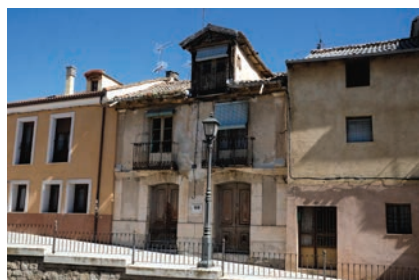
Vivienda con buhardilla con su caballete cubierto de teja
