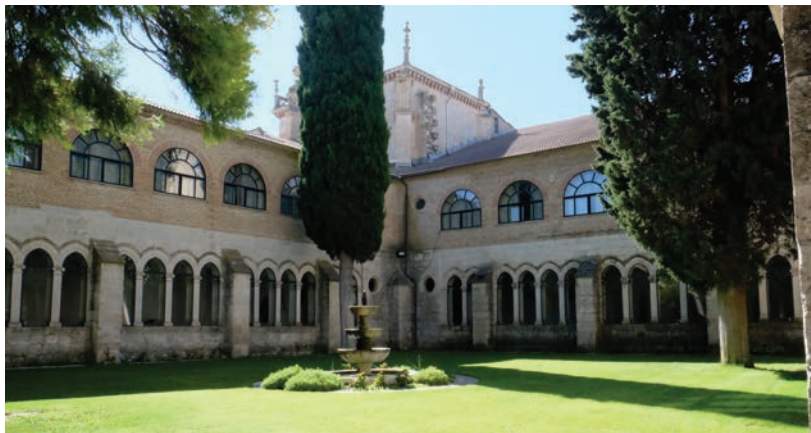
Claustro con piso bajo del siglo XIV y piso alto del siglo XVIII, construido con ladrillo.
