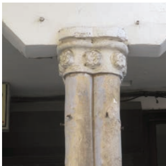
Detalle de una de las columnas
