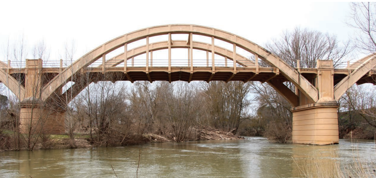
Detalle del nuevo puente sobre el río Duero en Peñafiel
