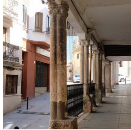
Soportales con columnas procedentes del Convento de San Francisco
