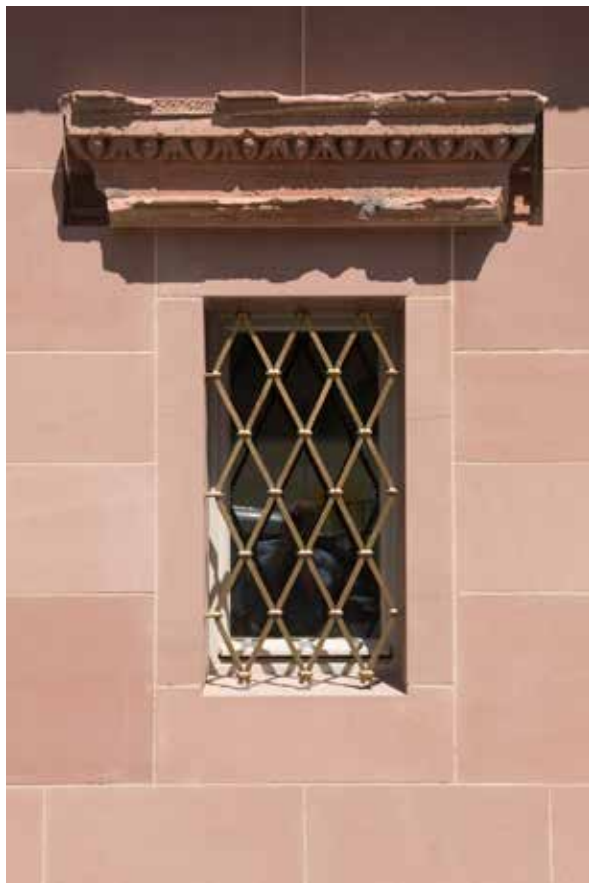
Detalle de una ventana en el reconstruido Römerviertel de Frankfurt
