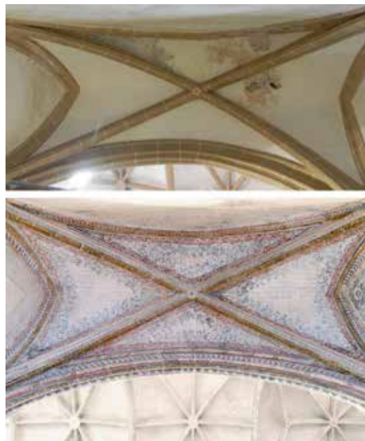
Bóvedas de la Iglesia de San Francisco en Guadalajara, antes y después de las obras de restauración dirigidas por Juan de Dios de la Hoz, Premio Rafael Manzano 2018 Abóbadas da Igreja de San Francisco, Guadalajara, antes e após as obras de restauração conduzidas por Juan de Dios de la Hoz, Prémio Rafael Manzano 2018 Vaults of the Church of San Francisco, Guadalajara, before and after the restoration works conducted by Juan de Dios de la Hoz, Rafael Manzano Prize 2018 Laureate
