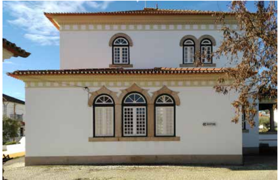
Fachada Noreste del antiguo restaurante de la Estación, Beirã Fachada nordeste do restaurante da antiga estação ferroviária, Beirã Northeast Façade of the Former Station Restaurant, Beirã
