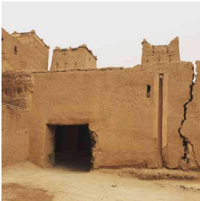
Estado previo y resultado final de la restauración por parte de Terrachidia de la puerta del ksar Akedim, El Khorbat, Marruecos Antes e após a restauração do portão principal do ksar Akedim, El Khorbat, Marrocos, por Terrachidia Before and after the restoration of the main gate of Akedim ksar, El Khorbat, Morocco, by Terrachidia
