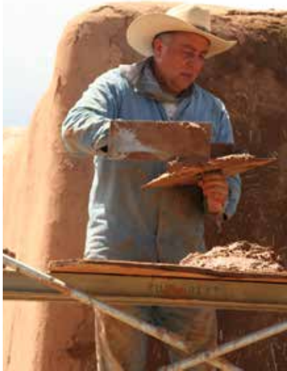
El maestro adobero Albert Parra trabaja para volver a enlucir las paredes de la histórica “morada” en Abiquiu, Nuevo México Albert Parra, artesão hispânico de adobe, trabalha na nova cobertura de gesso das paredes da moradia histórica em Abiquiu, Novo México Hispanic adobe craftsman Albert Parra works to re-plaster the walls of the historic morada in Abiquiu, New Mexico
