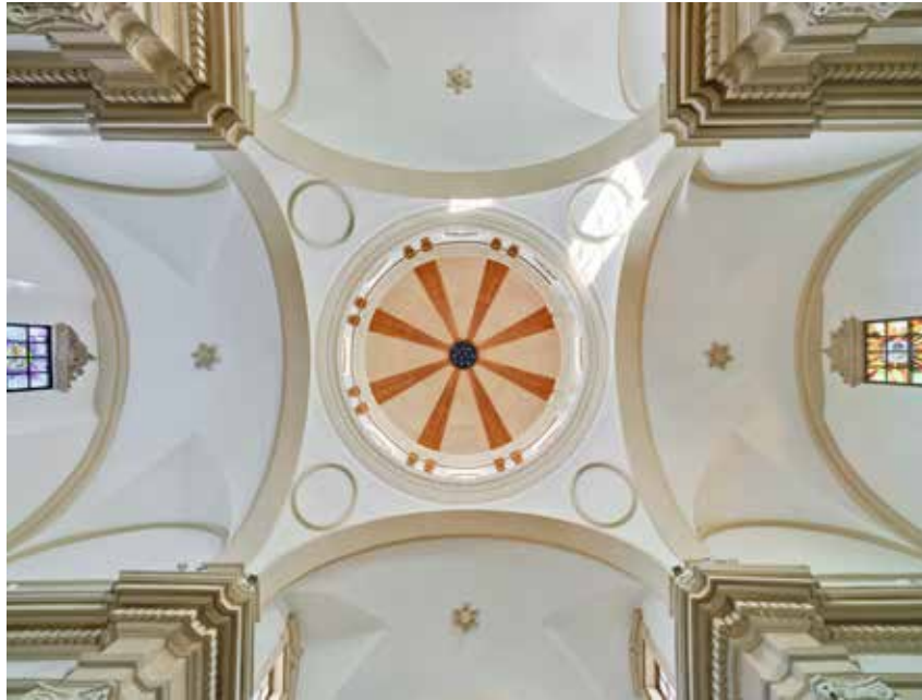
Reconstrucción de la Iglesia de Santiago, Lorca, Murcia Reconstrução da Igreja de Santiago, em Lorca, Múrcia Reconstruction of the Santiago Church in Lorca, Murcia
