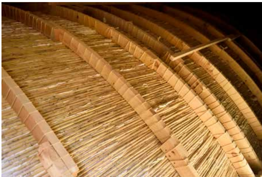
Trasdós de las bóvedas encamonadas reconstruidas en la Iglesia de San José, Lorca, Murcia Parte traseira das abóbadas encamonadas (feitas de madeira, canas e gesso) reconstruídas na Igreja de São José, em Lorca, Múrcia Back of the encamonadas (made of wood, reed and plaster) vaults rebuilt in the San José Church, Lorca, Murcia
