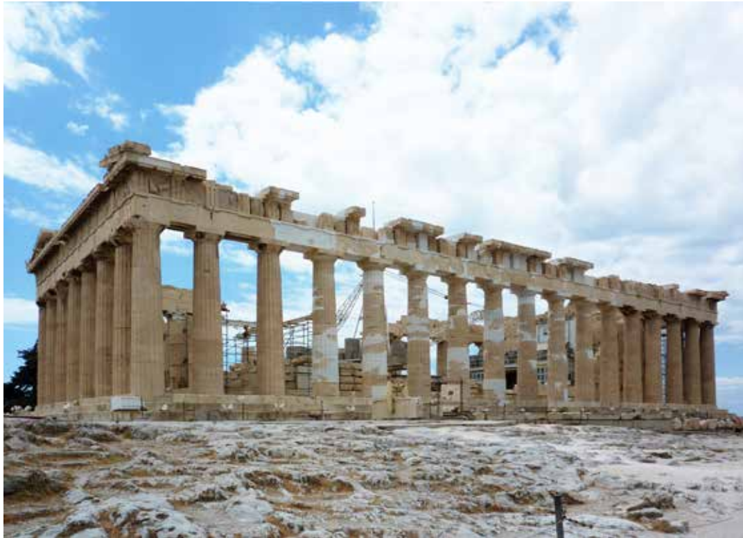
Lado norte del Partenón tras ser montado de nuevo: el nuevo mármol reemplaza a los elementos de hormigón hechos entre 1922 y 1930 Lado norte do Partenon recentemente reagrupado: o novo mármore substitui os suplementos em betão feitos em 1922-1930 Newly reassembled north side of the Parthenon: new marble replaces concrete supplements made in 1922-1930
