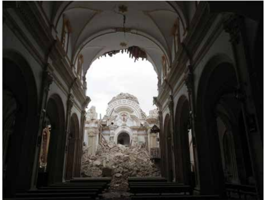
Iglesia de Santiago, Lorca, Murcia, tras tras el terremoto Igreja de Santiago, em Lorca, Múrcia, após o terramoto Santiago Church in Lorca, Murcia, after the earthquake
