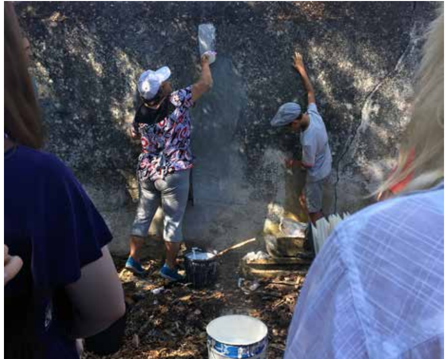
Demostración de aplicación de encalados por Maria Filomena Gaspar Picado Demonstração de pintura com cal com Maria Filomena Gaspar Picado Limewash demonstration by Maria Filomena Gaspar Picado
