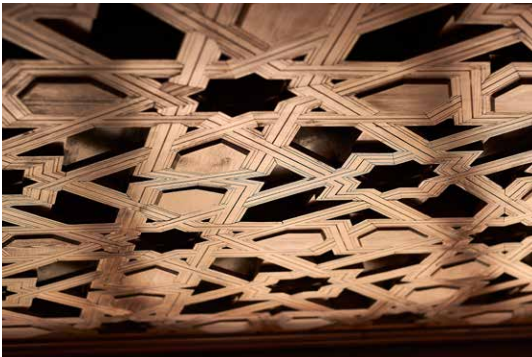
Armadura de lazo realizada por Carpintería Los Tres Juanes para el Palacio de Marbeuf, Mutxamel, Alicante Estrutura de madeira “enrançada”, pela Carpintería Los Tres Juanes para o Palácio Marbeuf, em Mutxamel, Alicante “Laced” wooden structure by Carpintería Los Tres Juanes for the Marbeuf Palace, Mutxamel, Alicante
