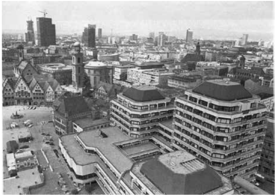
Vista en 1980 del llamado Ayuntamiento Técnico y de los primeros rascacielos del Distrito Financiero de Frankfurt, que se alzaron sobre el antiguo centro histórico de la ciudad O denominado Conselho Municipal Técnico e os primeiros arranha-céus do centro financeiro de Frankfurt, em 1980. Estes edifícios foram construídos sobre o antigo centro histórico da cidade The so called Technical Town Hall and the first skyscrapers of the Financial Center of Frankfurt in 1980. These were built on the former historic centre of the city
