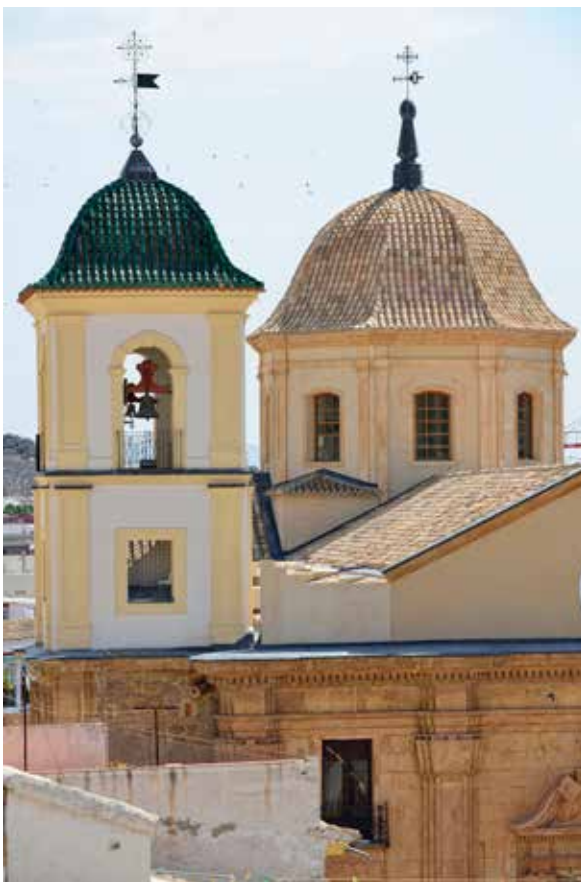
Reconstrucción de la Iglesia de Santiago, Lorca, Murcia Reconstrução da Igreja de Santiago, em Lorca, Múrcia Reconstruction of the Santiago Church in Lorca, Murcia
