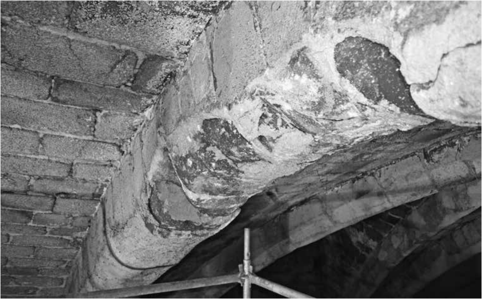
Figura 6 Estat dels nervis de les voltes (fotografia d'Antoni Bramon)
