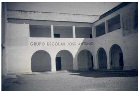
Fotografía 7. Fachada del Grupo Escolar José Antonio (Ibiza) (Santandreu, 1950).
