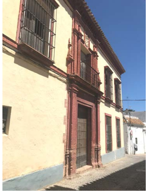
3. Portada de la casa de los Cansino en Carmona, junto a la Puerta de Córdoba, solar de la rama principal
