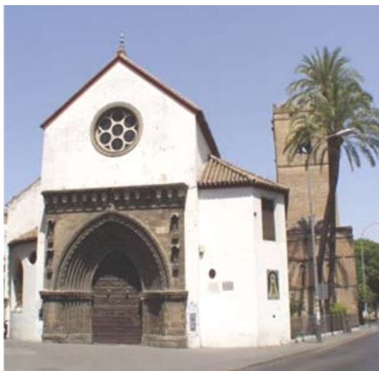
Fig. 1 y 2. Parroquia sevillana de Santa Catalina, en cuya collación se fundó el Hospital de las Cinco Llagas en su primitiva sede, estando ubicado en esta collación entre 1500 y 1559
