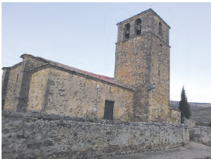
Fig. 2. Iglesia de San Pedro, Torrearévalo (Soria). Foto de los autores (octubre, 2018).
