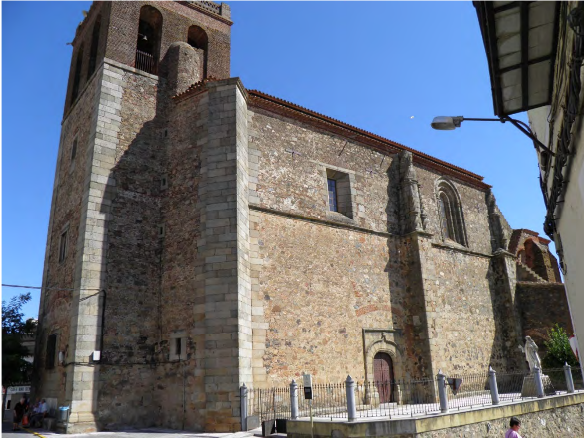
Fig. 7.- Iglesia de San Blas. Vista exterior. Salvatierra de los Barros
