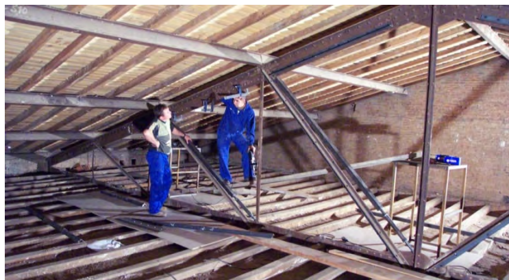
Trabajos de refuerzo de las diagonales comprimidas
