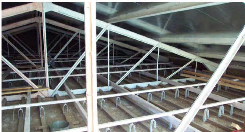
Situación final tras el anclaje de las vigas de madera que soportan el techo de la sala
