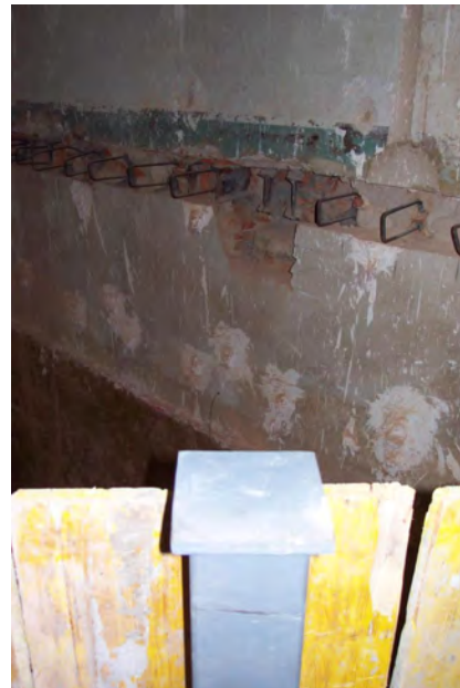
I. Sección del nuevo graderío. II. Anclaje al muro de la losa del nuevo graderío que coincide con la rasante del graderío primitivo
