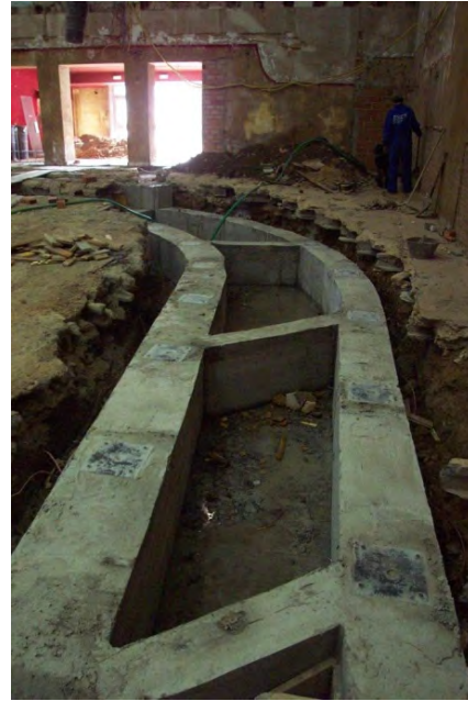
I. Cimentación original del graderío y replanteo de la nueva cimentación. II. Nueva cimentación del graderío
