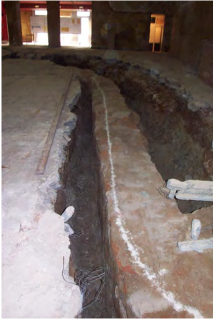
I. Cimentación original del graderío y replanteo de la nueva cimentación. II. Nueva cimentación del graderío
