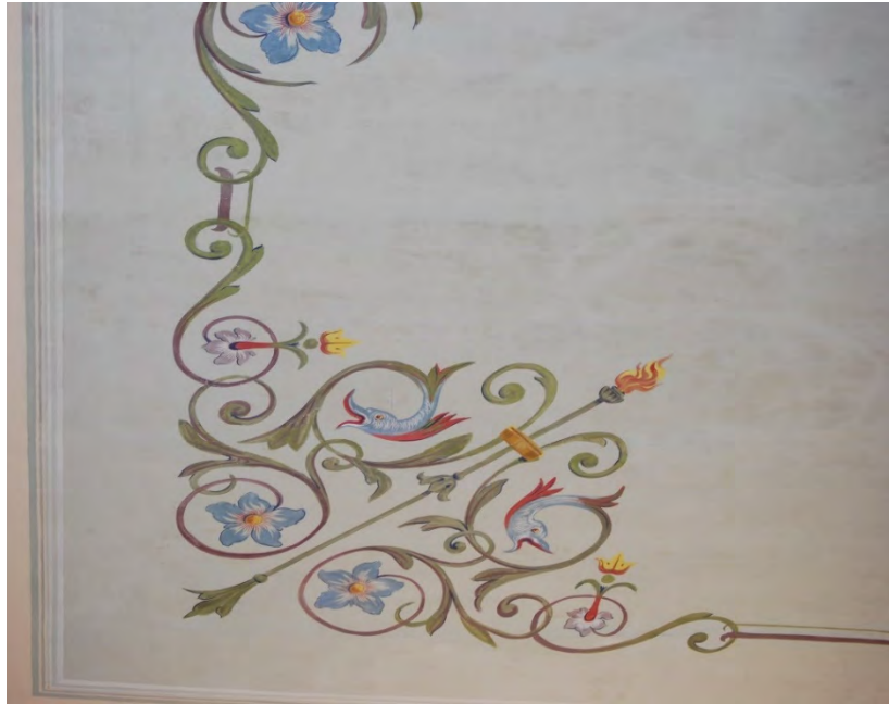
Detalle del techo de la sala de butacas
