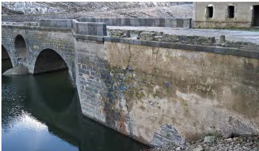
Imagen 4. Cornisa unida a los antepechos unida con pasta de mortero. Fuente: CAMBERO, F.J. (2015)
