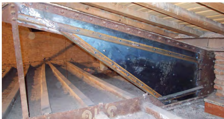
Refuerzo del apoyo rigidizando la unión del cordón y el tirante
