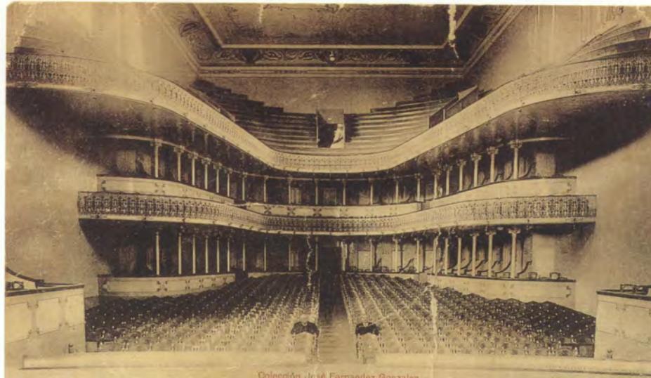
Vista del espacio central recién terminada la obra. Postal de la época
