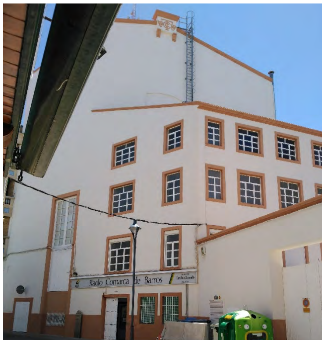
Fachadas actuales, de la calle Arturo Suárez Bárcena (antes Matadero) y fachada posterior
