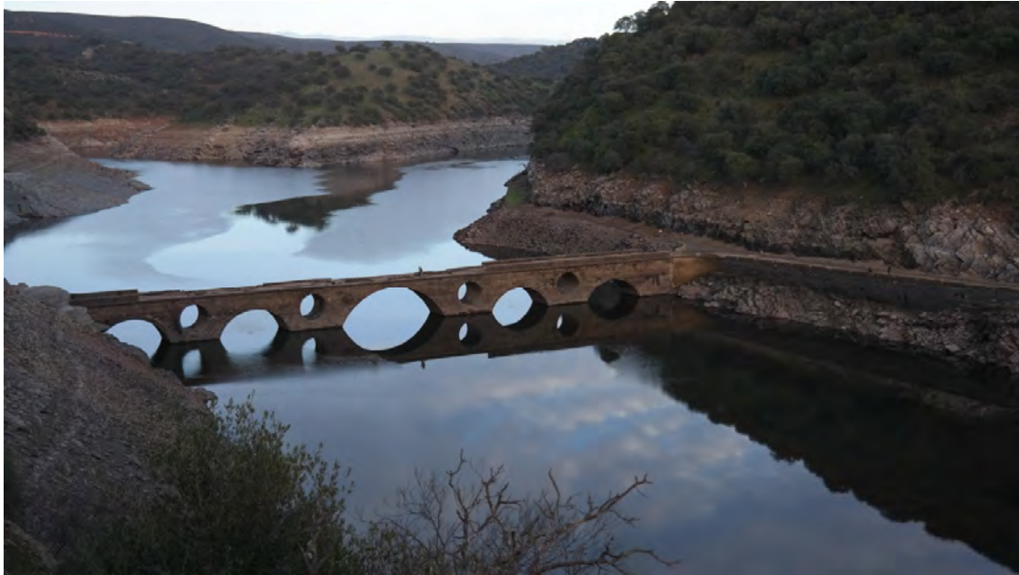
Imagen 6. Localización y estado actual del puente. Fuente: CAMBERO, F.J. (2015)
