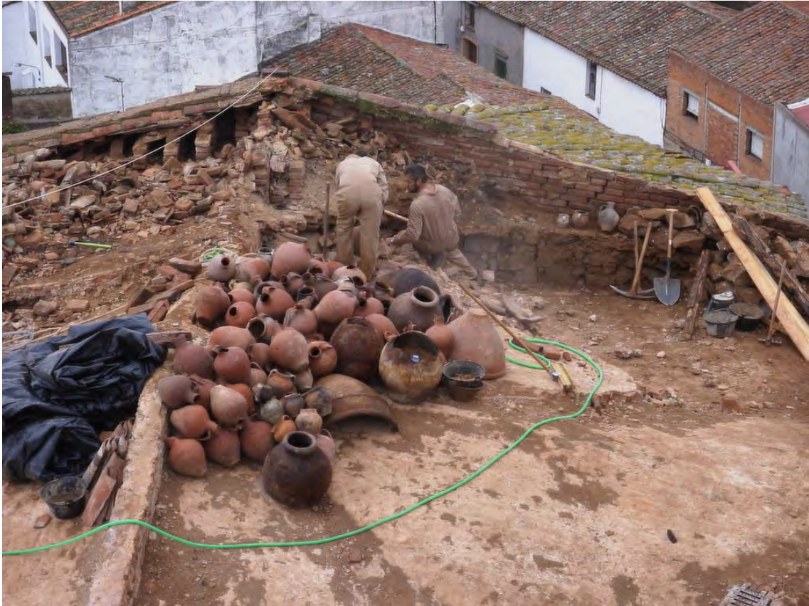
Fig. 11.- Iglesia de San Blas. Relleno de bóvedas. Salvatierra de los Barros
