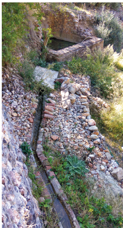
Acequia que conduce el agua de la fuente a la primera alberca de la Huerta de los Moros dentro del perímetro cercado.
