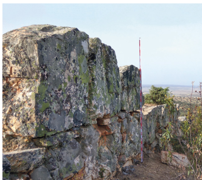
Mampuestos de los muros de la torre de Buzalén. Foto: Juan M. Gordillo.
