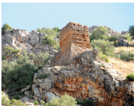
Torre y lienzo de muro de tapial del posible albacar. Foto: José C. Bautista.
