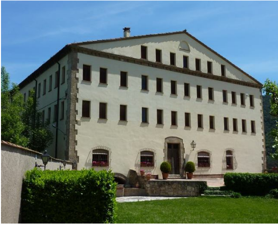
Fig. 14. Fábrica Munné. 118 ventanas distribuidas en tres niveles
