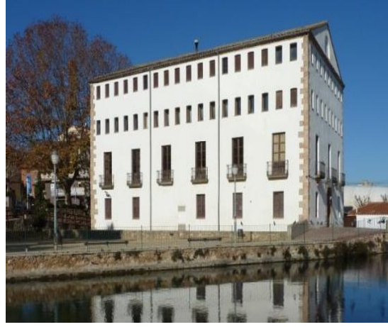
Fig. 15. Molí de la Vila (MMPC). 108 ventanas , en dos pisos.
