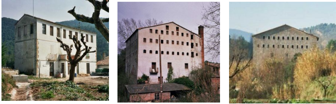
Fig. 2. Edificios con distinto número de tendederos: Cal Pere Joan (la Torre de Claramunt), Ca l'Aumarió (la Pobla de Claramunt) y Molí Major (Carme), respectivamente.
