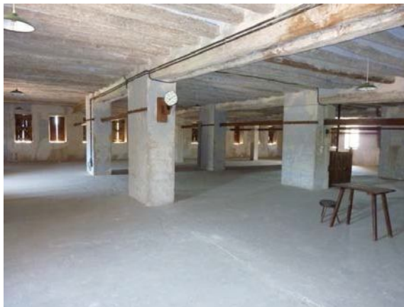
Fig. 4. Interior del primer Mirador o tendedero. Fábrica Munné. Capellades
