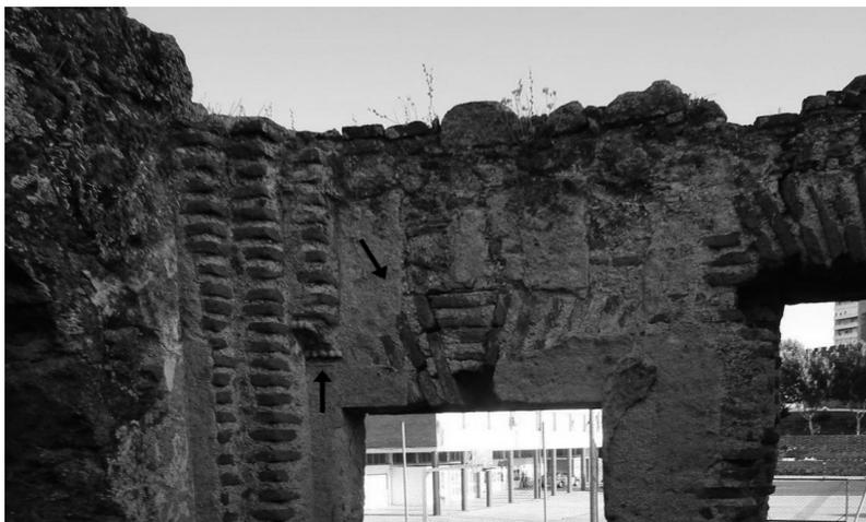
Fig. 25. Interior cámara. Vista desde el S. Detalle del arco recto de la puerta de acceso y de la pequeña ménsula decorada. 2014. Foto P. Matesanz.
