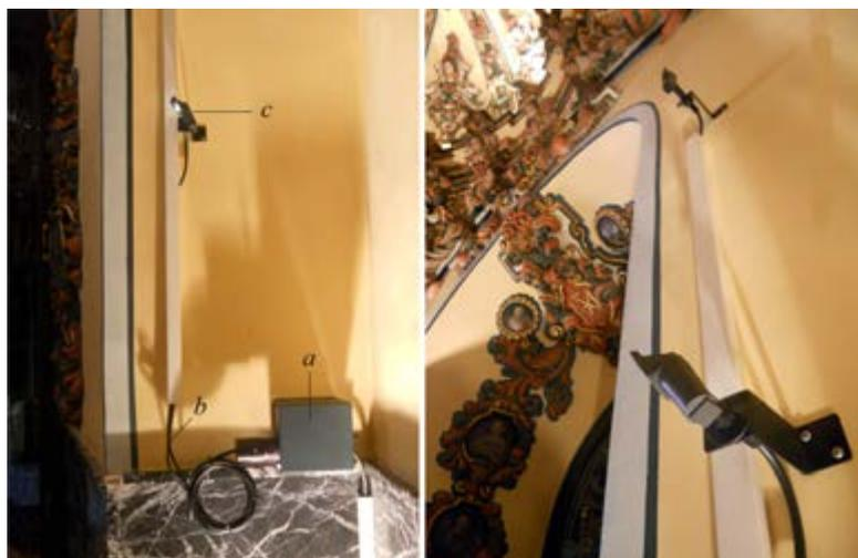
Figura 10. Sistema de iluminación de fibra óptica instalado en el camarín lateral izquierdo. **a:** Cajetín donde se genera la luz. **b:** cable de polimetilmetraquilado transmisor de la luz. **c:** puntos de proyección articulados. Archivo de Juan Antonio Aguilar Jiménez.
