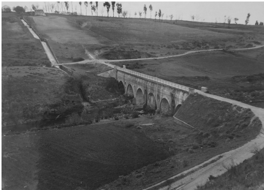
Canal principal de riegos de El Viar. Sifón Sobre El río Siete Arroyos en Villaverde del Río
