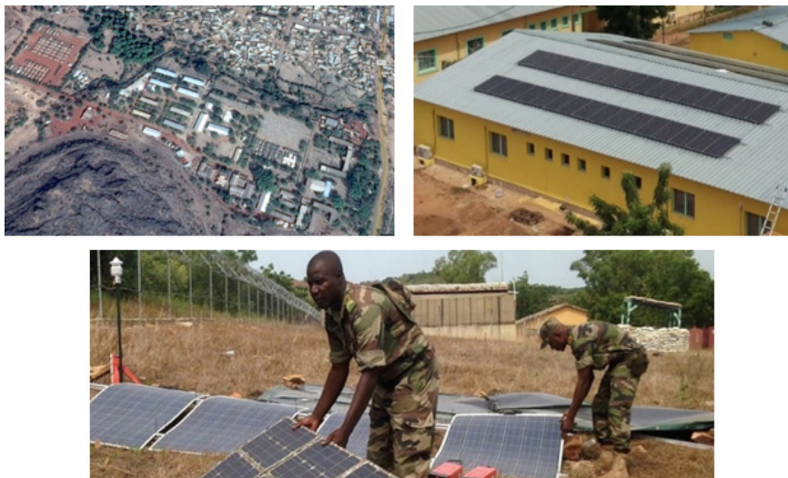
Figura 4. Vista aérea del campamento de Koulikoro; edificio 55 en el campamento de Koulikoro; instalación de paneles fotovoltaicos flexibles por fuerzas desplegadas en el campamento de Koulikoro. (Fuente: Presentación «Smart Energy Camp Demonstrator EnE Working Group», por Jon Woodman/ Ken Hobbs para 5th EnE WG meeting, Bae Systems, marzo 2016).
