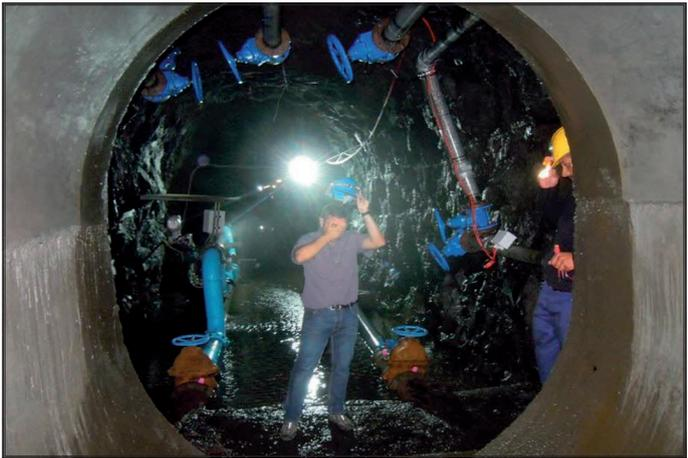
Figura 15; Cierre hidráulico construido en el túnel del trasvase (cara este) en la isla de La Palma.
