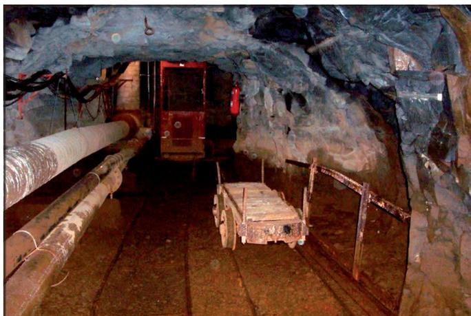
Figura 10; Pozo-Galería Los Padrones en la isla de El Hierro, al fondo se observa el pozo y de ahí nace la galería horizontal.
