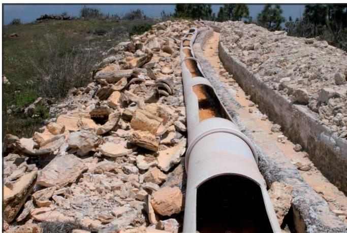
Figura 20;Depósitos de carbonatos en un canal de una galería la zona sur de Tenerife (Arico)
