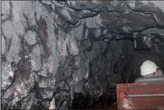
Figura 14; Zona saturada de agua en la traza de la galería.
