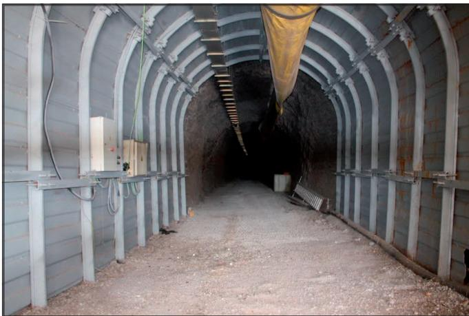
Figura 6; Sección de una galería perforada por la Administración en la isla de La Gomera con mayores dimensiones que las de la iniciativa privada.
