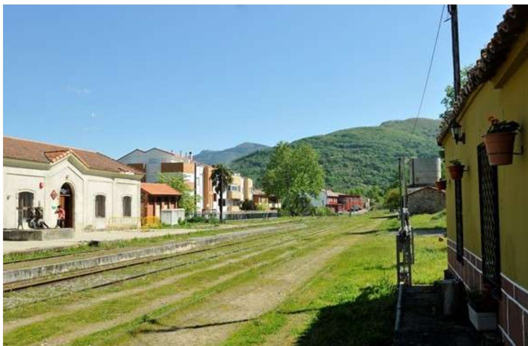
Figura 16: Estación de ferrocarril Fotografía: CGC
