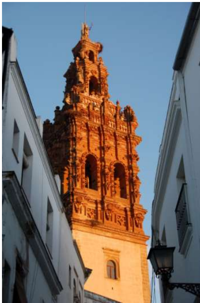
Figura 18. Torre de la Iglesia de San Miguel
