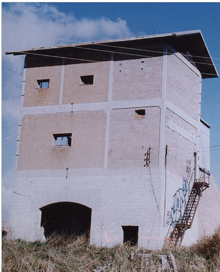
Figura 1. Planta de la machacadora de Fomento de Obras y Construcciones, símbolo del desarrollo industrial de Colmenar Viejo durante los años veinte del siglo pasado. A pesar de englobarse en el listado del IPICAM, fue destruida para levantar en su lugar un complejo comercial.
