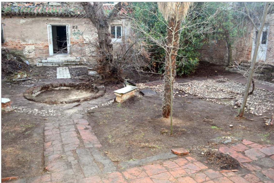
Figura 5. Excavación parcial del jardín interior.
