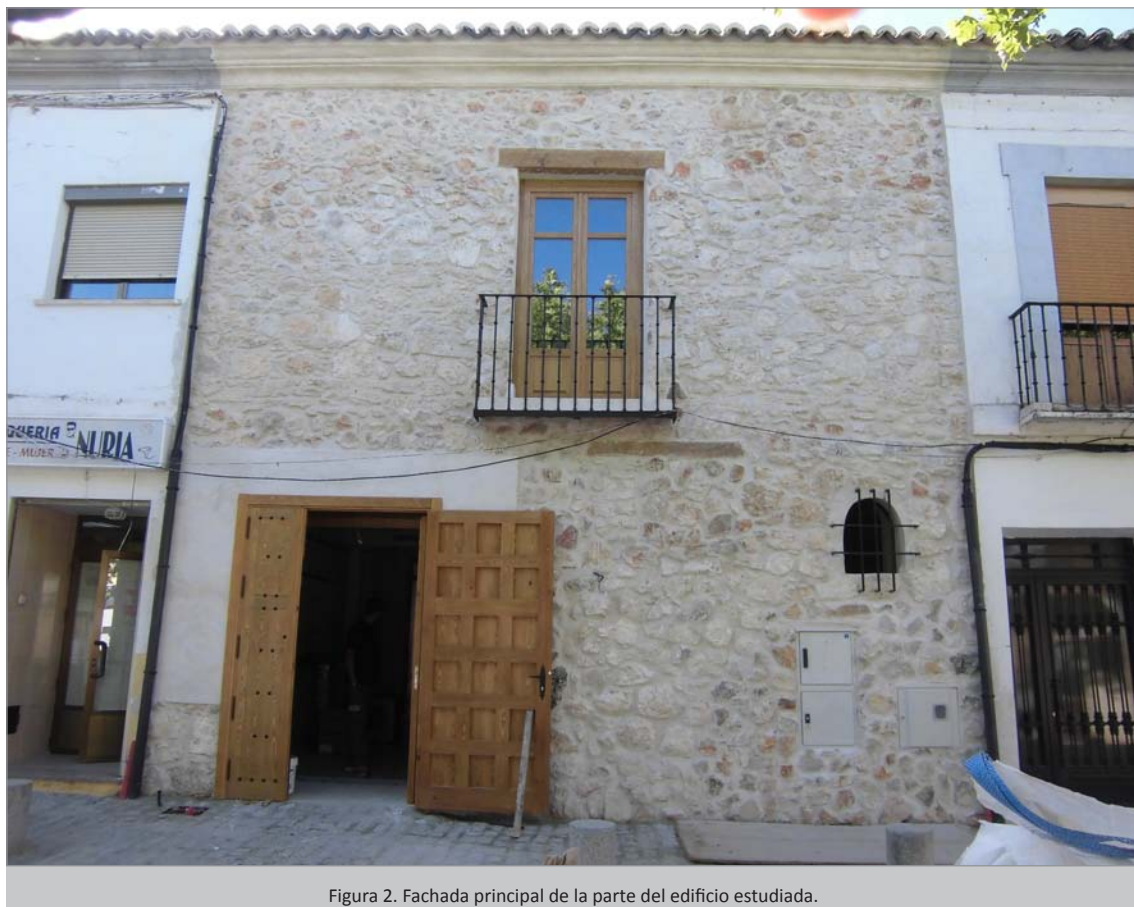
Figura 2. Fachada principal de la parte del edificio estudiada.
