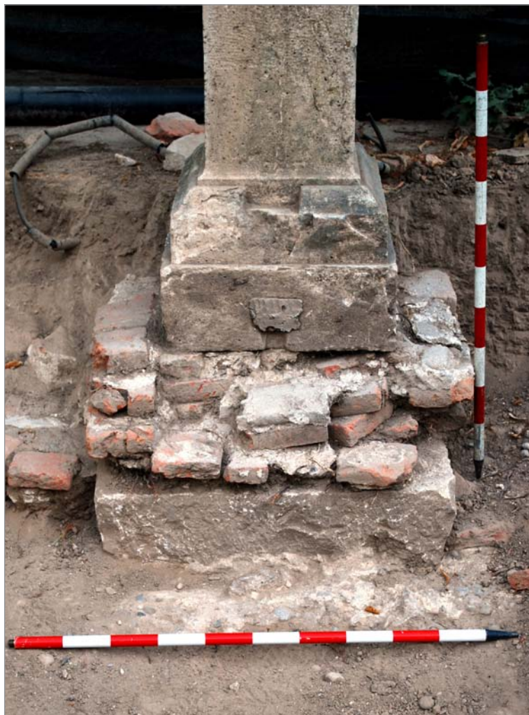
Figura 2. Ripios de ladrillo bajo una de las pilastras, para elevar su base en la misma proporción que la cota de uso del jardín.
