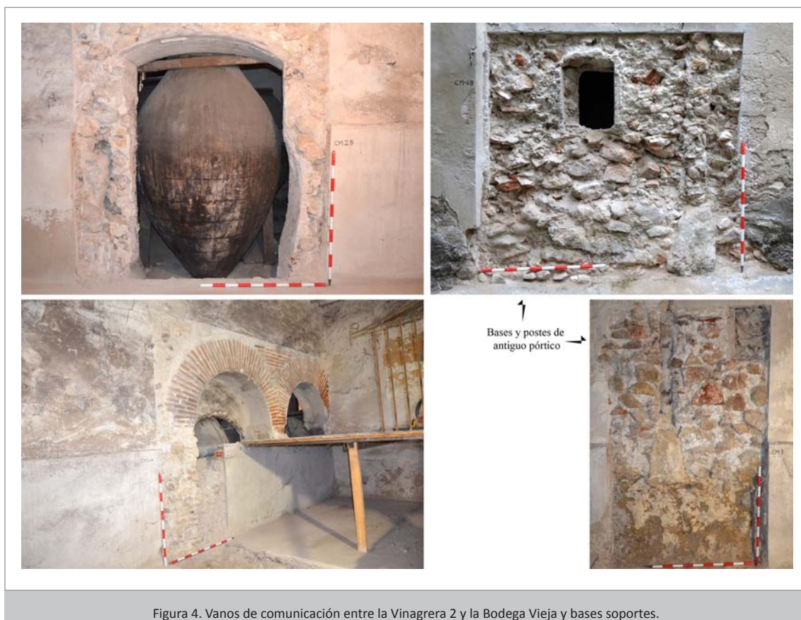
Figura 4. Vanos de comunicación entre la Vinagrera 2 y la Bodega Vieja y bases soportes.
