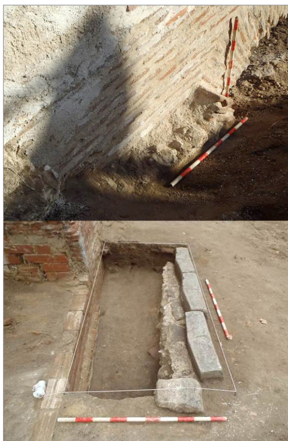
Figura 6. Labores de excavación arqueológica: engrosamiento original en la base de un pilar del acueducto y posterior rectificación (arriba); albardillas reutilizadas como topes para ruedas de carros de aguada (abajo).
