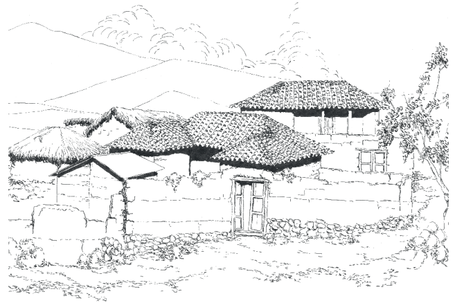
Imagen 03. Edificación con sistema constructivo de tapial.
