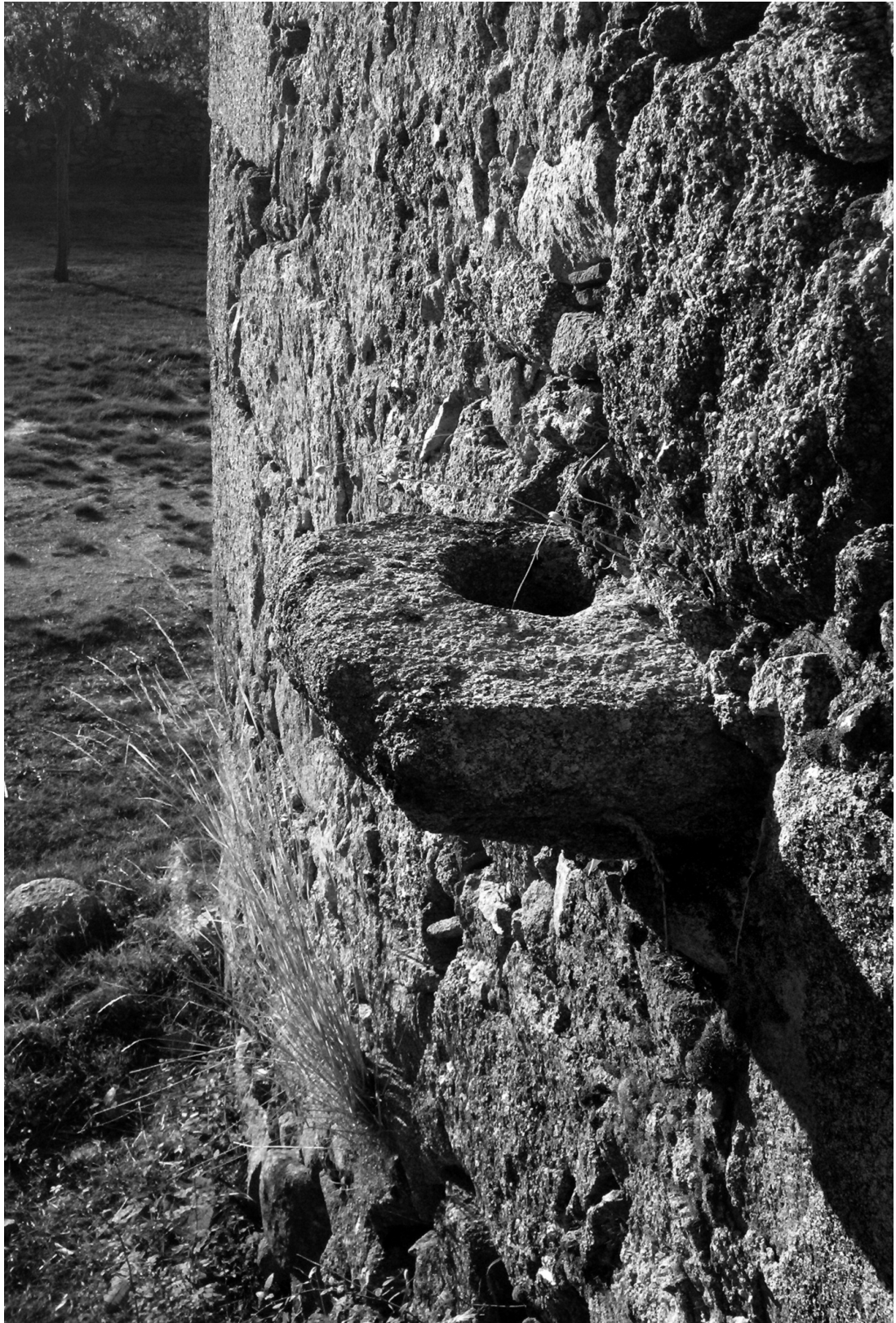
25. Soporte adosado al muro de la casa del santero.
