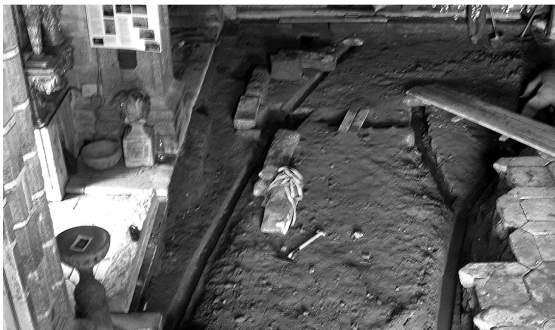
31. Obras de acondicionamiento de las canalizaciones subterráneas en N.ª S.ª de las Fuentes. (Fotografía cedida por J. F. Fabián García).
