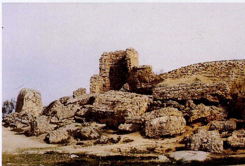
Fig. 8.4.- Sección central de la presa y restos de la torre de toma.
