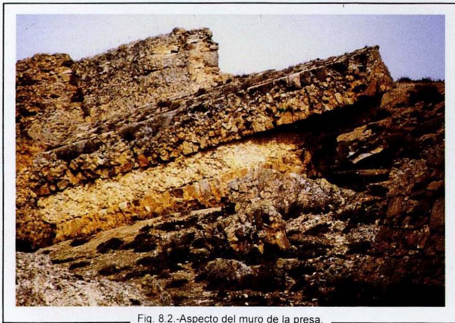
Fig. 8.2.-Aspecto del muro de la presa.
