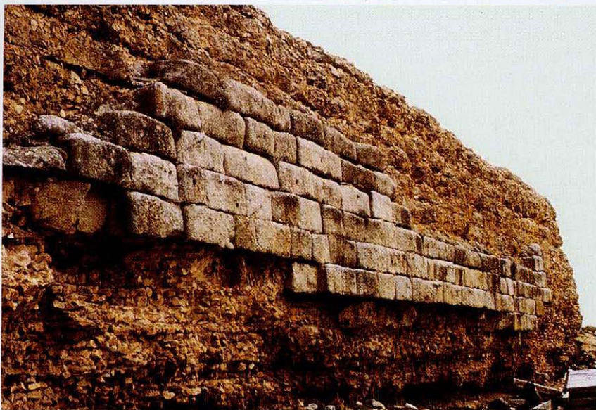
Fig. 8.3.-Aspecto del muro de la presa.
