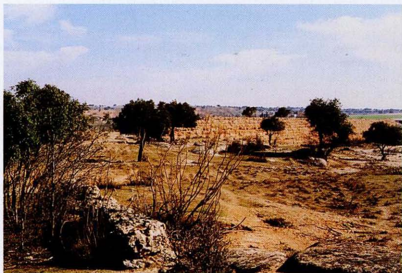
Fig. 8.8.-Tramo final del canal de derivación del Arroyo de San Martín, junto al estribo izquierdo de la presa de La Alcantarilla.
