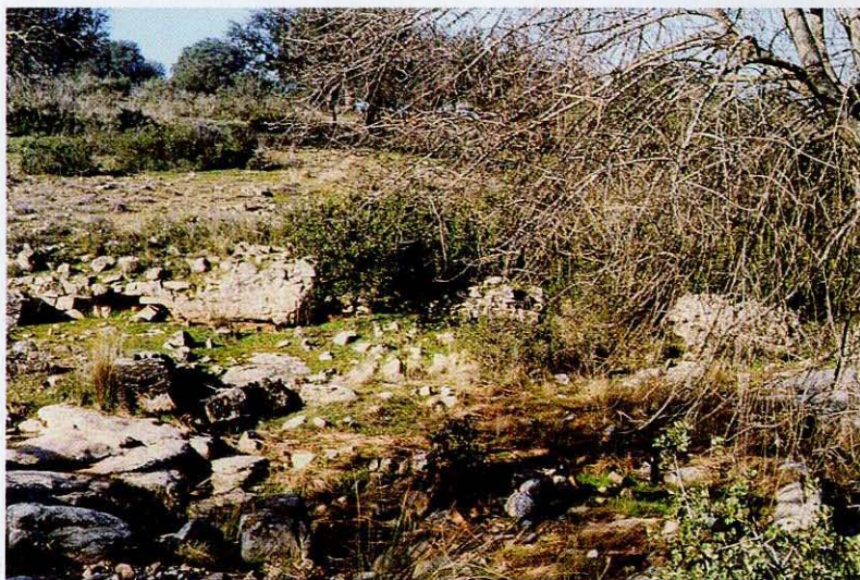
Fig. 8.6.-Presa de derivación en el arroyo de San Martín dela Montaña. Estribo izquierdo.
