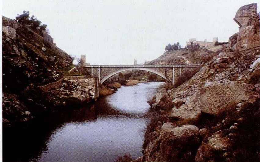
Fig. 8.37.- Zona del cauce del río por donde cruzaba el puente-acueducto.
