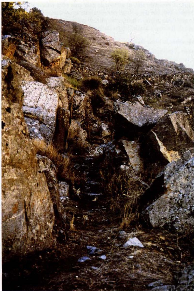
Fig. 8.42 .- Camino abierto para el paso de las tuberías del sifón.
