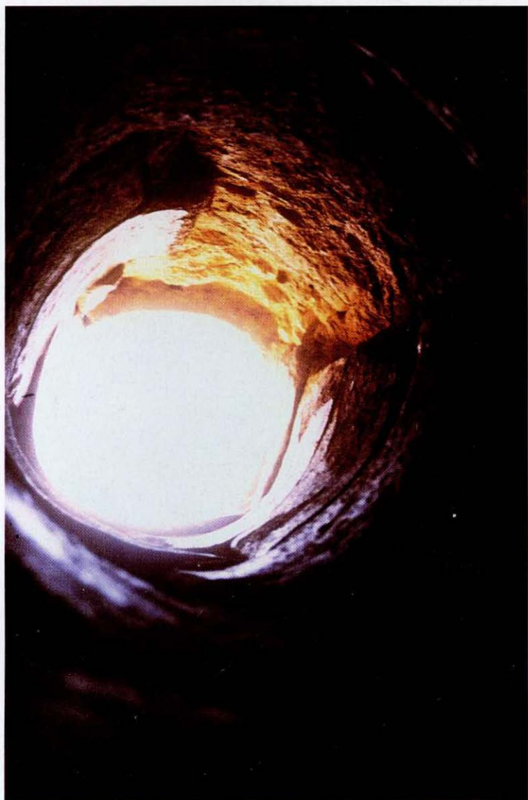
Fig. 8.22.- El conducto de caída visto desde la parte inferior de la torre.
