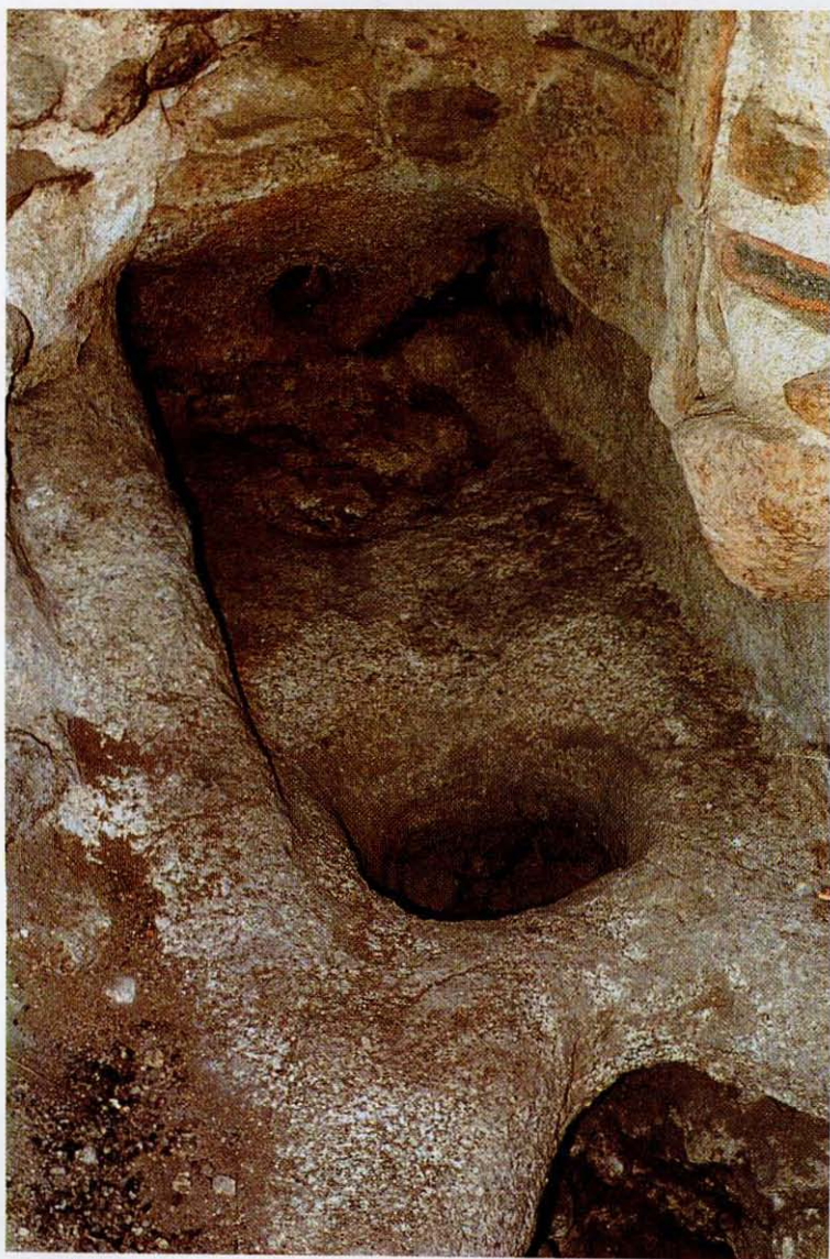
Fig. 8.24.- Arqueta inferior de la torre.
