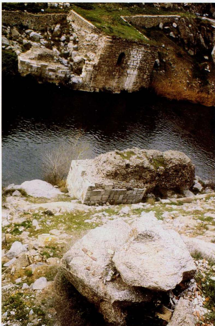
Fig. 8.41.- Resto del acueducto en la orilla derecha del río, a su lado la citada construcción medieval.
