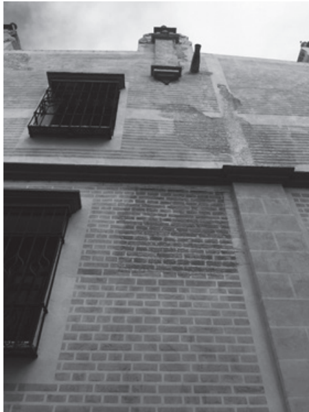
Fig. 5: Vista de la restauración de la fachada principal, respetando fragmentos del estado original. Visible la citada utilización de pintura para resaltar los componentes del revestimiento (Imagen de elaboración propia).1
