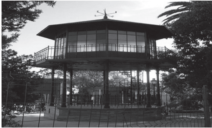
Fig. 11: Templete mirador restaurado (2009). Fuente: Ayuntamiento de Jerez.
