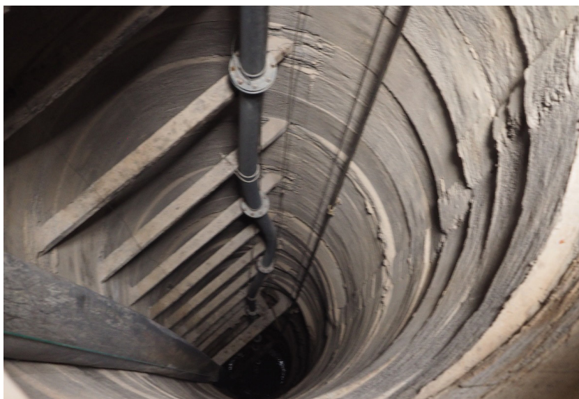
Figura 8. Revestimiento interior de un pozo canario. Fuente: Santamarta, J.C.
