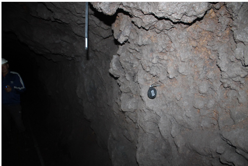
Figura 10. Detector pasivo colocado en una galería, en el techo se marca una señal con un reflectante. Fuente: Santamarta, J.C.
