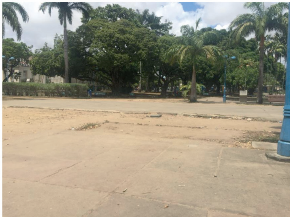
Figura 6 – Local sem piso acessível interligando setores e muito desnível
