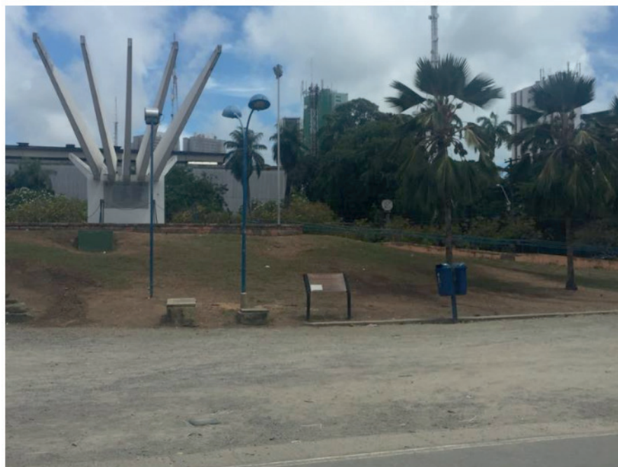
Figura 2 –Área do monumento com rampa lateral, sem identificação
