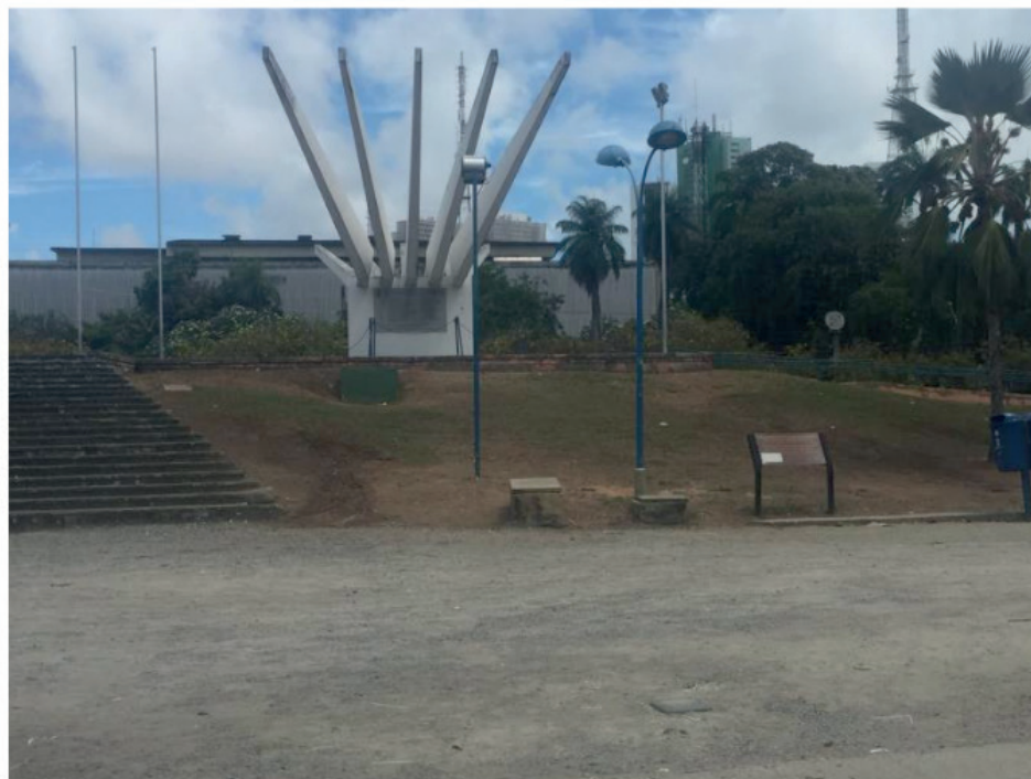
Figura 1 – Área do monumento sem proteção (guarda-corpo)
