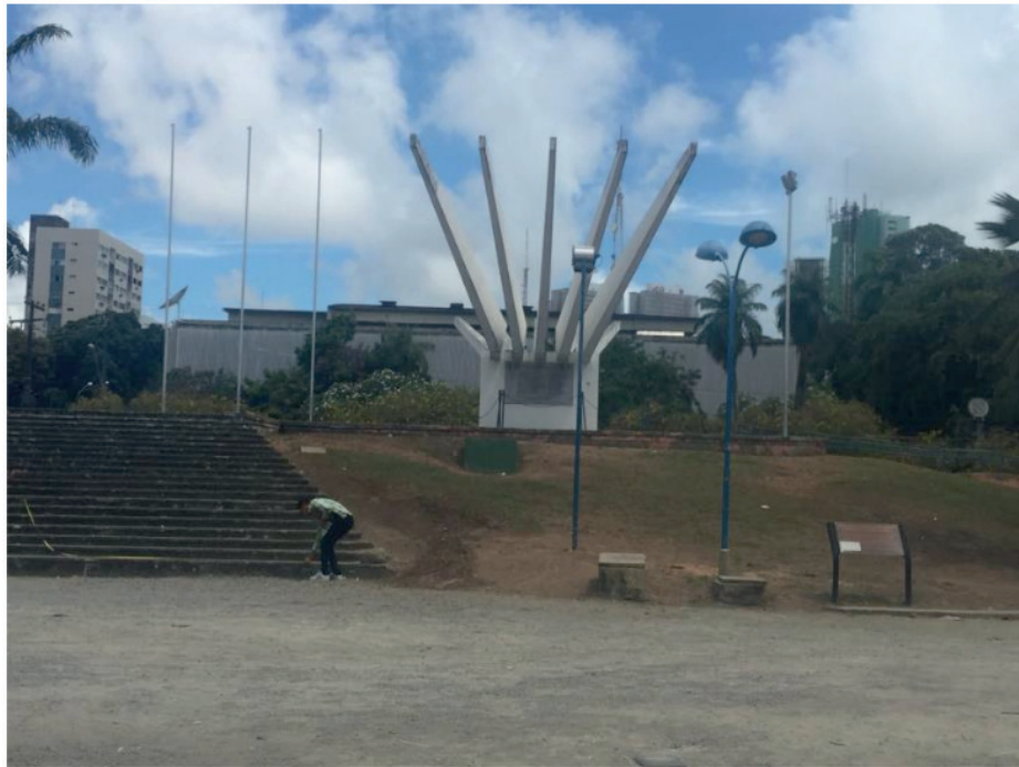
Figura 3 – Área do monumento – escadaria sem corrimão
