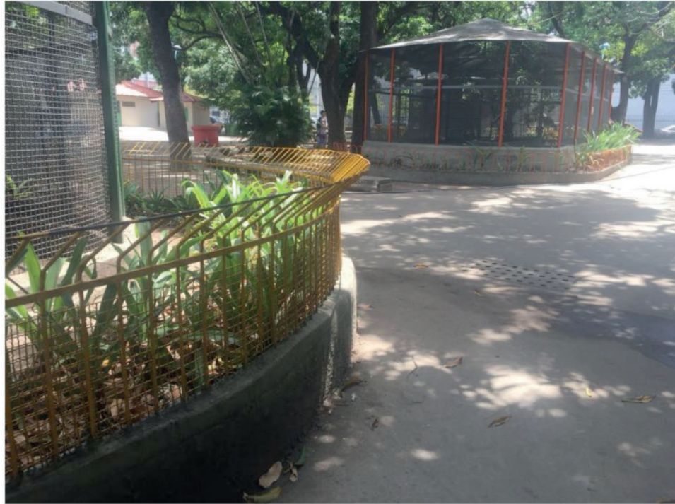
Figura 9 – Zoológico com desnível no piso e sem piso sinalizador para os locais das jaulas
