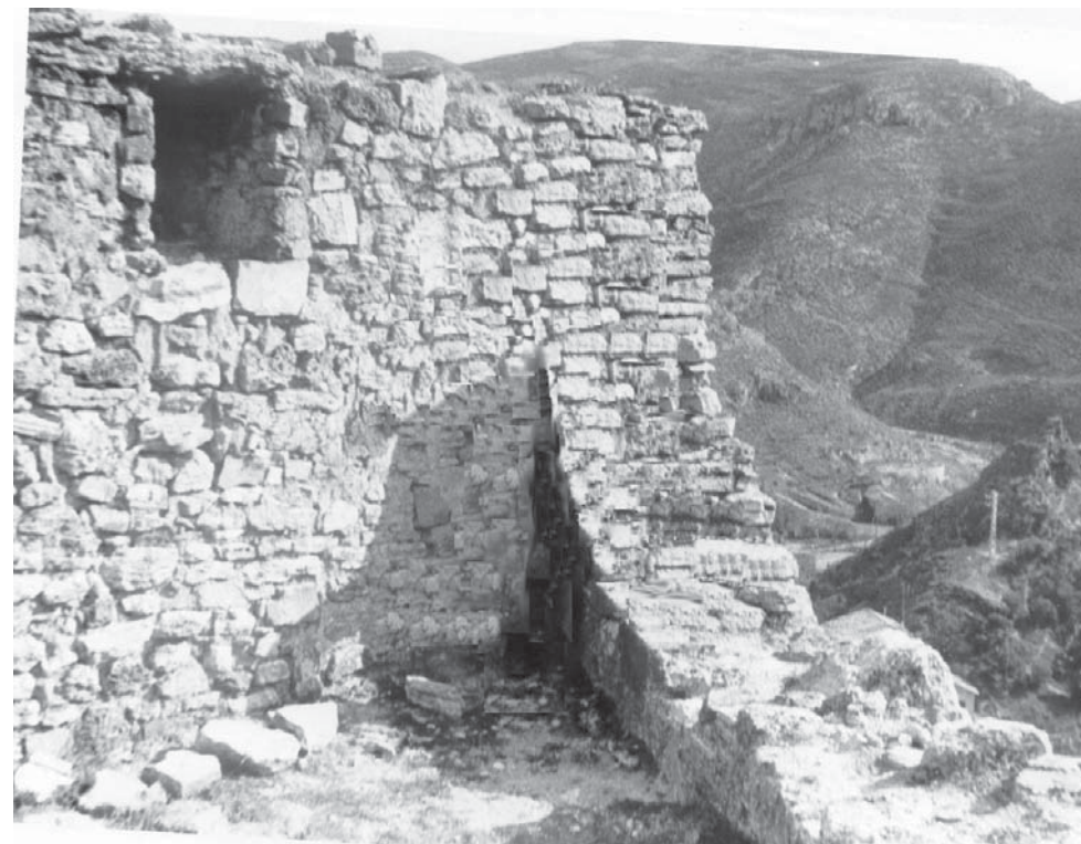
Aspillera y muros ruinosos
