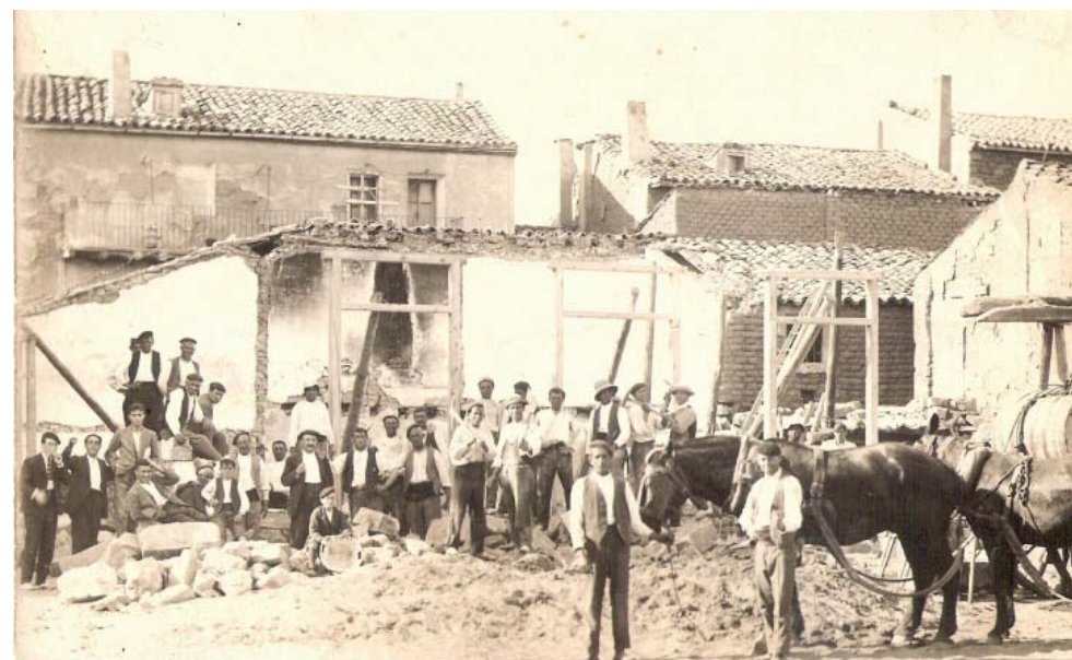
Construcción del Centro obrero
