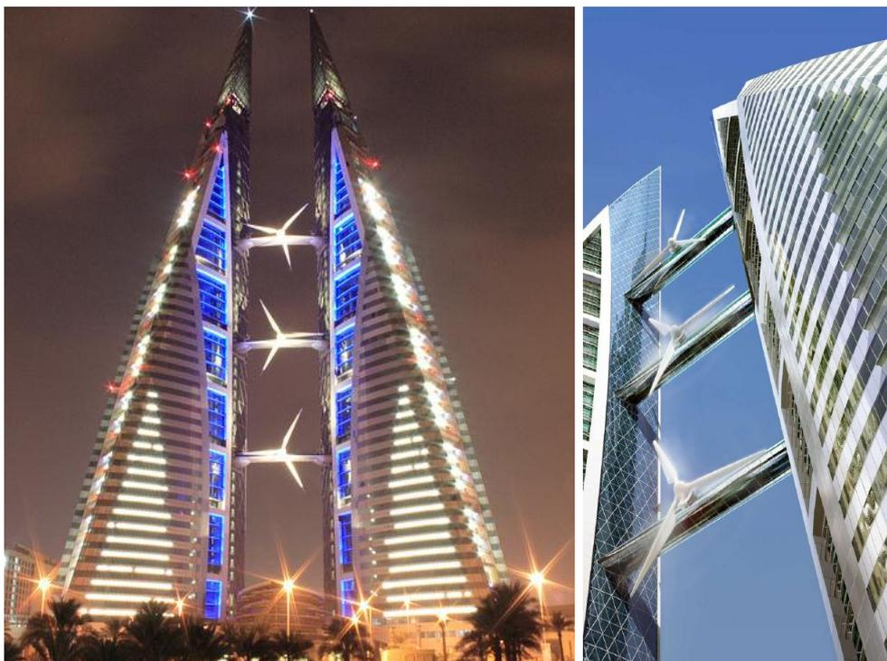
Fig. 1. Bahrain Trade Center con tres turbinas eólicas (3x225kW), desmontadas a los pocos meses de inauguración por ruido y vibraciones en los ambientes del edificio [4].
