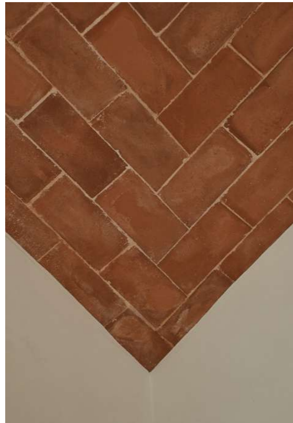
1. Detalle del arranque en esquina de una bóveda 2. Bóveda de pañuelo de 8 metros de luz en construcción
