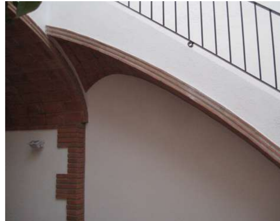
3. Apoyo de la bóveda de una escalera sobre otra bóveda de arco carpanel 4. Bóveda de escalera de pechina para un hotel en Barcelona 5. Bóveda para escalera
