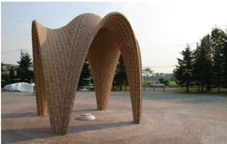
1 y 2. Construcción y estado final del pabellón frente al Museo de Cerámica de Ebetsu, Japón 3. Bóveda tabicada de olas
