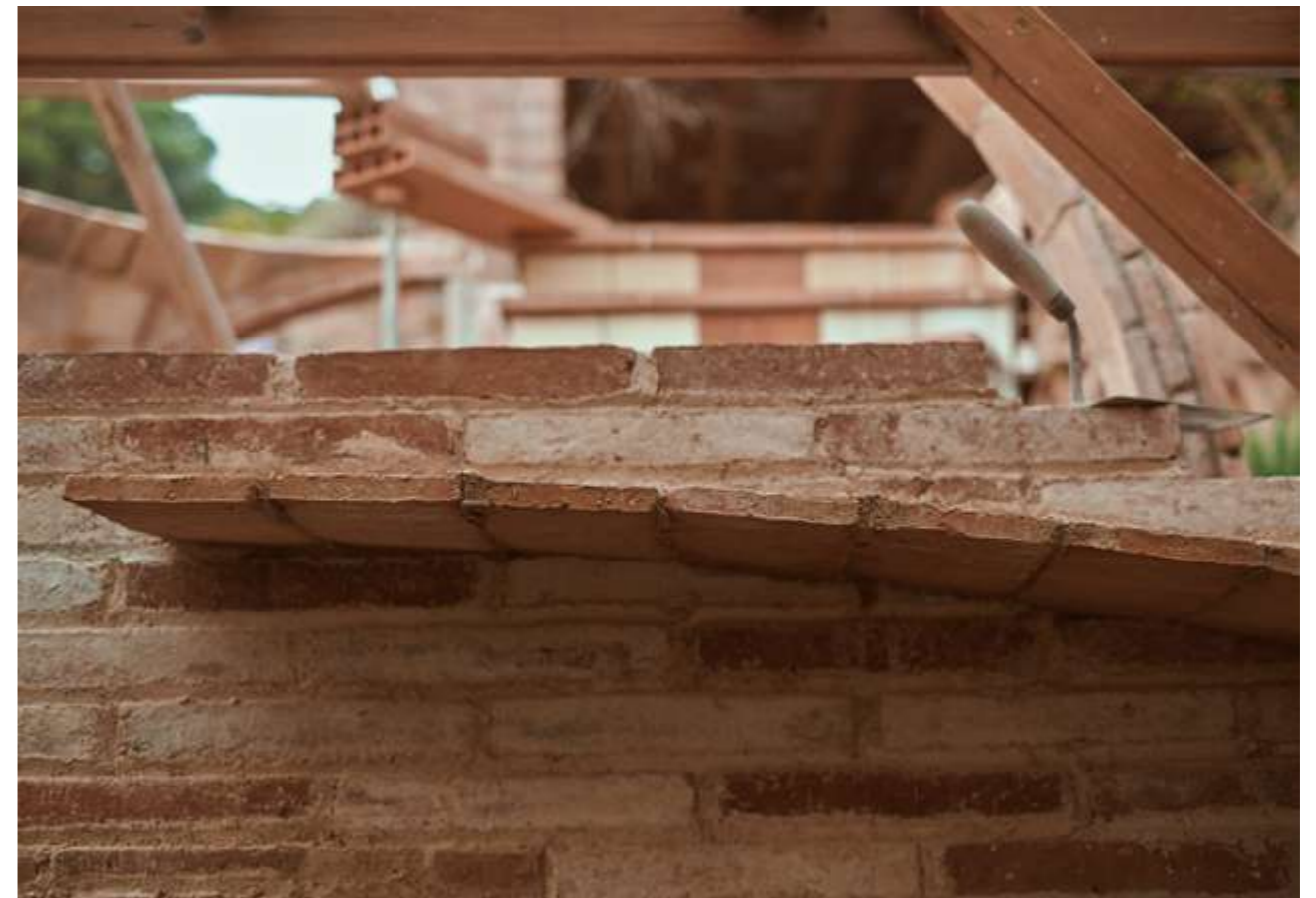
2. Ensayos de bóvedas en el taller del maestro albañil Ramón Guarda
