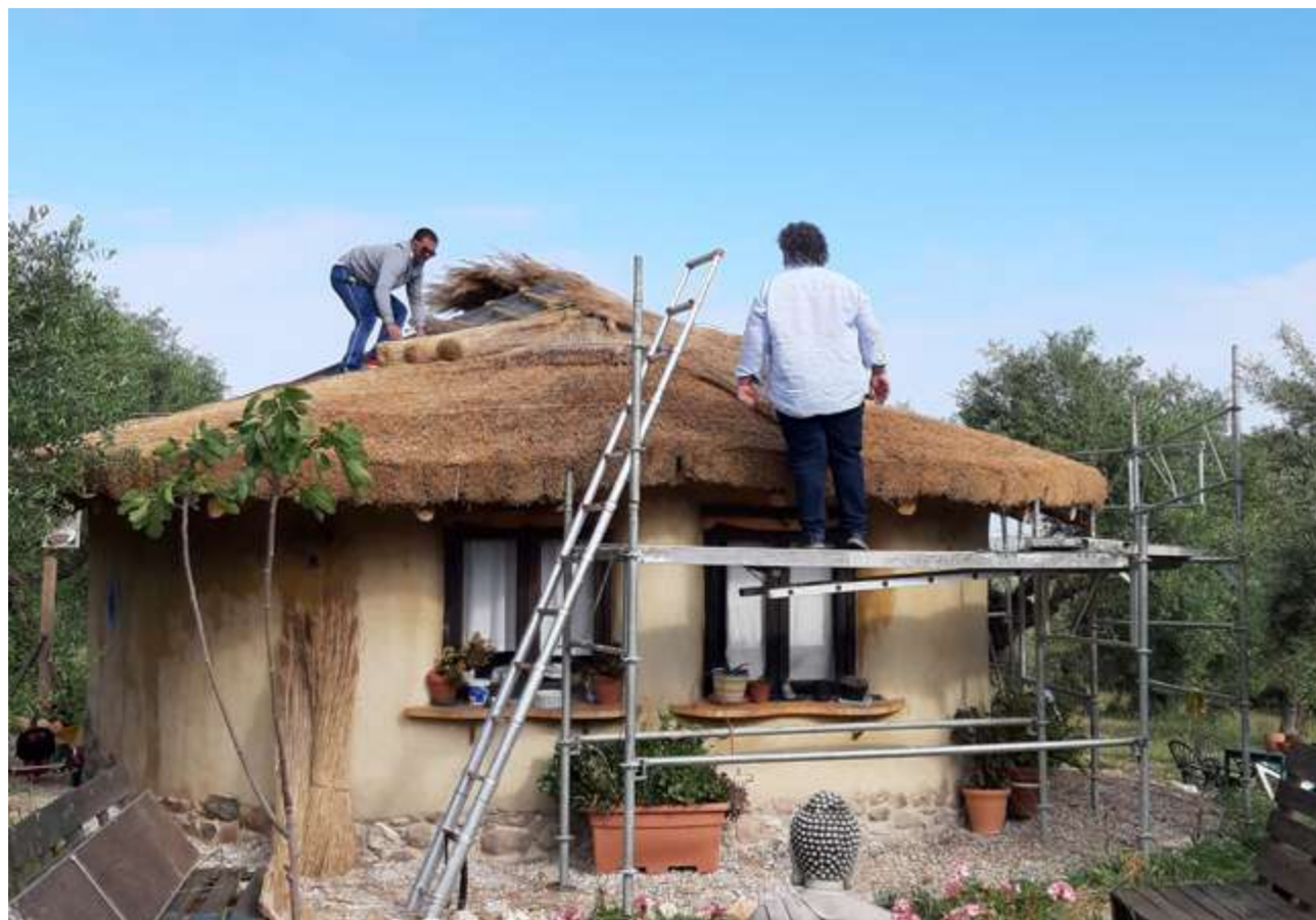
1 a 3. Proceso de colocación del pasto en la cubierta vegetal de una choza en Cádiz
