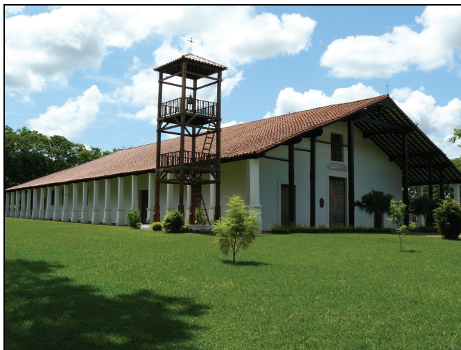
Corredor lateral y campanario - Yaguarón.
