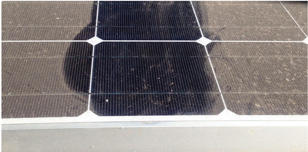
Figura 29. Suciedad visible en placas fotovoltaicas privadas de lluvia en Concepción, Chile.
