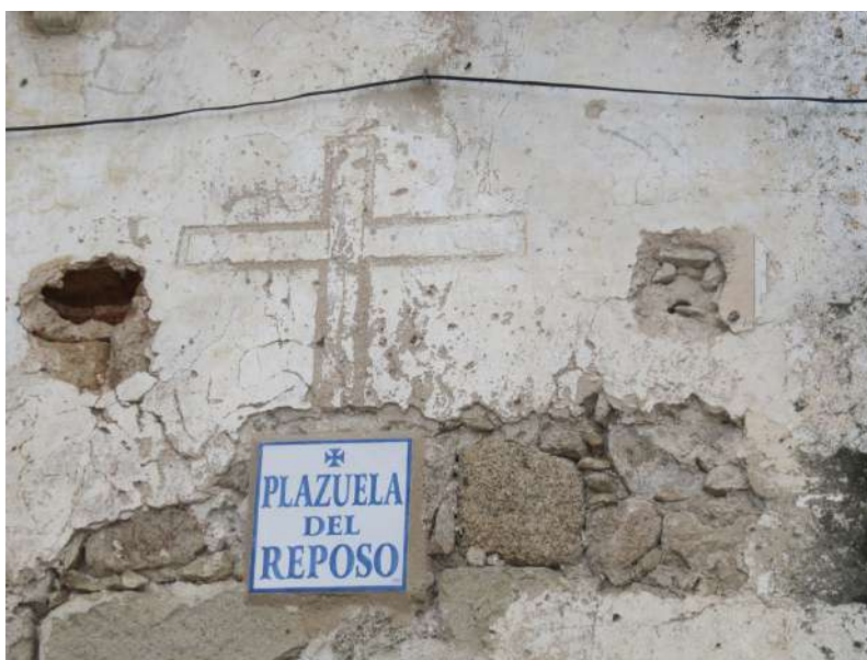
Esgrafiados, antes de su restauración.
