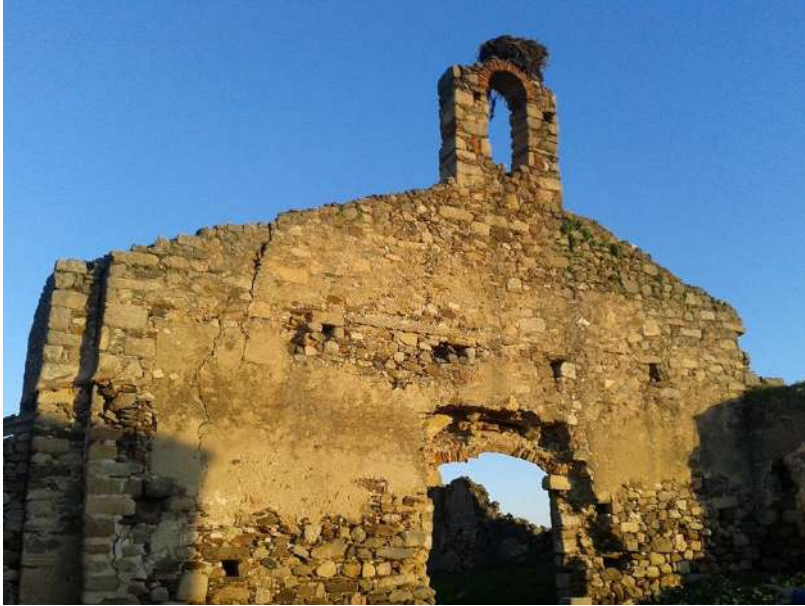
Detalle de la portada y espadaña.
