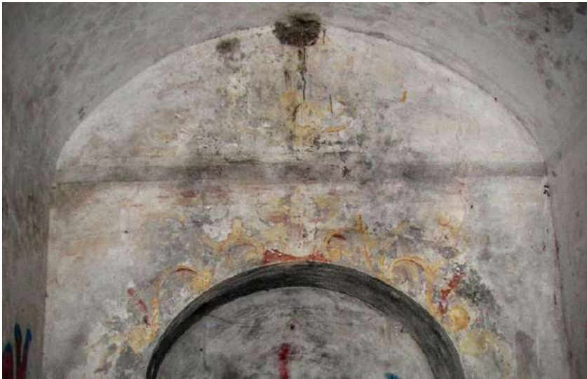
Restos de pintura mural.
