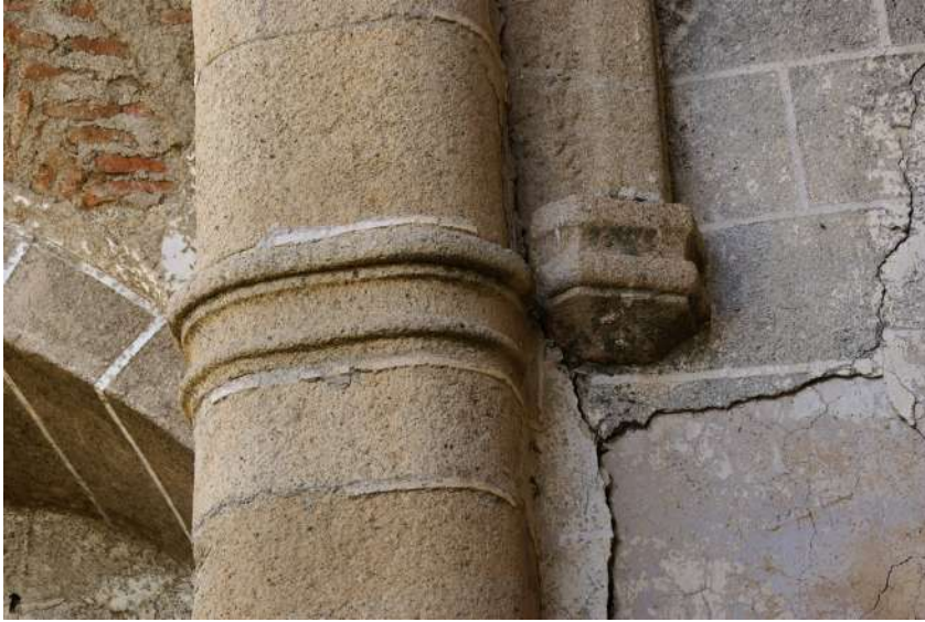
Detalle del arranque del arco triunfal.
