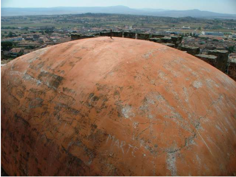
Detalle general de la bóveda.
