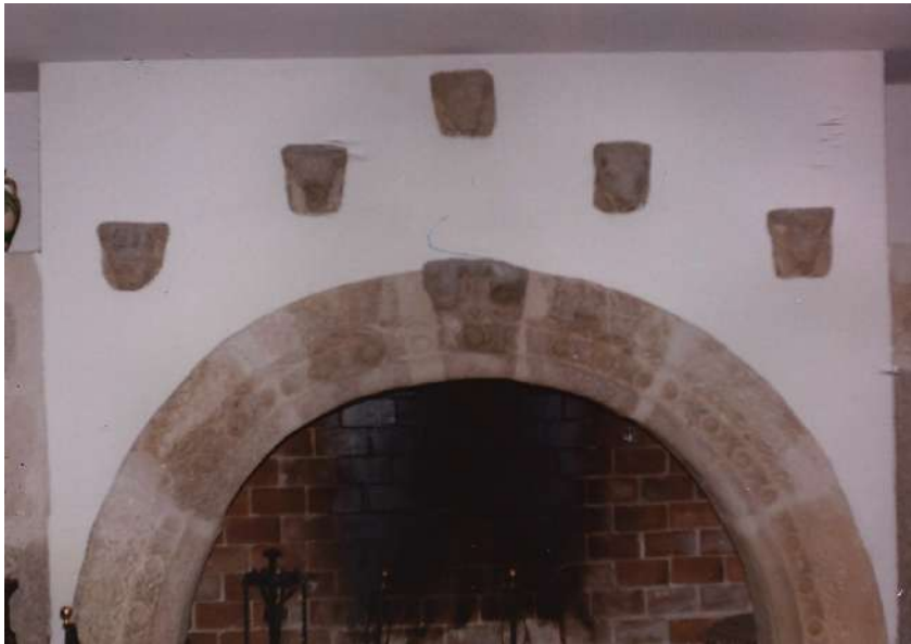
Detalle de la puerta de entrada a la ermita, actualmente sirve de chimenea en una vivienda
