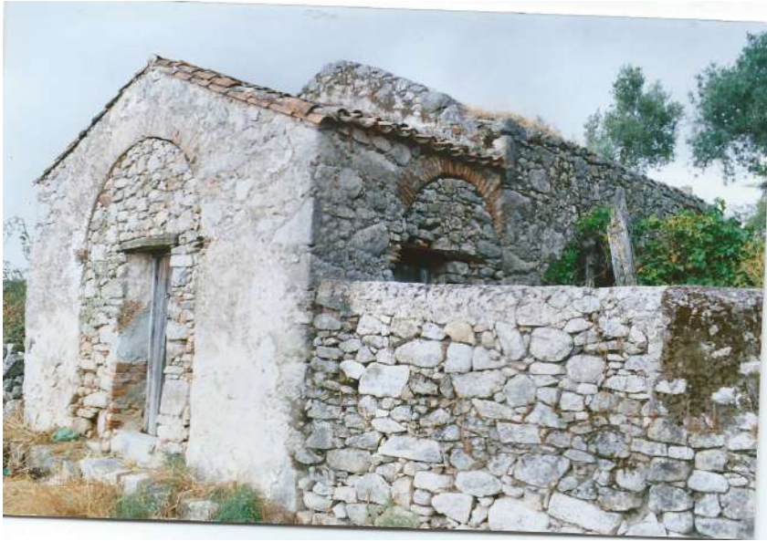
Detalle de la portada y fachada lateral.
