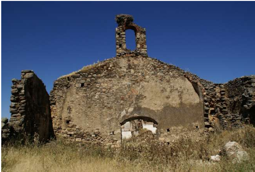
Interior del muro sur con portada y espadaña.
