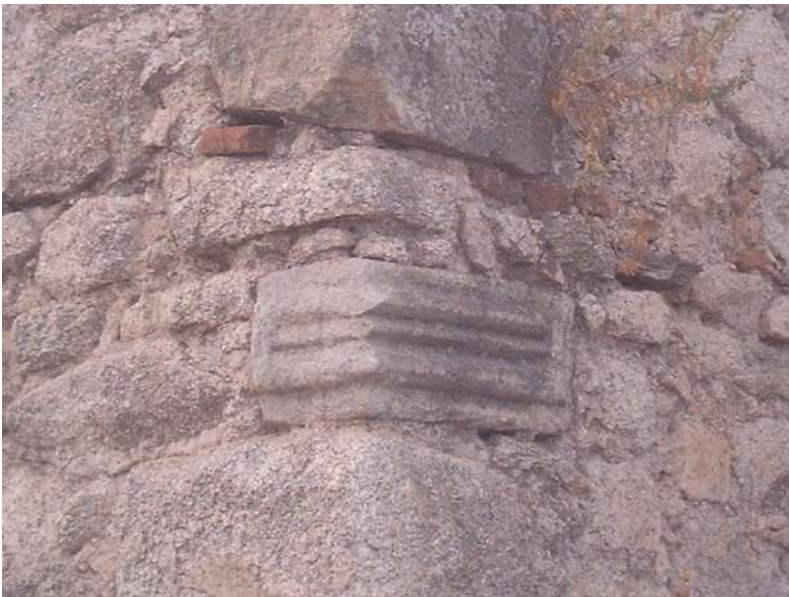
Detalle de un salmer de la ermita.
