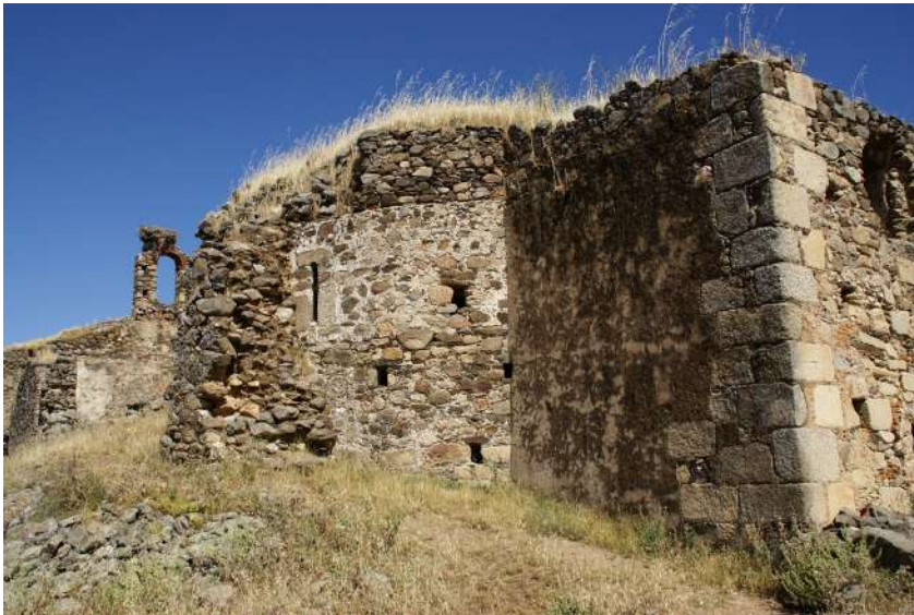
Ermita de mampostería y refuerzos de sillería.
