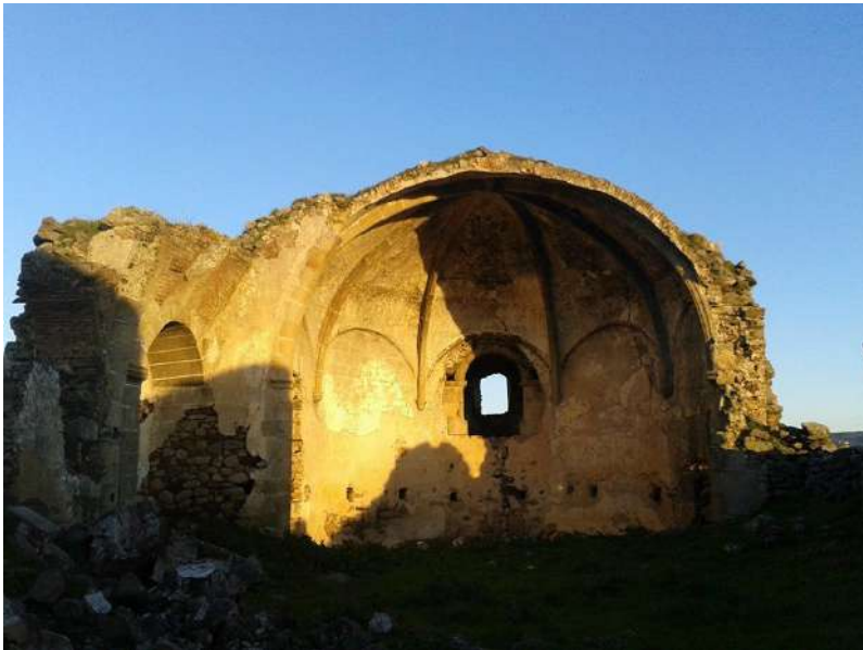
Nave, ábside y acceso a otras dependencias
