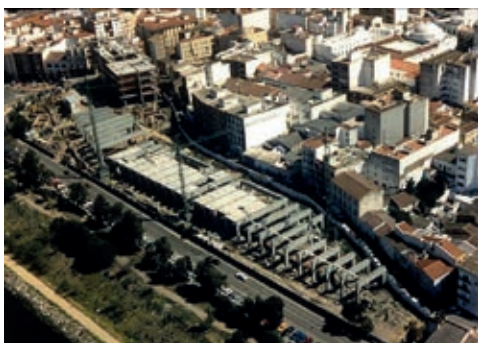
Vista aérea de la construcción de los edificios de Morerías.
