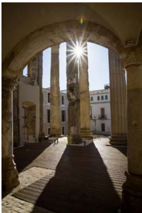
Rehabilitación del Palacio de los Corbos hecha por Rubén Cabecera.
