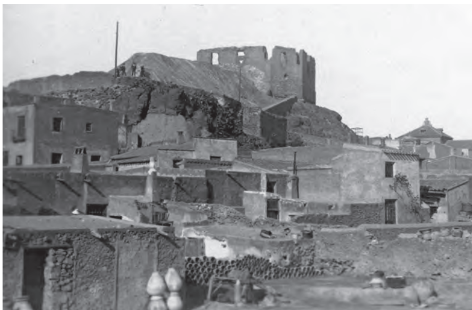
Castillo de los Vélez de Mazarrón. Vista por poniente de la fortaleza, desde donde se observa el patio de armas del castillo; observamos el muro de mampostería que cercaba el cementerio instalado allí mismo, a causa de la epidemia de fiebre amarilla del año 1810. Fotografía La Industrial Valenciana. Año de 1912
