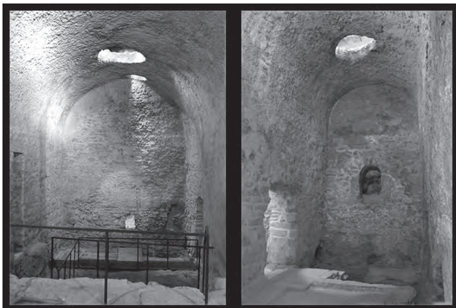
Figura 3. Salas Abovedadas, A y B, espacios salutíferos principales del Balneario de Alhama de Murcia. Fueron construidas en el siglo I d. C., reutilizadas en el mundo islámico y remodeladas durante la construcción del Balneario Hotel del año 1848.
