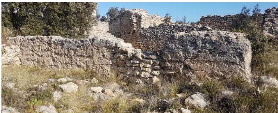
Fig.4. Realizada por María Paz Sanz. Vemos un ejemplo del tapial con mortero de cal, de l'Atzuvietta. Grupo de viviendas IV solo se encuentra en este grupo y en el grupo V, tapial de mortero de cal sin mampuestos.
