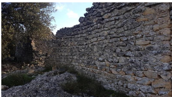
Fig. 9. Realizada por María Paz Sanz. Vista de una de las paredes exteriores del primer grupo de casas. Construida con mampostería a hiladas con mortero de cal y sin cimientos, ya que esta la pared apoyada directamente sobre la roca madre. Se encuentra en l'Atzavieta en el grupo III, parte Norte, son hiladas horizontales.
