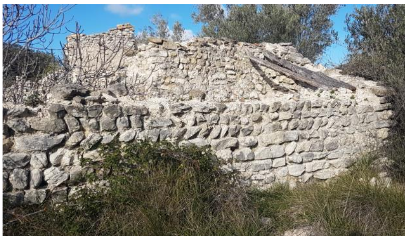
Fig. 8. Realizada por María Paz Sanz. Ejemplo de mampostería a hiladas horizontales de la Roca. Se encuentra en la primera vivienda. Encontramos hiladas horizontales en la parte inferior de la imagen y en las hiladas superiores observamos hiladas de opus spicatum .
