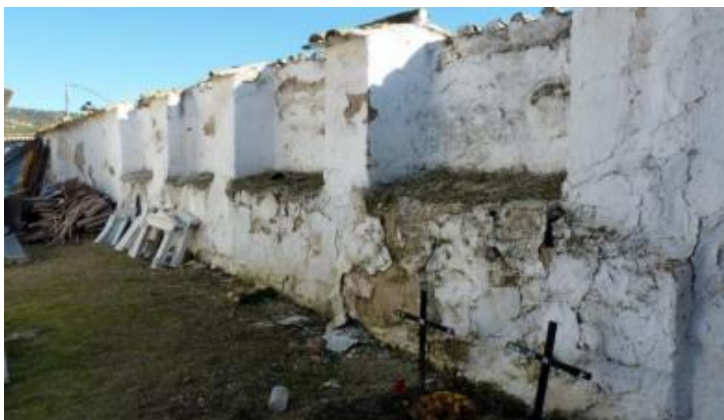
Fig. 2. restos arquitectónicos conservados en el sector sureste del actual cementerio.
