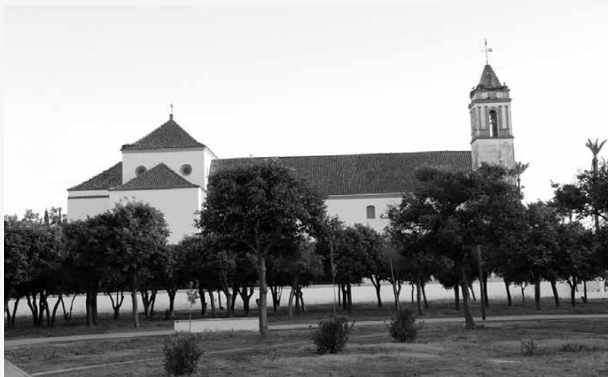
Fig34 Santuario, en la actualidad, después de la restauración de los tejados y la torre
