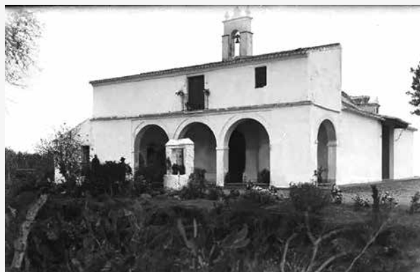
Vista general de la Ermita de Consolación (Cartaya) hacia 1930 (Foto: colección de Gonzalo Navarro Ambrojo)
