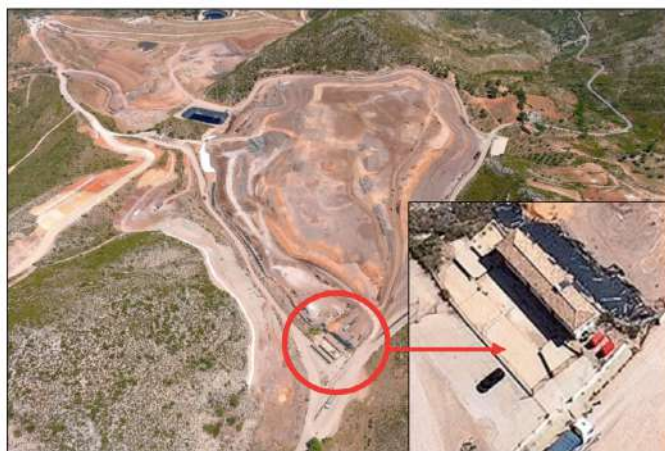
Figura 2. Planta de eliminación de RNP y edificio de control.
