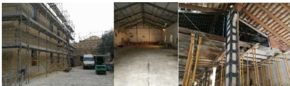
Figure 1. Valencia, Aceitera de Marxalenes, XVIII secolo, vista del cortile comune alla biblioteca municipale e alle naves; viste interne del magazzino e dei laboratori, in fase di riqualificazione
