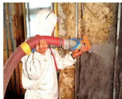
Figura 1. Panelado de la pared sobre el aislante Figura 2. Proyección mediante celulosa
