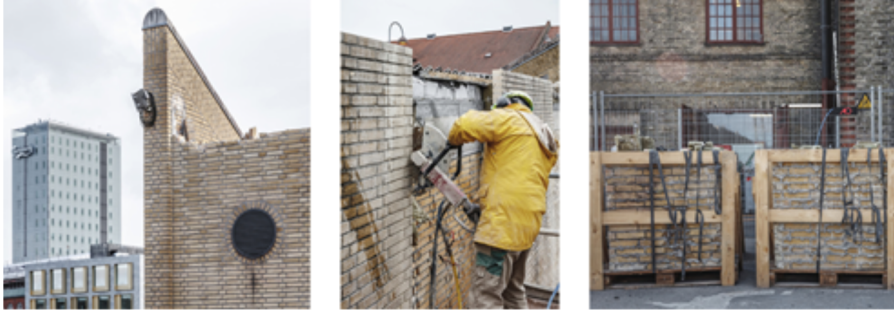
Figure 3. Operazione di taglio dei paramenti murari delle Birrerie Carlsberg, Copenhagen, confluiti nella facciata del Resource Rows. Source: https://architectsjournal.co.uk/
