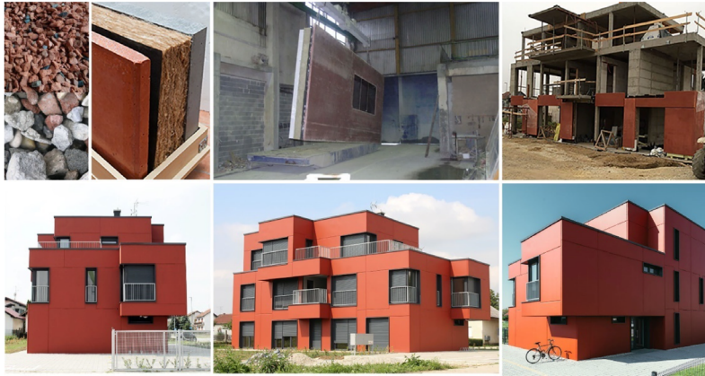
Figure 2. Riqualficazione del quartiere Lenišće a Koprivnica (Croazia) attraverso la realizzazione di dodici edifici plurifamiliari con rivestimento in ECO-SANDWICH®.
