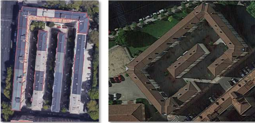
Figura 13. Vista cenital de las viviendas para empleados de RENFE en Madrid-Delicias (izq.) y Miranda de Ebro (der.), construidas a principios de la década de 1950.
