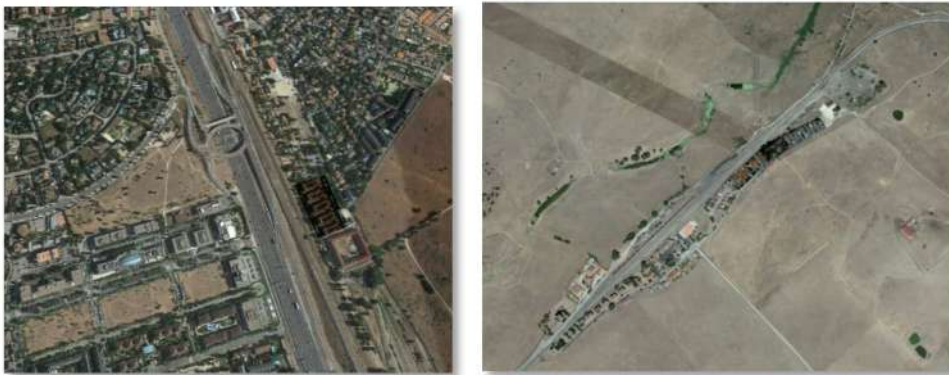
Figura 35. Ejemplos de construcción de viviendas junto a las vías de ferrocarril (Las Matas, Madrid; y Arroyo-Malpartida, Cáceres).
