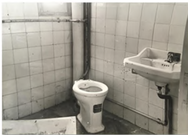
Figura 23. Aseo de las viviendas de RENFE en Vilanova i la Geltrú (1964).
