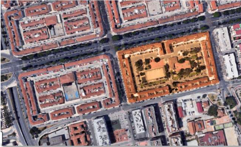
Figura 32. Vista cenital del conjunto de 306 viviendas de RENFE de “El fuerte” en Málaga.
