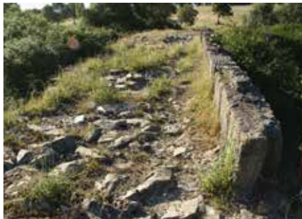
Calzada y pretil.
