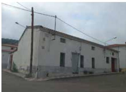
Viviendas tradicionales en calle Murcia.
