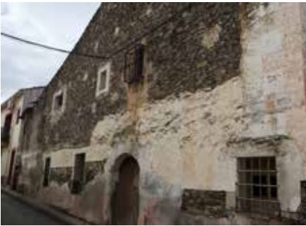
Vivienda de mampostería de pizarra.
