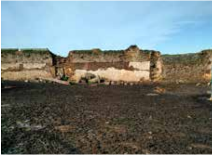
Deplorable estado del cortijo.
