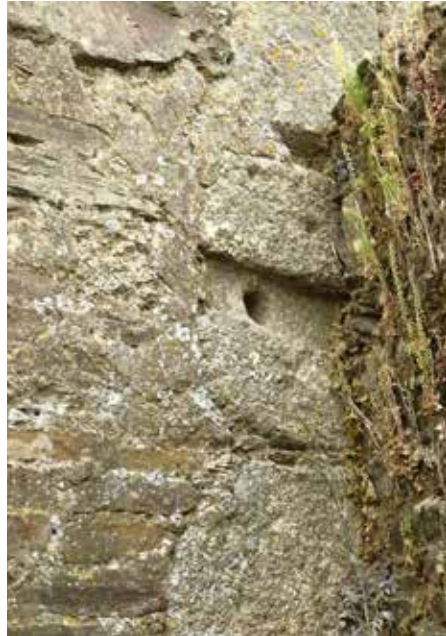
Contrapeso empotrado en el ábside.
