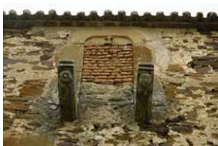
Restos del matacán con ménsulas ornamentadas.
