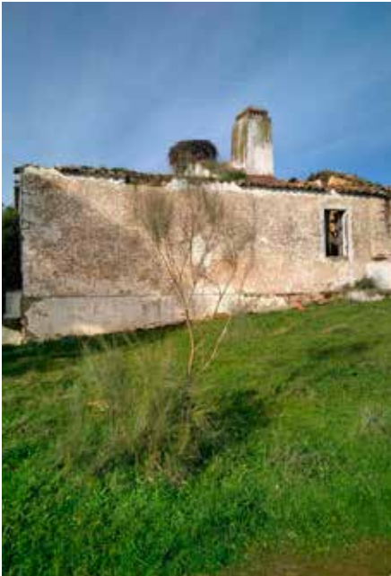
Chimenea y paramentos.
