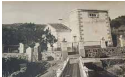
Depósito de agua (foto Ángeles Campos).
