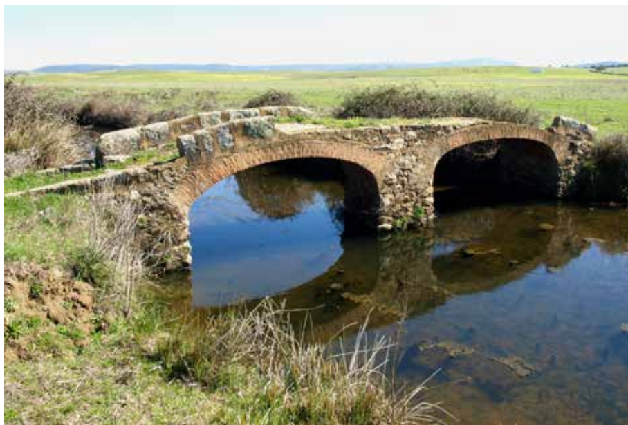
Puente, entre Cañada Real y carretera de Guadalupe.
