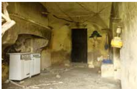
Una de las dependencias con chimenea.
