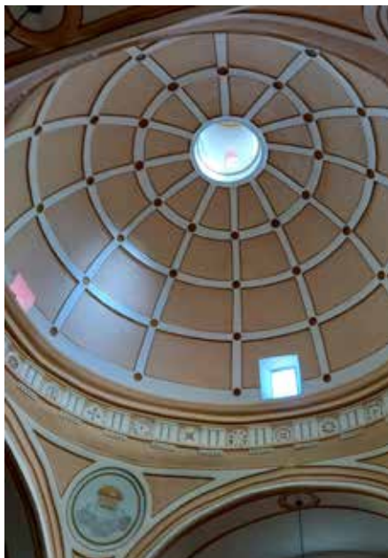
Elevándose sobre el crucero una cúpula semiesférica sobre pechinas.
