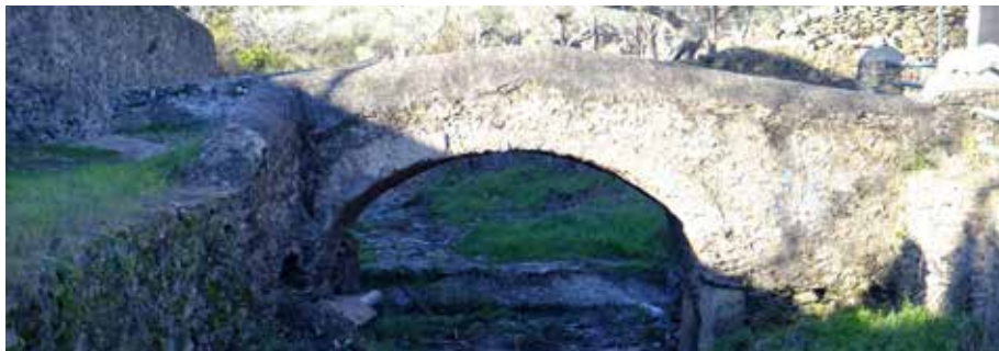
Puente sobre el arroyo Horrillo.
