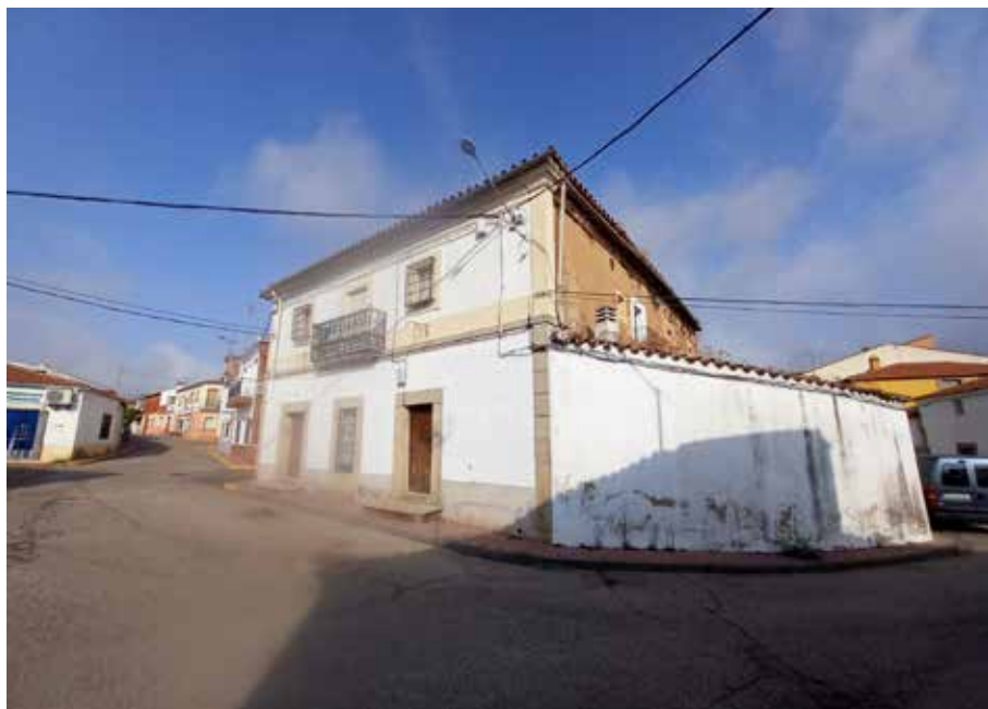
Vivienda en Plaza de Portugal.
