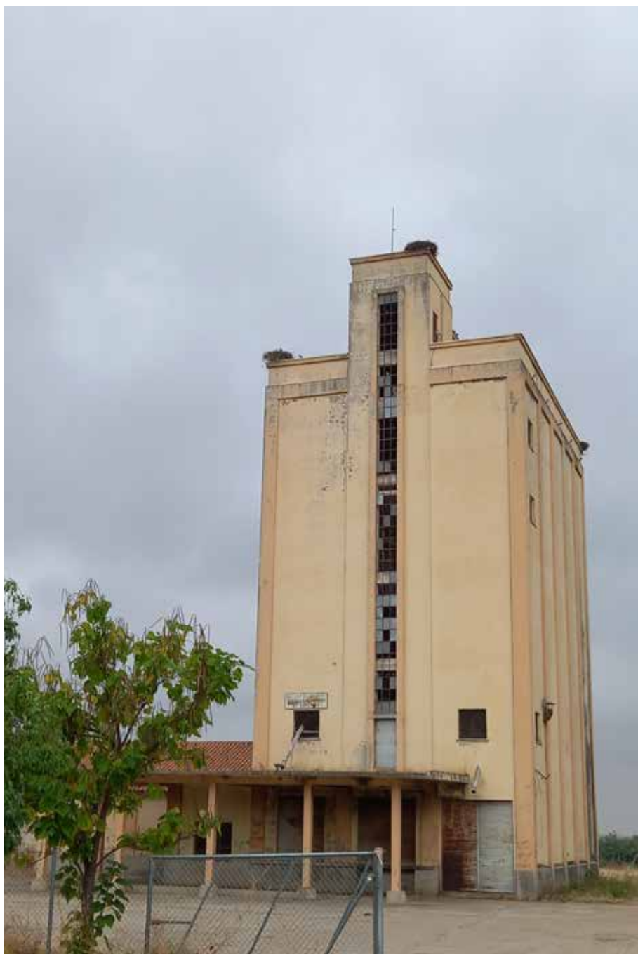
Silo de granos construido en 1969
