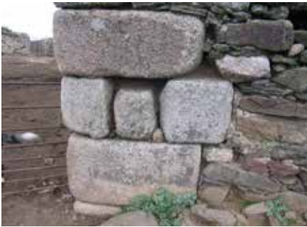
Aparejo de construcción a soga y tizó.
