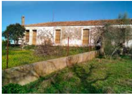
Detalle de la fachada.
